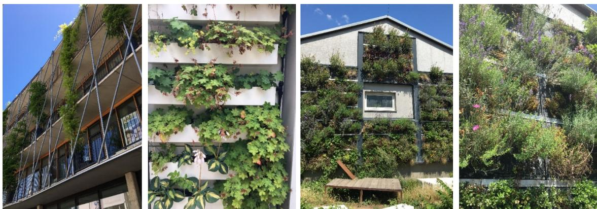
*Abbildung 4. Wandgebundene Vertikalbegrünung (von links nach rechts): Bild 1: punktueller, teilflächiger Vegetationskörper, SOHO Innsbruck (eigene Aufnahme 2020), Bild 2: linearer teilflächiger Vegetationskörper, Kempelenpark Wien (eigene Aufnahme 2020), Bild 3 + 4: vollflächiger, modularer Vegetationsträger, Kempelenpark Wien (eigene Aufnahme 2020)*
