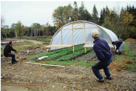
**Abb. 18:** Klappbare Giebelseite an einem kleinen Folientunnel.
