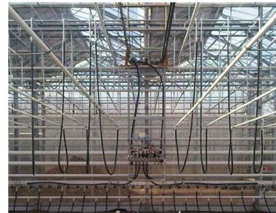
**Abb. 22:** Heb- und senkbare Heizung der Rainer Dietrich GmbH. Quelle: [gewaechshausbeheizung.de](http://gewaechshausbeheizung.de) (2021)
