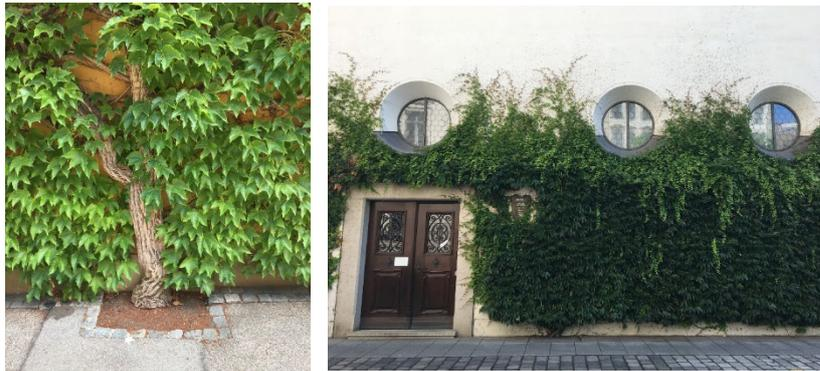
**Abb. 5: bodengebundene Vertikalbegrünung mit Selbstklimmer**
