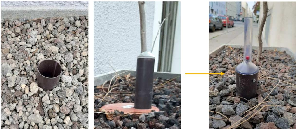
Abb. 40: Standort Kudlichgasse 14, beschädigte Wasserstandsanzeigen (links + Mitte), verschraubte Abdeckhülse (rechts).
