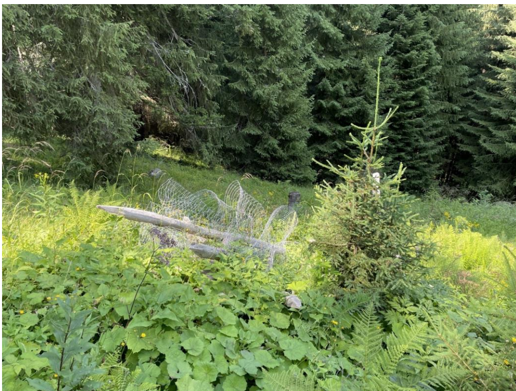
Abb. 44: Durch Lawine komplett zerstörter Zaun (Schwandwald bei Bach)
