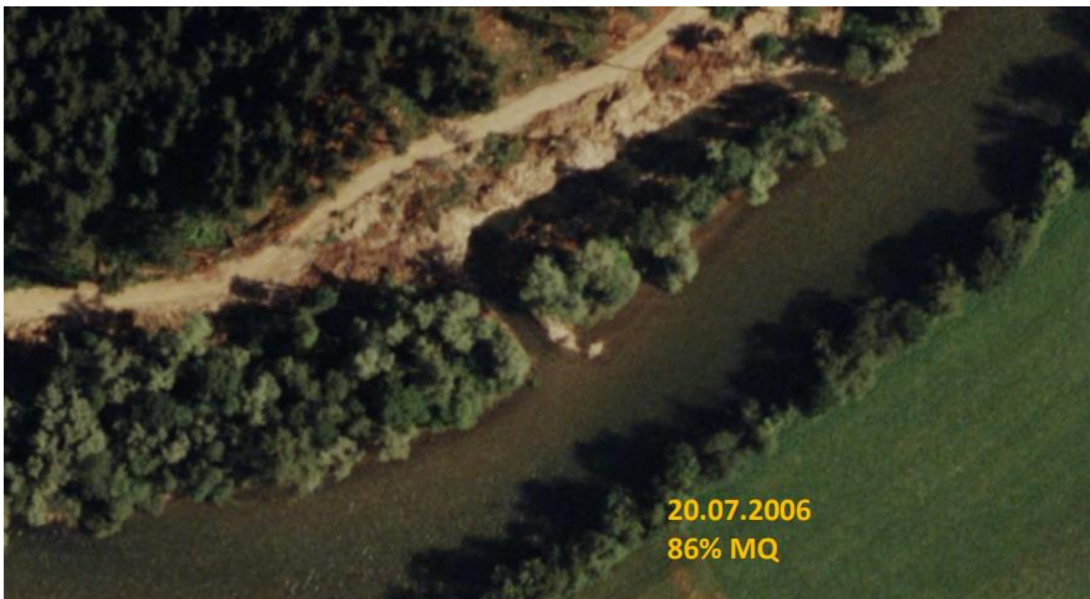
Abbildung 12: Luftaufnahme der LIFE+ Maßnahme „Weyern 2“ 2006; aufgenommen am 20.07.2006, bei 86% des langjährigen mittleren Abflusses (Google Earth, Pegelmessstelle Zeltweg)
