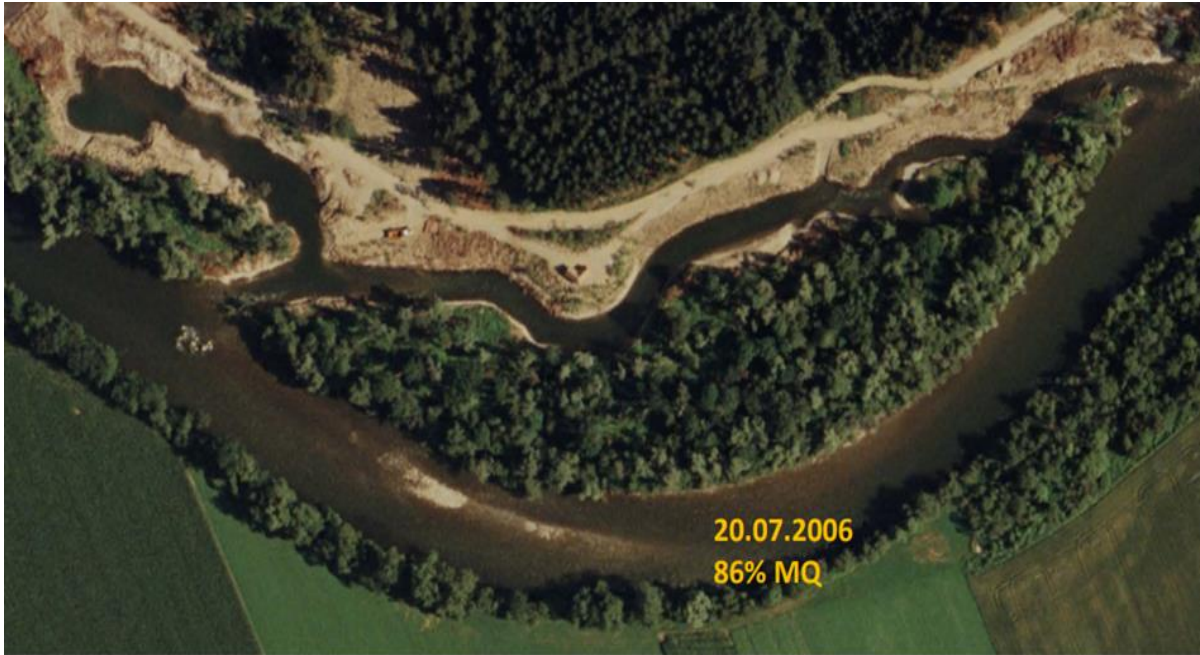
Abbildung 11: Luftaufnahme der LIFE+ Maßnahme „Weyern 1“; aufgenommen am 20.07.2006, bei 86% des langjährigen mittleren Abflusses (Google Earth, Pegelmessstelle Zeltweg)
