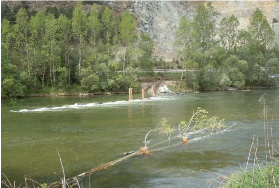
Abbildung 19: Strukturierungsmaßnahmen in der Mur bei Preg ( www.murerleben.at )
