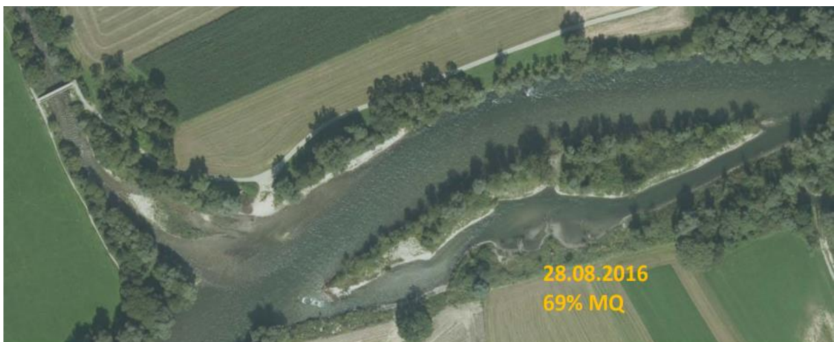
Abbildung 14: Luftaufnahme bei Apfelberg nach Fertigstellung der LIFE- Maßnahme 2016; Zubringer links im Bild: Ingeringbach; aufgenommen am 28.08.2016, bei 69% des langjährigen mittleren Abflusses (Google Earth, Pegelmessstelle Zeltweg)
