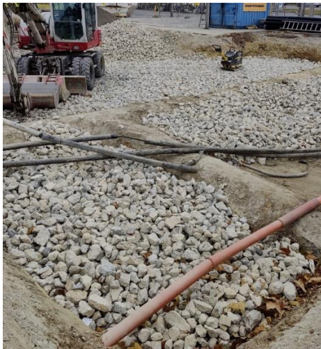
Abbildung 14: Einschichtig ausgebrachter Grobschlag
