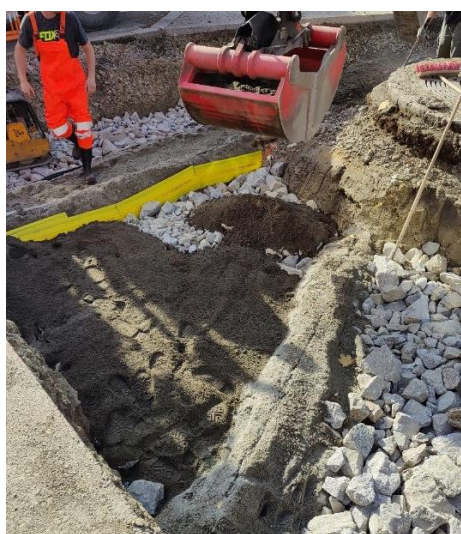
Abbildung 16: Aufbringen des Feinsubstrats auf die erste verdichtete Grobschlagschicht
