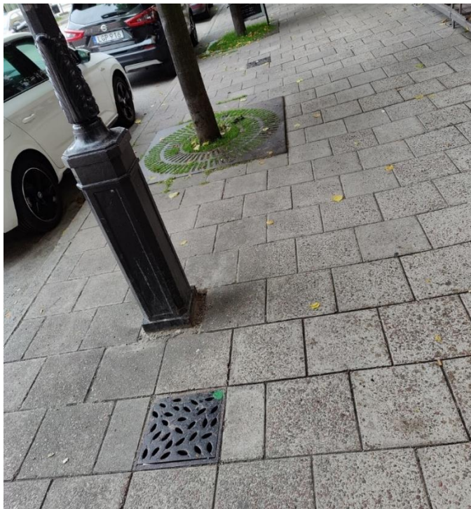
Abbildung 8: Einlaufschächte zwischen Baumscheiben in Stockholm
