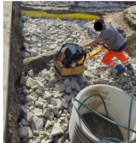
Abbildung 15: Verdichtung des Grobschlags mittels Rüttelplatte
