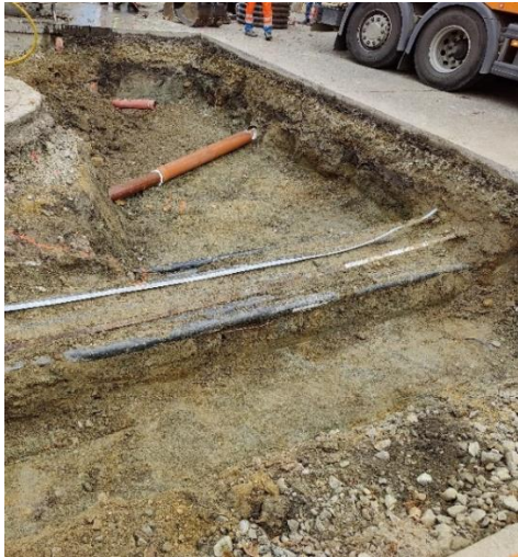
Abbildung 12: Aushub der Pflanzgrube
