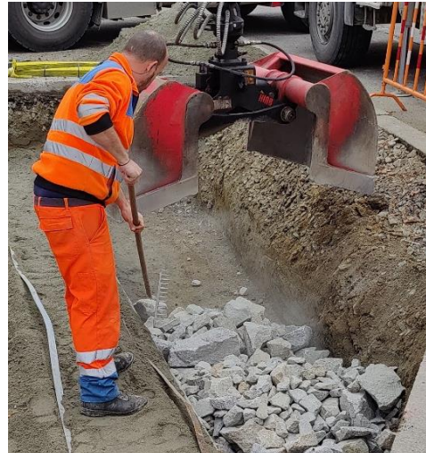
Abbildung 13: Einbringen des Grobschlags
