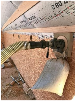
Abbildung 3: Einblasprozess einer Strohdämmung in den Zwischenraum (Bernadette Redl, 2019)
