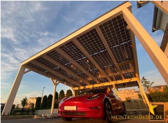
Abbildung 25: PV-Module mit Parkplatzüberdachung für ein Auto (Quelle: meintechblog.de o.j.)
