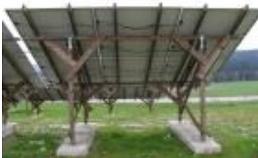
Abbildung 22: PV-Module mit starrer Südausrichtung mit Holz als Unterkonstruktion (Quelle: sun-consult.de 2006)
