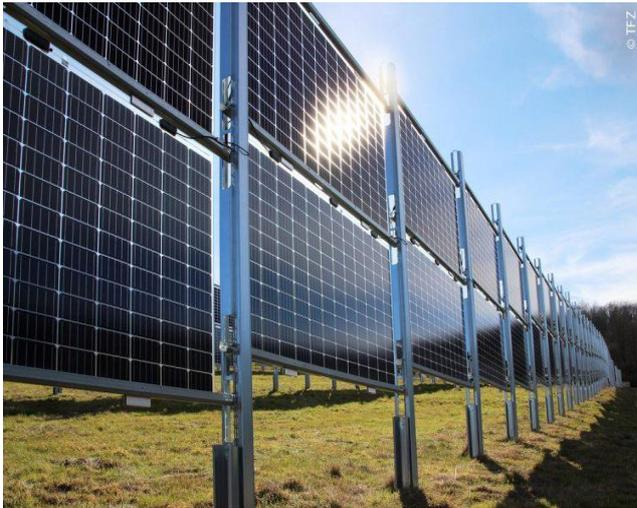
Abbildung 19: Vertikale bifaziale PV-Anlagen (Quelle: kommunaltopinform.de o.j.)
