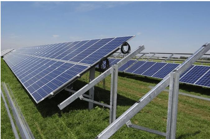
Abbildung 20: Starre Südausrichtung mit einem Mast (Quelle: memodo.de 2021)
