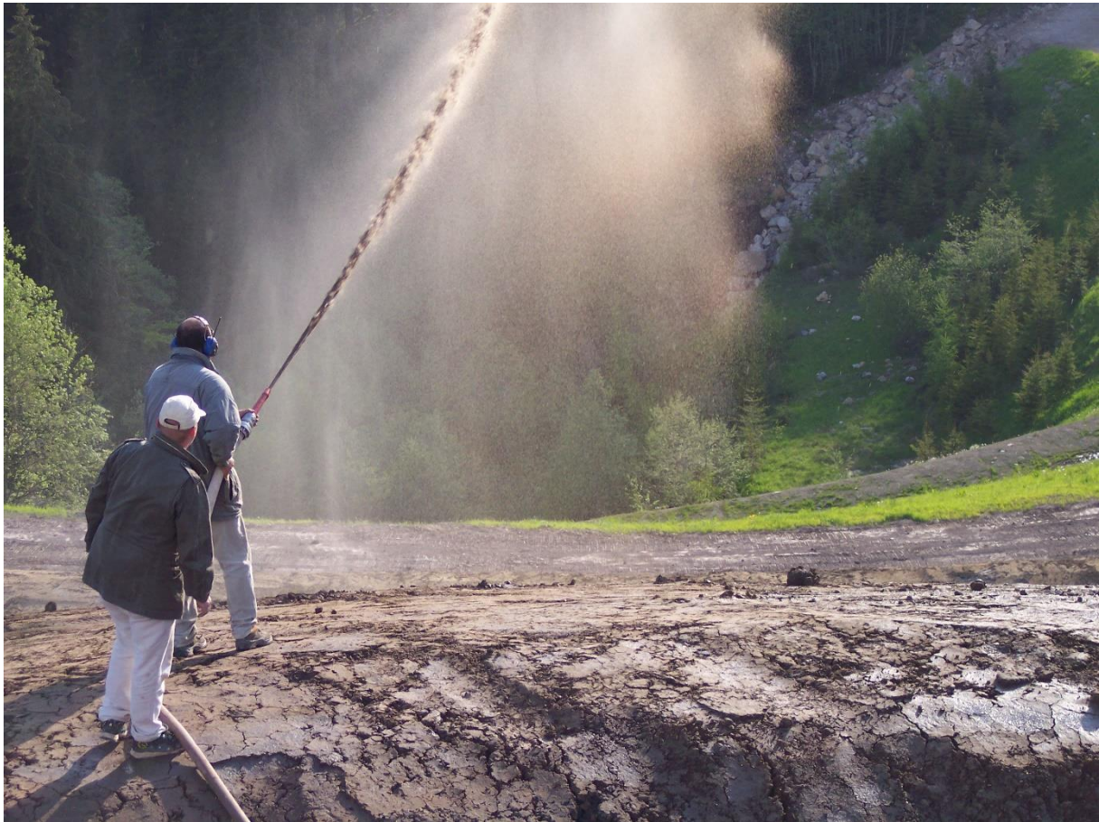
Abbildung 18: Applikation des Saatgutes im Hydrosaatverfahren. Quelle: DDr. Roman Schaffer, 2003.
