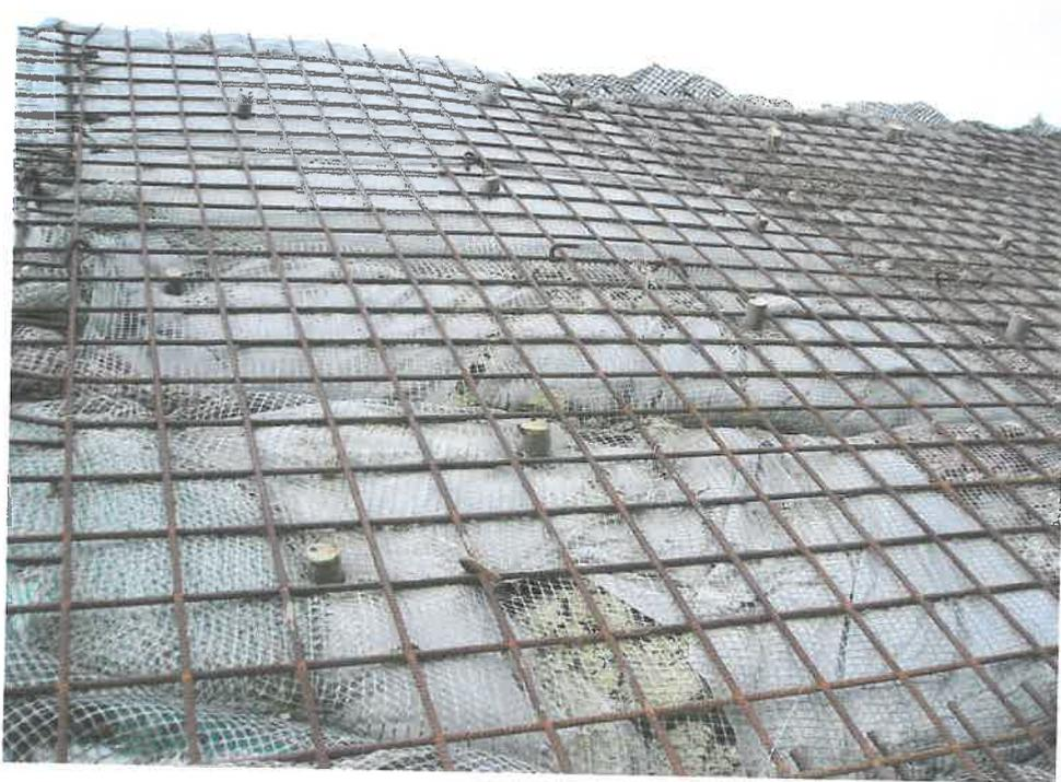
Abbildung 15: Teile eines Dammabschnittes mit eingeschlagenen Steckhölzern
