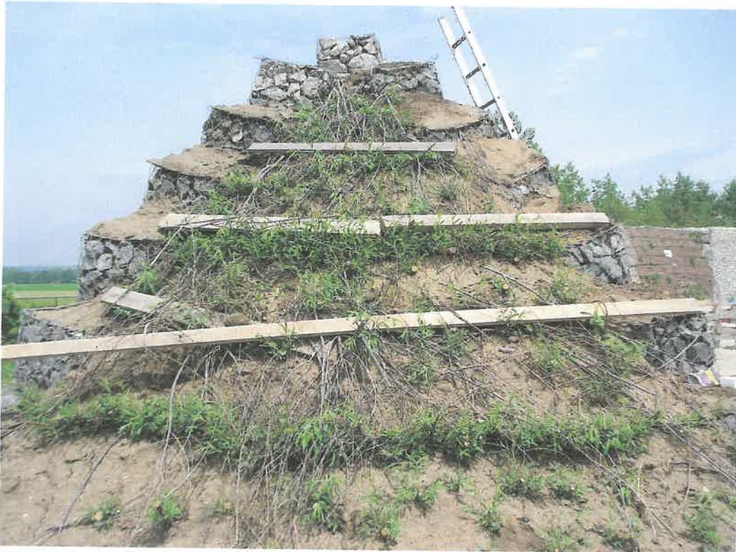
Abbildung 16: Lagenbau mit Steckhölzern ~~als Terrassenstufe~~
