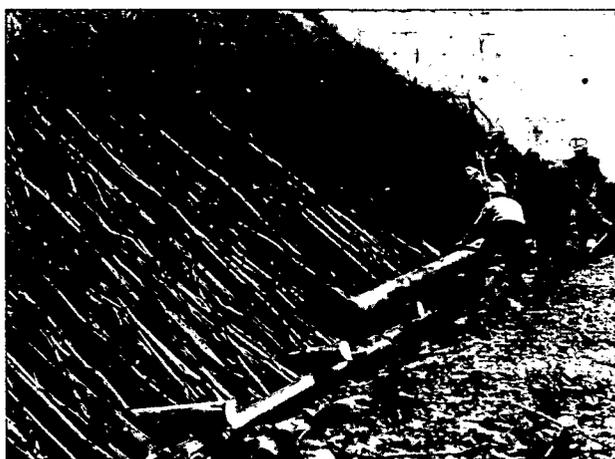
Abb. 52: Errichtung einer zweireihigen Holzkrainerwand als Fußsicherung, Standort Pitzbach (1990)
