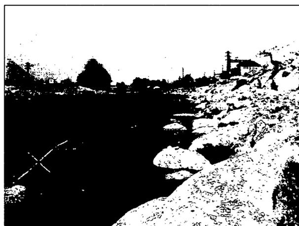
Abb. 6: Beispiel eines unregelmäßig verlegten Blockwurfs an der Etsch in Südtirol, 2006
