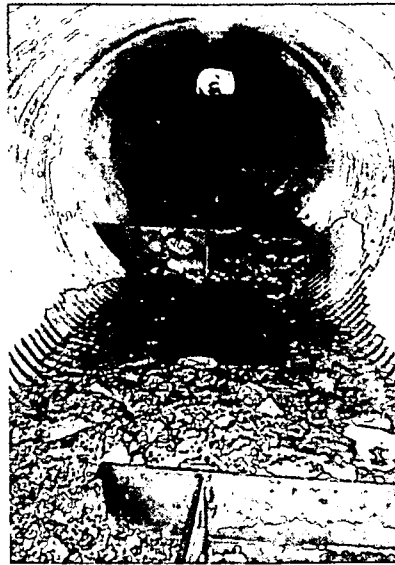
Abbildung 17: Sohlgurte im Wellblechdurchlass (FishXing, 2006)
