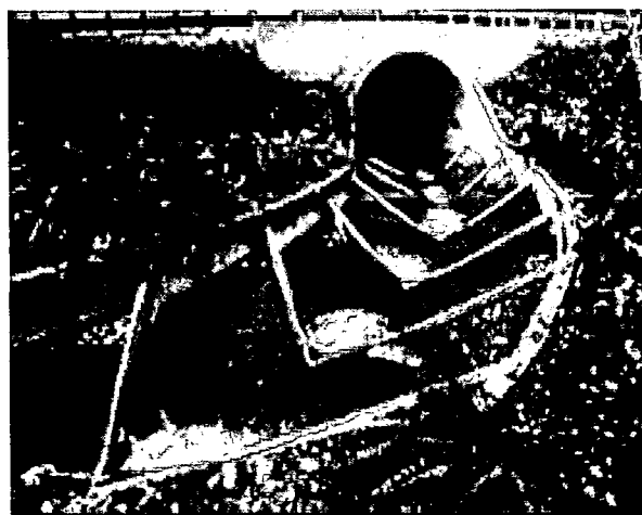
Abbildung 32: Fischaufstieg bei Rohreinlauf (FishXing, 2007)
