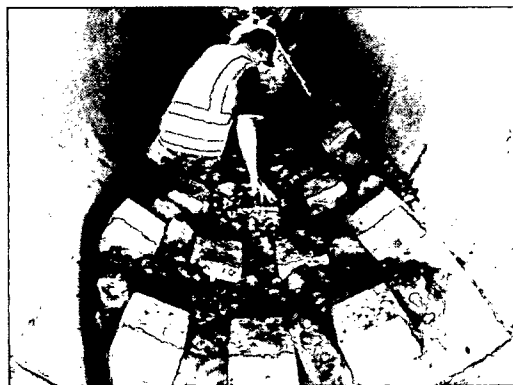
Abbildung 6: Einbringen von Kunststeinen
