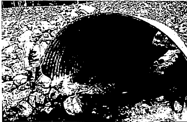
Abbildung 10: Bogenprofil auf Streifenfundamenten (FishXing HP, 2006)
