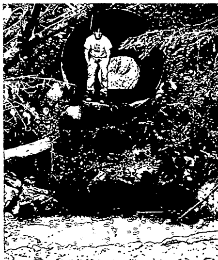
Abbildung 4: Absturz beim Rohrauslauf (FishXing, 2007)
