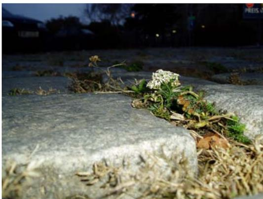
Abb. 58: Fläche ohne Aussaat und Verfüllung (Aufnahme vom 29.11.2006) Besonders reich und auffällig blüht Schafgarbe und Löwenzahn. Am Bild auch gut zu erkennen: Die Tiefe der ausgebürsteten Fugen.
