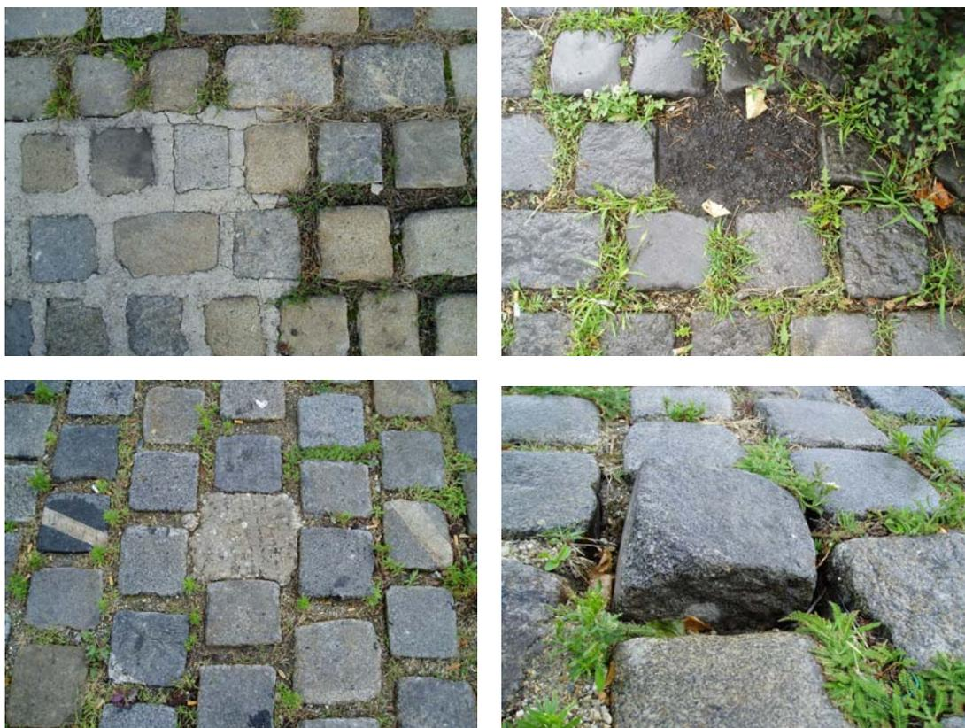
Abb. 103-106: Schäden am Pflasterverband und unsachgemäße Sanierung am Margaretengürtel in 1050 Wien (Aufnahmen von Juli 2007)
