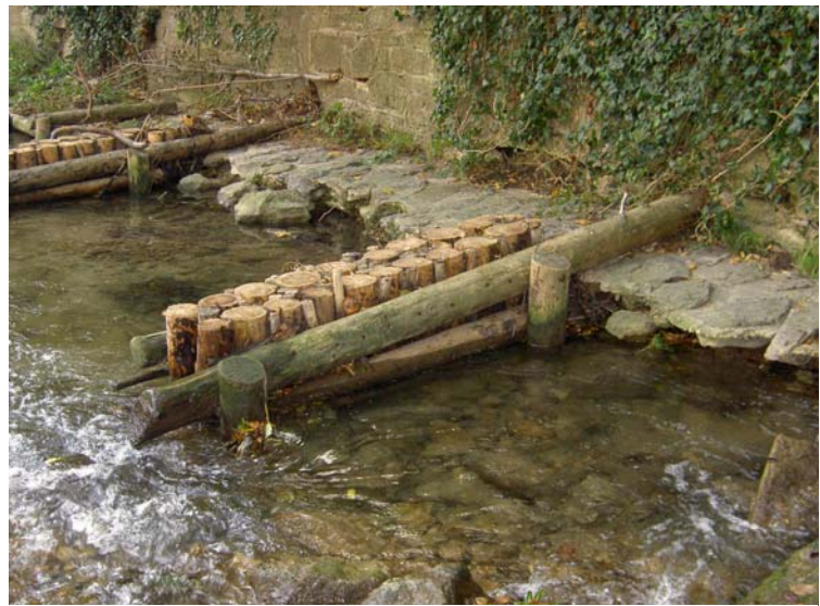
Abb. 64: Buhne im Teilbereich A nach den Reparaturarbeiten; Frühjahr 2007
