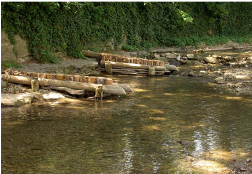
Abb. 19: Holzpfehlbühnen inklinant, am Mödlingbach, Kurpark, wenige Monate nach den Nachbesserungsarbeiten, Juni 2007
