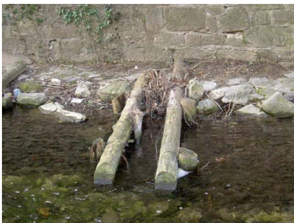
Abb. 55: Mödlinbach, Bereich Kurpark, Buhne vor dem Umbau im März 2007
