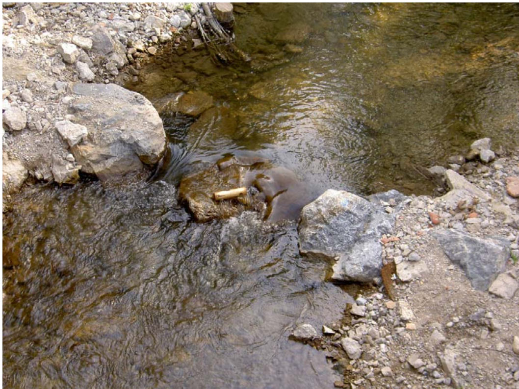
Abb. 21: Steinschwelle (Sohlgurt) bald nach der Fertigstellung, Mödlingbach, unterhalb der Viechtlgasse, Mai 2005
