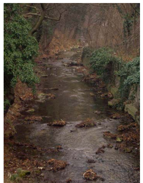
Abb. 37: Sohlsubstrat und enges Kastenprofil; R3 Klause Mödling Jänner 2007
