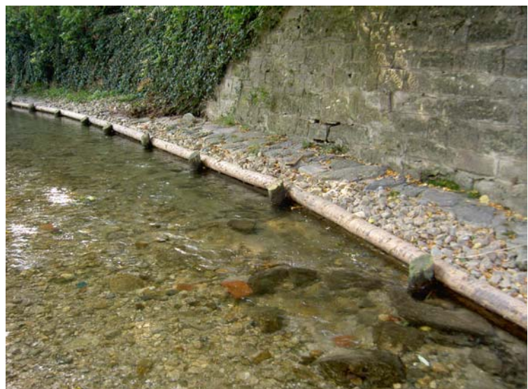
Abb. 63: ehemalige Faschinenreihe im Teilbereich A nach dem Umbau zu einem Rangverbau; Frühjahr 2007
