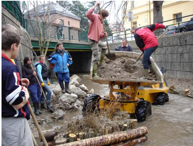
Abb. 30: Revitalisierungsarbeiten am Mödlingbach, Höhe Viechtlgasse, März 2005
