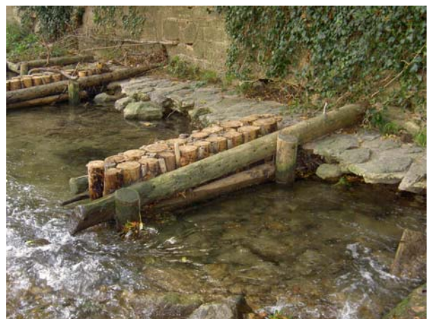
Abb. 54: Mödlinbach, Bereich Kurpark, Buhne nach dem Umbau, Juni 2007
