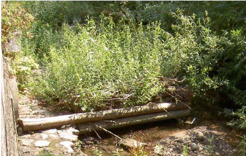
Abb. 18: Faschinenbühne deklinant, am Mödlingbach Höhe Viechtlgasse, Alter zwei Jahre, im Juni 2007
