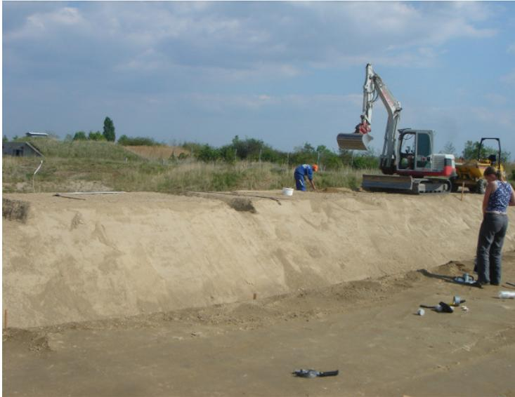
**Abbildung 61:** Ausheben der Überströmungsmulden, Versuchsanlage Deutsch Wagram/Niederösterreich; 25.04.2007
