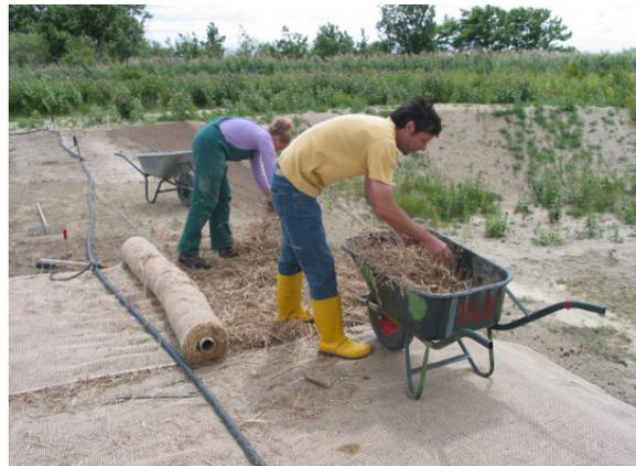
**Abbildung 83:** Aufbringen von Miscanthusstroh und Jutenetz, Versuchsanlage Deutsch Wagram/Niederösterreich; 28.06.2007
