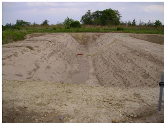
**Abbildung 72:** gesetzte Steckholzreihen, Versuchsanlage Deutsch Wagram/Niederösterreich; 11.05.2007
