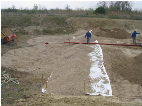
**Abbildung 57:** Festbetoniertes Entwässerungsrohr, Versuchsanlage Deutsch Wagram/Niederösterreich; 11.04.2007
