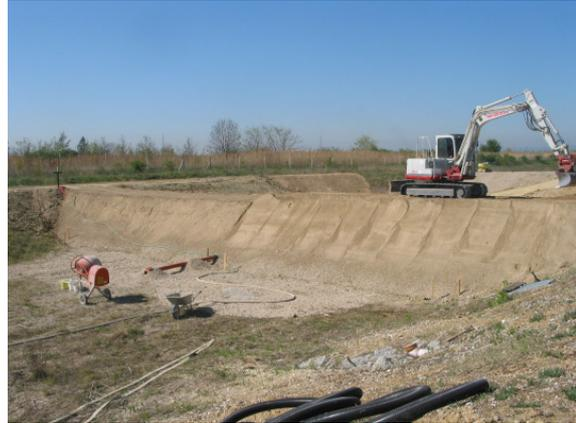
**Abbildung 53:** Fast fertig gestellter Überströmungsdamm, Versuchsanlage Deutsch Wagram/ Niederösterreich; 17.04.2007
