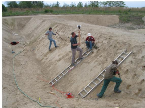
**Abbildung 71:** Setzen der Steckhölzer, Versuchsanlage Deutsch Wagram/Niederösterreich; 04.05.2007
