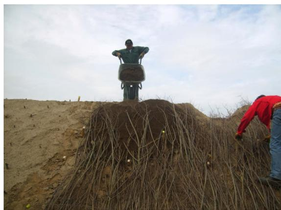
**Abbildung 77:** Überschütten mit Humus, Versuchsanlage Deutsch Wagram/Niederösterreich; 15.05.2007
