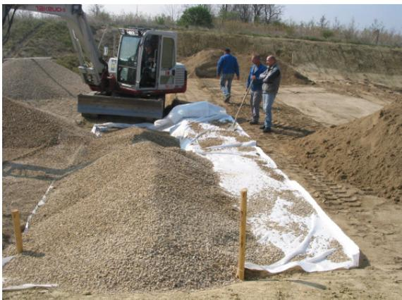
**Abbildung 54:** Einbau der Dränschicht am Überströmungsdamm, Versuchsanlage Deutsch Wagram/Niederösterreich; 11.04.2007
