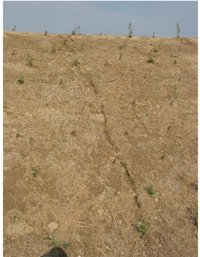
Sich auf der Dammkrone sammelndes Regenwasser führte anfangs immer wieder zu Rillenbildungen. Mit der Zeit stabilisierte sich aber die Dammoberfläche zwischen den Steckhölzern. Steckhölzer sind eine punktuelle Bepflanzungsmaßnahme und kein Erosionsschutz.
