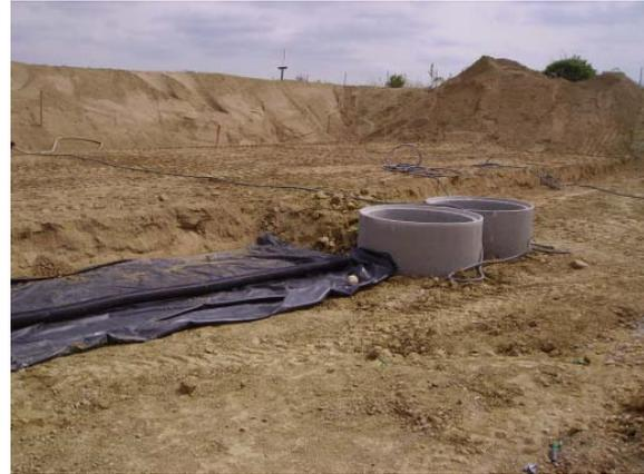
**Abbildung 56:** Einbau des Dränagerohres und der Sickerwassersammelbehälter, Versuchsanlage Deutsch Wagram/Niederösterreich; 18.04.2007
