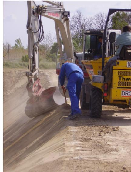
**Abbildung 62:** Abziehen der Böschung, Versuchsanlage Deutsch Wagram/ Niederösterreich; 24.04.2007
