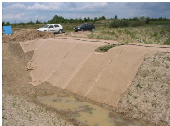
**Abbildung 85:** abgeschlossene Jutenetz-Strohdecksaat, Versuchsanlage Deutsch Wagram/Niederösterreich; 28.06.2007
