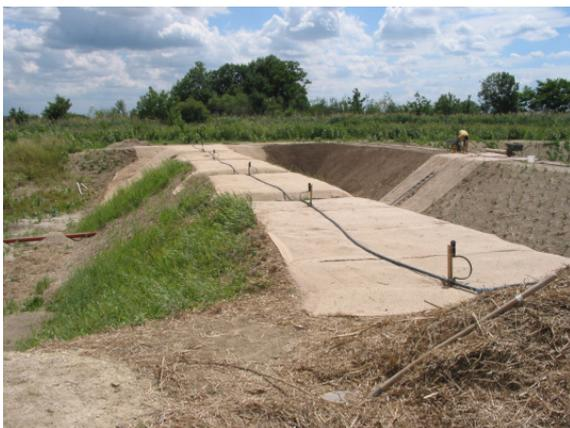
**Abbildung 84:** Überdeckung des Dammes mit Jutenetz, Versuchsanlage Deutsch Wagram/Niederösterreich; 28.06.2007
