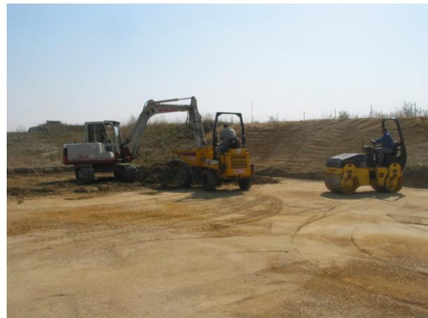
**Abbildung 51:** Verdichten der Lehmschicht, Versuchsanlage Deutsch Wagram/Niederösterreich; 05.04.2007
