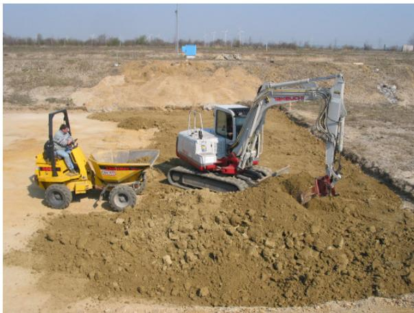
**Abbildung 50:** Schütten der Lehmschicht, Versuchsanlage Deutsch Wagram/Niederösterreich; 02.04.2007
