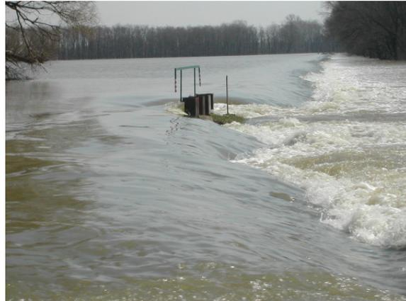
**Abbildung 40:** Überströmung eines Dammes und darauf folgender Dammbbruch an der March im März 2006 VIA-DONAU
