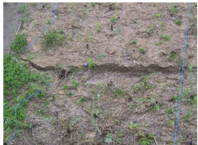
**Abbildung 109:** Rutschung an der wasserseitigen Böschung nach stärkeren Regenfällen, Versuchsanlage Deutsch Wagram/Niederösterreich; 07.09.2007
