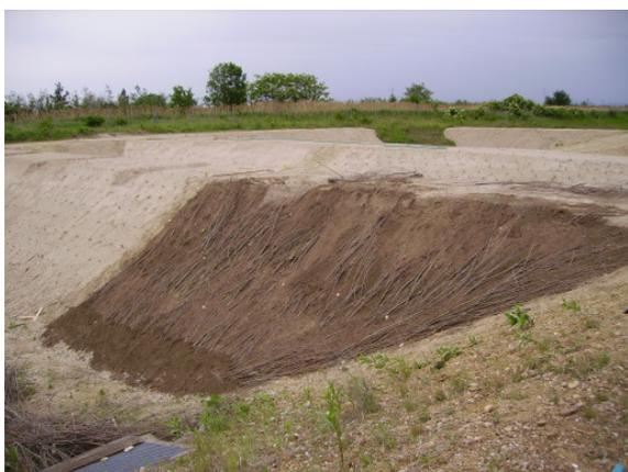
**Abbildung 76:** Weidenspreitlage längs, Versuchsanlage Deutsch Wagram/Niederösterreich; 15.05.2007
