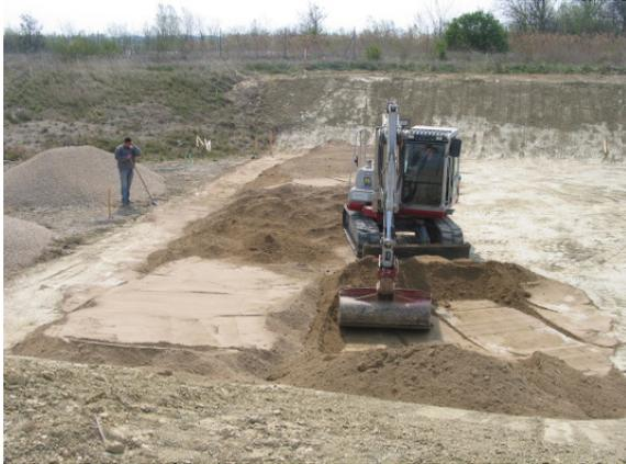
**Abbildung 52:** Schütten des Überströmungsdammes, Versuchsanlage Deutsch Wagram/ Niederösterreich; 10.04.2007
