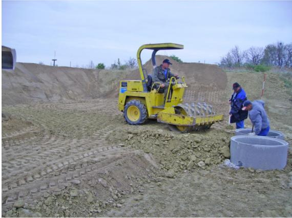
**Abbildung 55:** Einbau der Lehm trennschicht in den Durchsickerungsdamm, Versuchsanlage Deutsch Wagram/Niederösterreich; 18.04.2007
