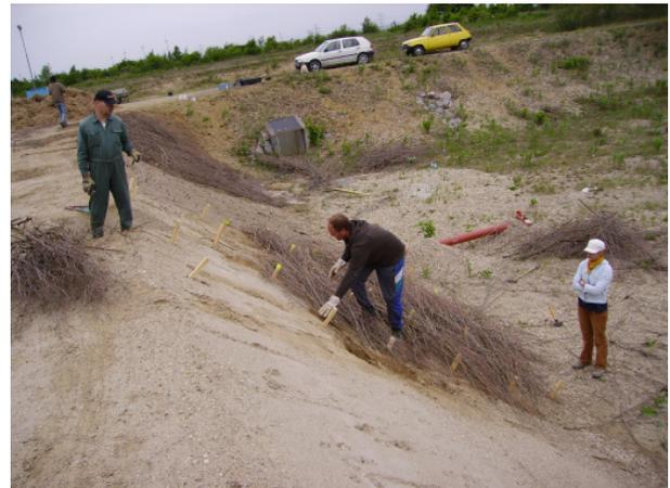
**Abbildung 79:** Bau der Weidenspreitlage quer, Versuchsanlage Deutsch Wagram/Niederösterreich; 15.05.2007
