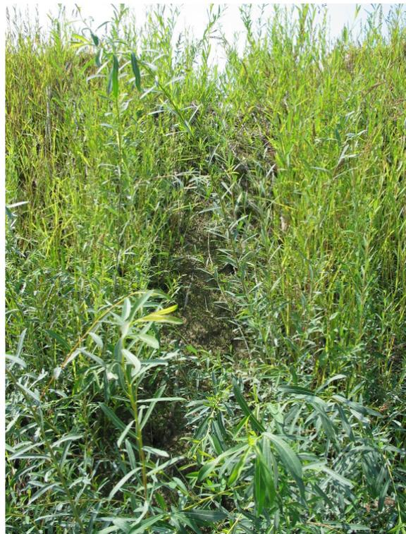
**Abbildung 113:** Schäden an der Weidenspreitlage längs durch Ausschwemmung, Versuchsanlage Deutsch Wagram/Niederösterreich:
