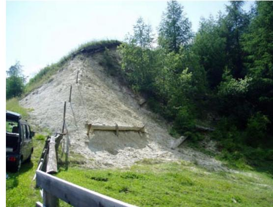
Abb 131: Entwicklung von Pilotenwänden nach 14 Jahren am Standort 3, Saldurbach Mühlhöfe Matsch 07/2006
