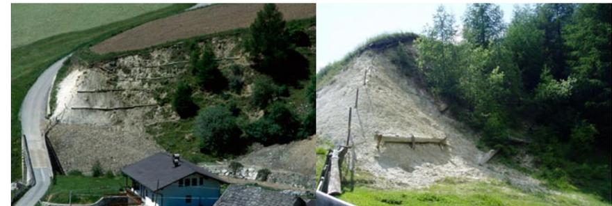
Abb 11: Archivfoto: Entwicklung von Pilotenwänden nach 3 Monaten am Standort 3, Saldurbach Mühlhölfe Matsch, 07/1992
