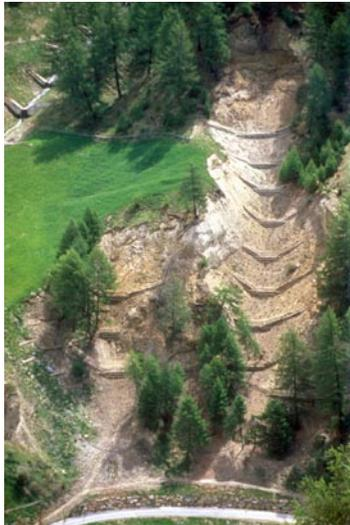
Abb 124: Gesamtansicht des Wötzelgrabens, kurz nach dem Einbau 1987
