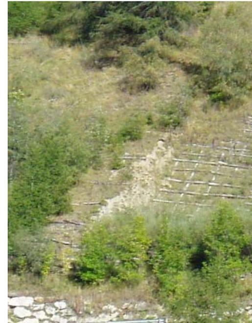
Abb 128: Erosionszone zwischen Pilotenwandbereich und Hangrost am Standort 2, Weg zu den Runerhöfen Matsch 07/2006, Zustand nach 10 Jahren
