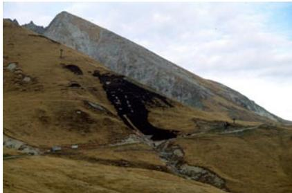
Abb 22: Gesamtansicht Standort 6, Innerer Kuhleitengraben Meran 2000, 11/1990, kurz nach Fertigstellung und Begrünung mit Bitumenstrohdecksaat
