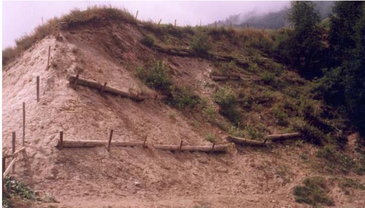
Abb 130: Archivfoto: Entwicklung von Pilotenwänden nach 3 Jahren am Standort 3, Saldurbach Mühlhöfe Matsch, aufgenommen 08/1995
