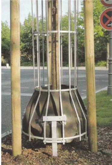
Abbildung 11: Baumschutzgitter mit Blende gegen Hunde-Urin (BALDER et al., 1997, s. 100)
