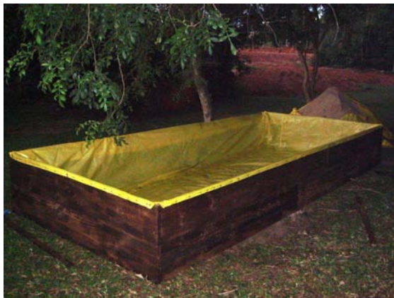
Abb. 27: Holzkonstruktion mit Plane (Versuch Einlageverhältnis in Sand mit Salix humboldtiana , Santa Maria / UFSM, Mai 2008)
