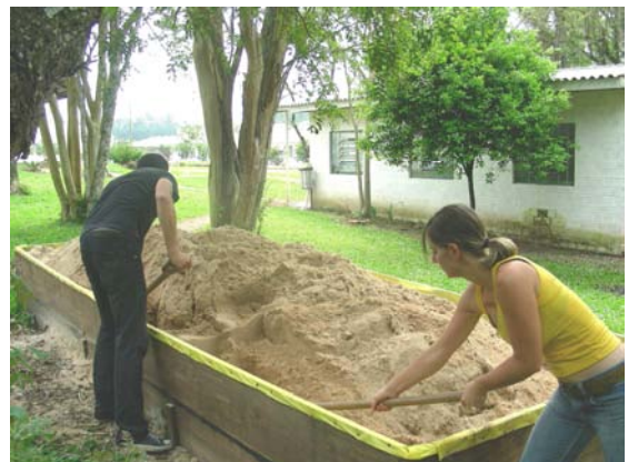
Abb. 63: Wiederbefüllen der Holzkonstruktion (Versuch Einlagewinkel in Sand mit Phyllanthus sellowianus , Santa Maria / UFSM, Okt. 2008)
