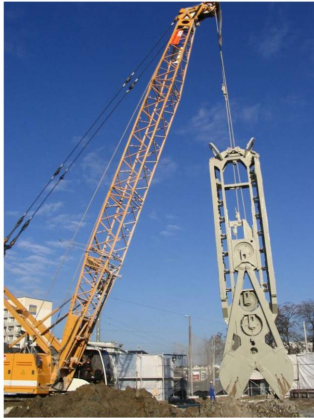
*Abb. 4.6 Schlitzwand- Seilgreifer [Grund-, Pfahl- und Sonderbau Archiv]*
