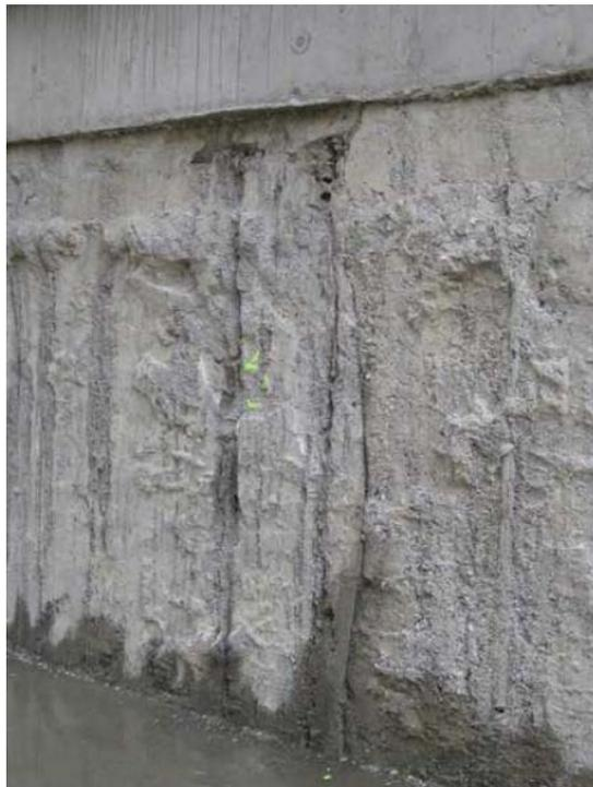
*Abb. 5.3 Geschädigtes Schlitzwandelement [BPV- Archiv]*
