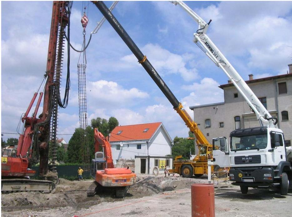
*Abb. 4.5 Schneckenortbetonpfahl SOB [Grund-, Pfahl- und Sonderbau Archiv]*
