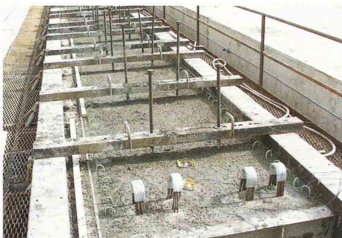
Abbildung 6-52: Durchgeführte Feldmessungen an einem frisch betonierten Kastenträger [VOIGT; DEHN; und SHAH; (2004)]
