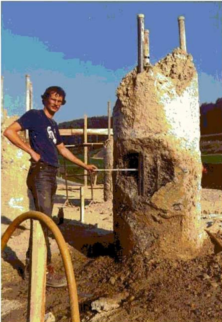
Abbildung 7-5: Sandeinschlüsse bei bewehrten Ortbetonpfählen [Quelle unbekannt]
