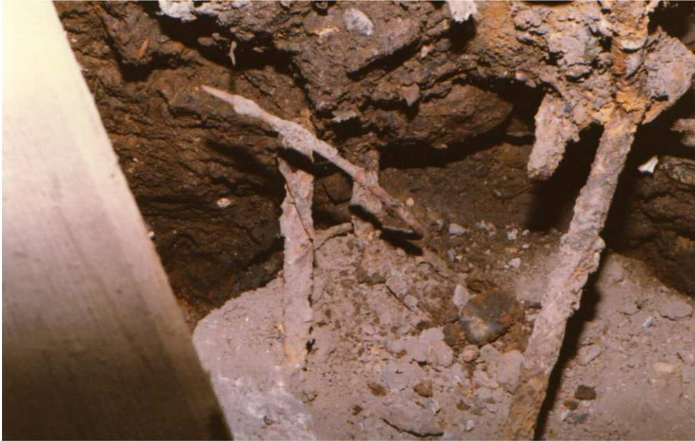
*Abbildung 7-2: Sandeinschlüsse bei bewehrten Ortbetonpfählen [Quelle unbekannt]*
