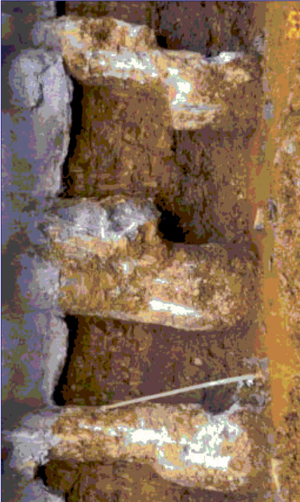
*Abbildung 7-6: Schäden an Schraubenbohrpfählen in weichen Boden [WITT, K.-J.;; Schadensfälle bei Pfahlgründungen]*
