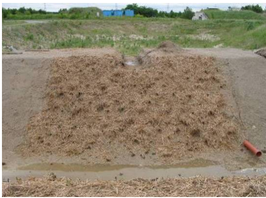
Abbildung 82: Bauphase der Steckhölzer am Überströmungsdamm, Sektor 6 Überströmungsdamm (Deutsch-Wagram, LAMMERANNER Mai 2007).
