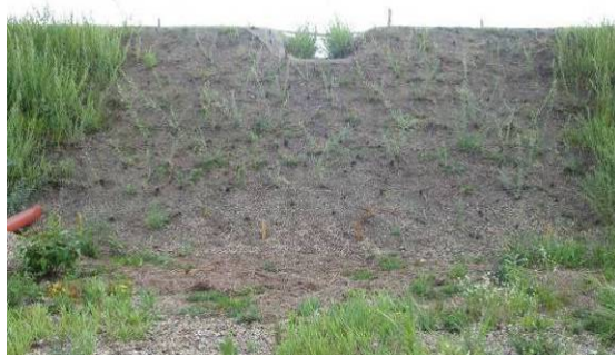
Abbildung 109: Steckhölzer 2 Monate alt, Sektor 10 (Deutsch-Wagram, LAMMERANNER Juli 2007).
