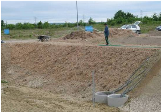
Abbildung 47: Bauphase der Steckhölzer am Durchsickerungsdamm, Sektor 1 (Deutsch-Wagram, LAMMERANNER Mai 2007).
