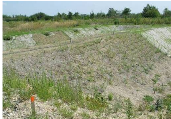
Abbildung 48: Steckhölzer 2 Monate alt, Sektor 1 (Deutsch-Wagram, LAMMERANNER Juli 2007).
