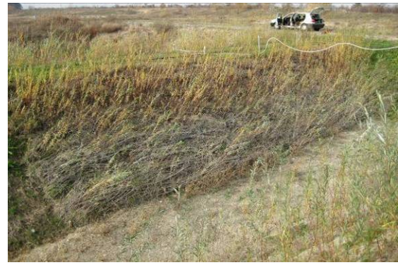
Abbildung 75: Weidenspreitlage quer 8 Monate alt, Sektor 3 (Deutsch-Wagram, November 2008).
