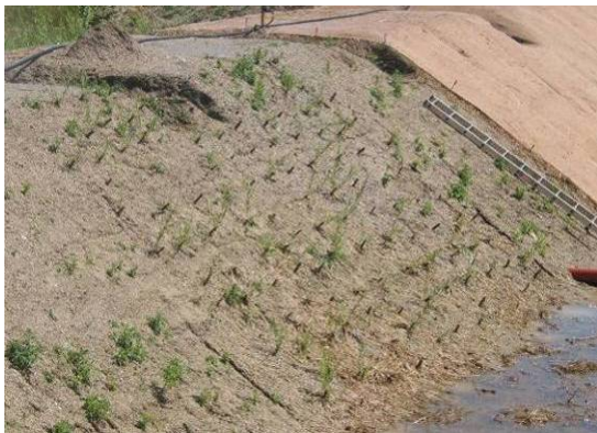
Abbildung 84: Steckhölzer 5 Monate alt, Sektor 6 (Deutsch-Wagram, LAMMERANNER Oktober 2007).
