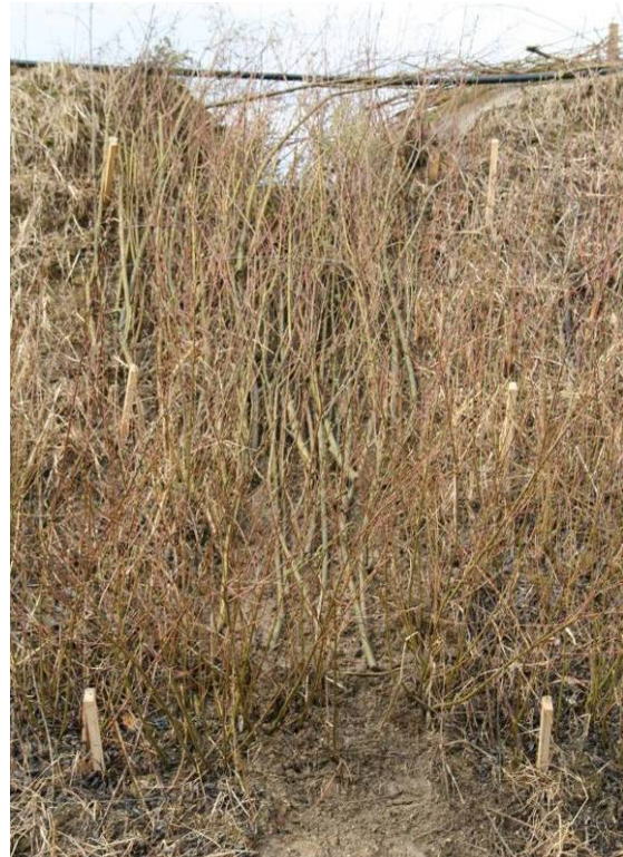
Abbildung 94: Verbesserungsmaßnahmen der Weidenspreitlage längs, Sektor 9 (Deutsch-Wagram, März 2008).
