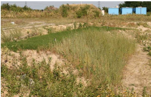
Abbildung 151: Weidenspreitlage quer und Gräser-Kräuter Ansaat am Ausgrabungsdamm 5 Monate alt (Deutsch-Wagram, August 2008)
