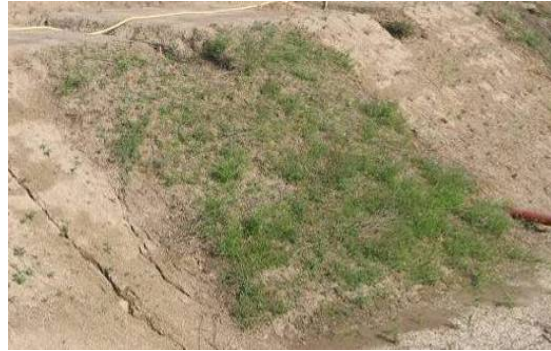
Abbildung 120: Weidenspreitlage quer 1 Monat alt, Sektor 11 (Deutsch-Wagram, LAMMERANNER Juni 2007).
