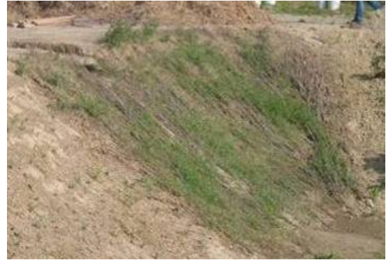
Abbildung 96: Weidenspreitlage längs 1 Monat alt, Sektor 9 (Deutsch-Wagram, LAMMERANNER Juni 2007).
