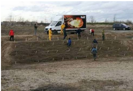
Abbildung 140: Bauphase der Weidenspreitlage quer, Sektor 13 (Deutsch-Wagram, März 2008).
