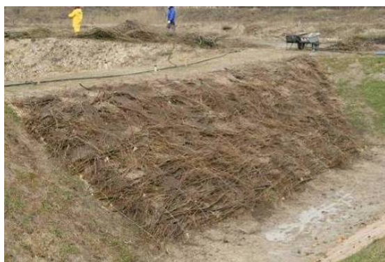
Abbildung 72: Bauphase der Weidenspreitlage quer am Durchsickerungsdamm, Sektor 3 (Deutsch-Wagram, März 2008).
