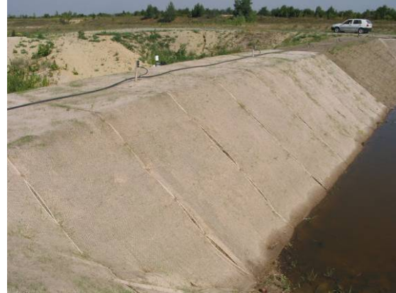
Abbildung 59: Bauphase der Gräser-Kräuter Begrünung am Durchsickerungsdamm, Sektor 2 und 4 (Deutsch-Wagram, LAMMERANNER Juni 2007)
