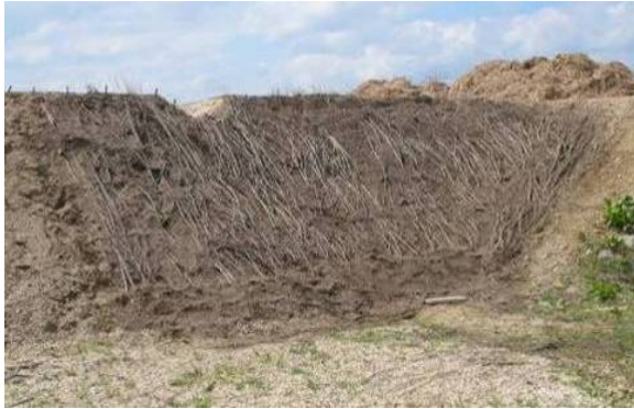
Abbildung 95: Bauphase der Weidenspreitlage längs, Sektor 9 (Deutsch-Wagram, LAMMERANNER Mai 2007).
