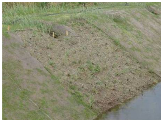
Abbildung 83: Steckhölzer 2 Monate alt, Sektor 6 (Deutsch-Wagram, LAMMERANNER Juli 2007).
