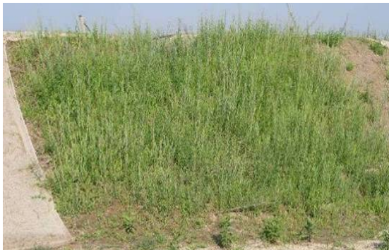
Abbildung 121: Weidenspreitlage quer 2 Monate alt, Sektor 11 (Deutsch-Wagram, HOLZAPFEL Juli 2007, S.107).
