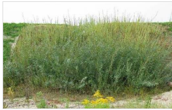
Abbildung 122: Weidenspreitlage quer 5 Monate alt, Sektor 11 (Deutsch-Wagram, LAMMERANNER Oktober 2007).
