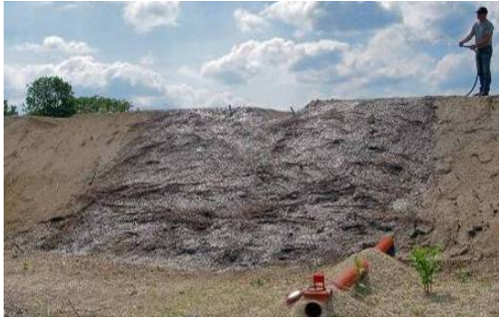
Abbildung 119: Bauphase der Weidenspreitlage quer, Sektor 11 (Deutsch-Wagram, LAMMERANNER Mai 2007).
