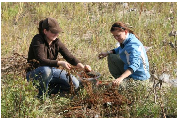
Abbildung 166: Trennen der Wurzel von den Astlagen der Weidenspreitlage, Sektor 13 (Deutsch-Wagram, Oktober 2008).
