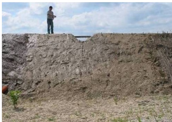
Abbildung 107: Bauphase der Steckhölzer am Überströmungsdamm, Sektor 10 (Deutsch-Wagram, LAMMERANNER Mai 2007).
