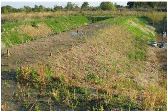
Abbildung 49: Steckhölzer 4 Monate alt, Sektor 1 (Deutsch-Wagram, LAMMERANNER September 2007).
