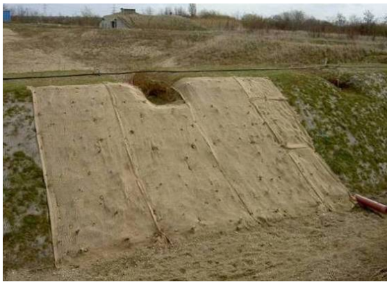
Abbildung 86: Steckholzpflanzung, Sektor 6 nach dem Einbau des Kokosnetzes (Deutsch-Wagram, März 2008).
