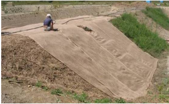
Abbildung 132: Bauphase der Gräser-Kräuter Begrünung am Überströmungsdamm, Sektor 12 (Deutsch-Wagram, LAMMERANNER Juni 2007).
