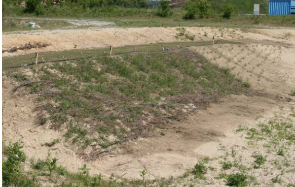
Abbildung 149: Weidenspreitlage quer, Steckhölzer und Gräser-Kräuter Ansaat am Ausgrabungsdamm 2 Monate alt (Deutsch-Wagram, Mai 2008)
