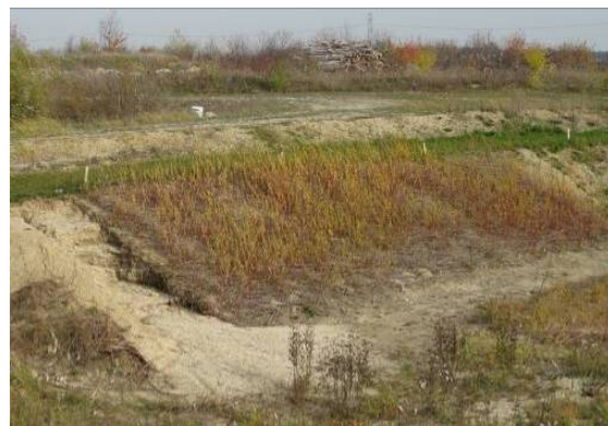
Abbildung 143: Weidenspreitlage quer 8 Monate alt, Sektor 13 (Deutsch-Wagram, November 2008).
