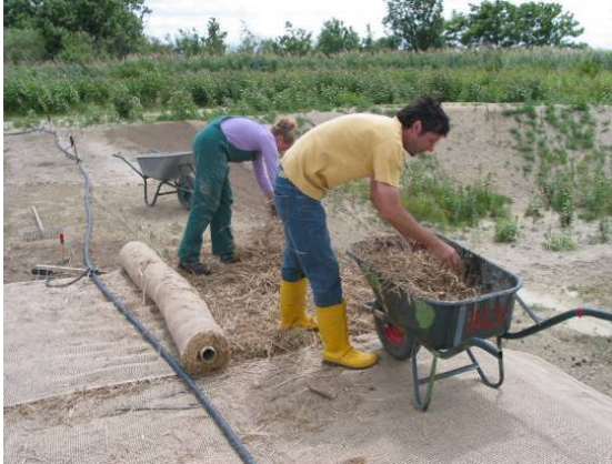
Abbildung 58: Bauphase der Gräser-Kräuter Begrünung am Durchsickerungsdamm, Sektor 2 und 4 (Deutsch-Wagram, EBNER Juni 2007, S.77)
