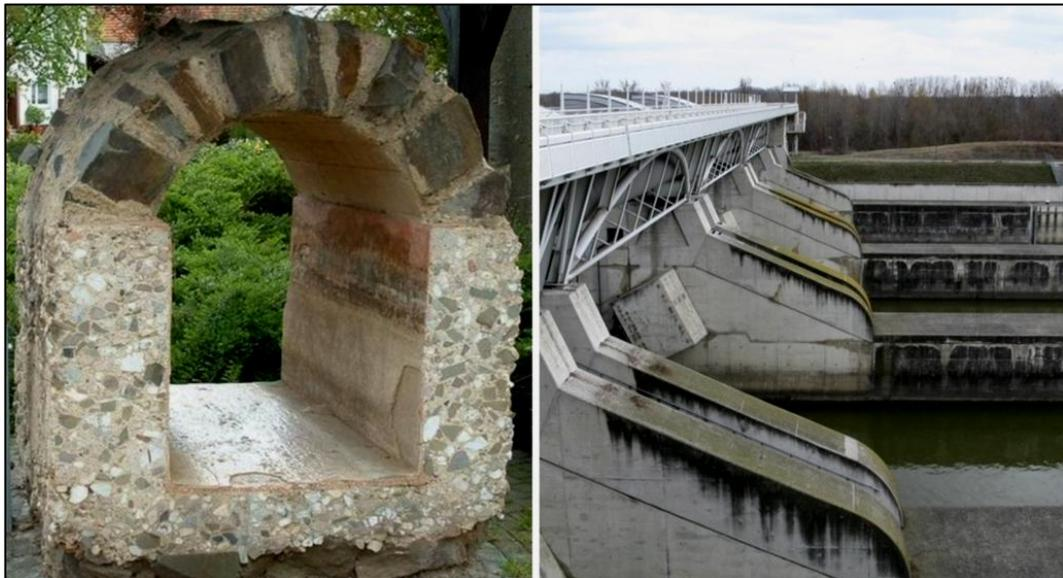
Abbildung 12: Beton im Wasserbau. Römischer Kanal bei Bonn [20], Donaukraftwerk Freudenau.
