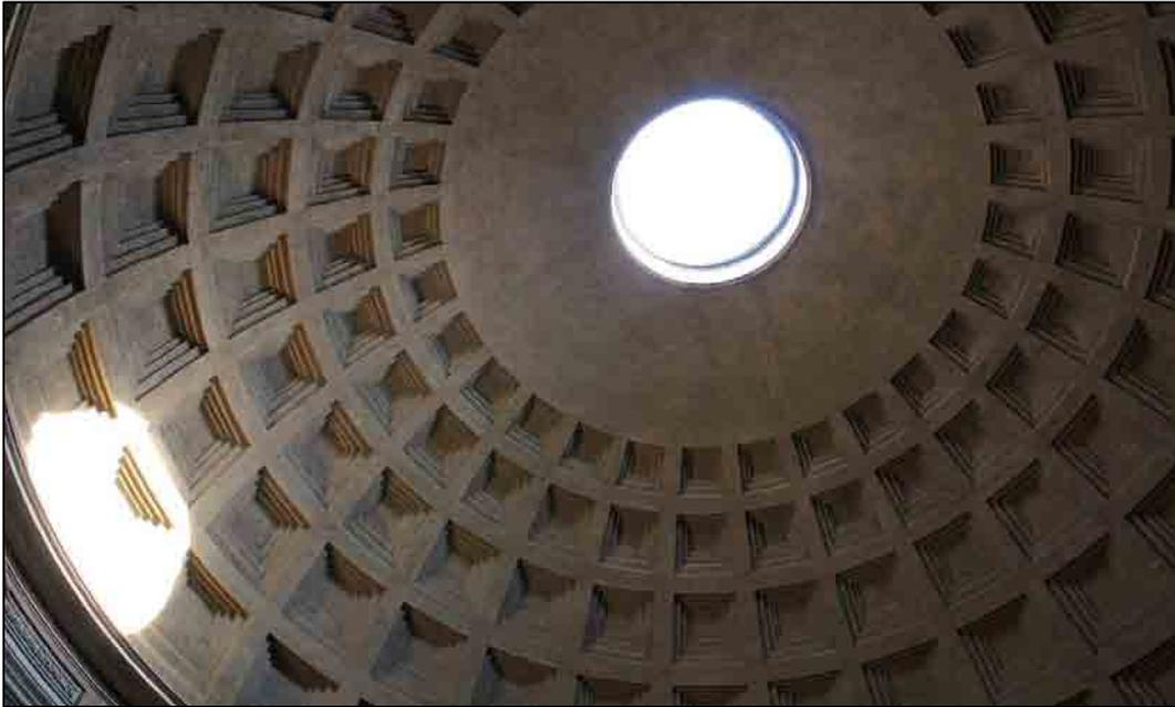
Abbildung 13: Kuppel des Pantheon in Rom. Leichtbeton in Kassettenschalbauweise, um 120 n.Chr. [22]
