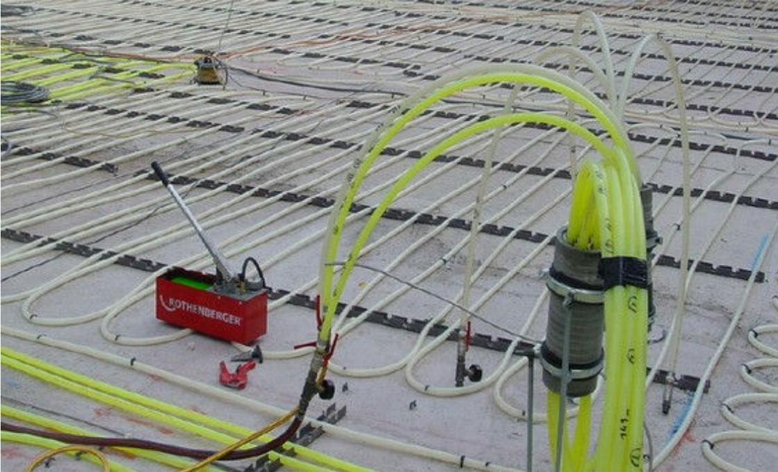
**Abbildung 5.1** horizontaler Erdwärmetauscher des Passivhaus Studentenheims Molkereistraße in Wien (aus [Ecoplus, 2004, S.11])
