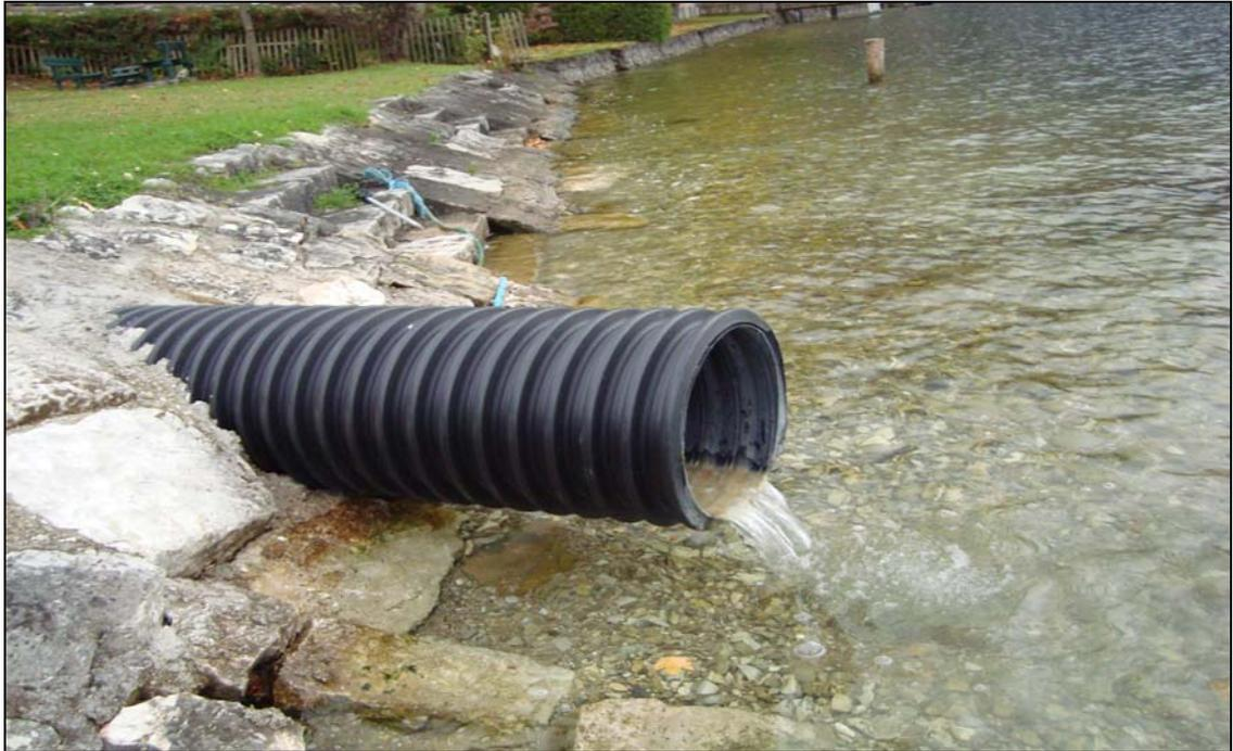
Abb. 12 Einmündung eines Pecor- Schwerlastrohres aus PEHD in den Traunsee
