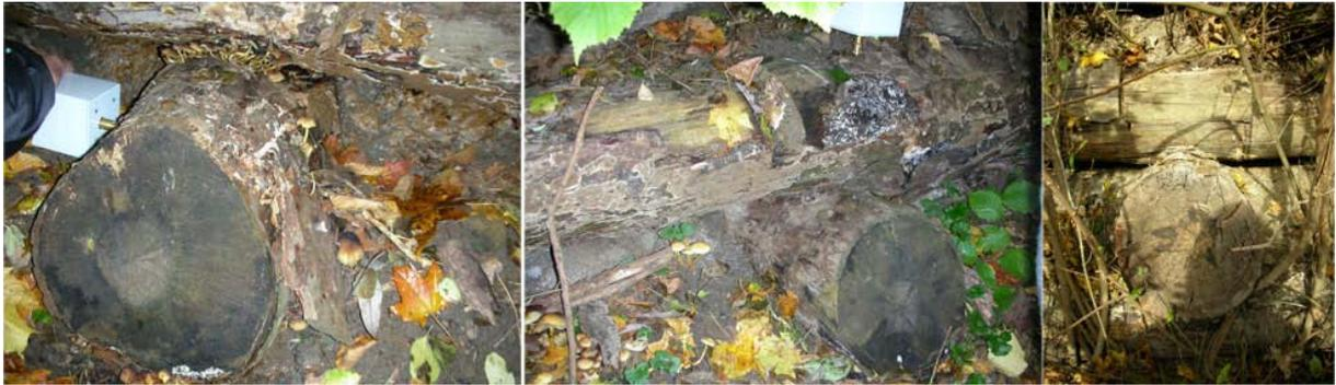
Abb. 194: li. und mi. Bildung von *Armillaria* sp. (Hallimasch), re. trockener Lärchenstamm mit Braunfäule, am 5-jährigen Lärmschutzwalles im Irenental/NÖ, April 2009
