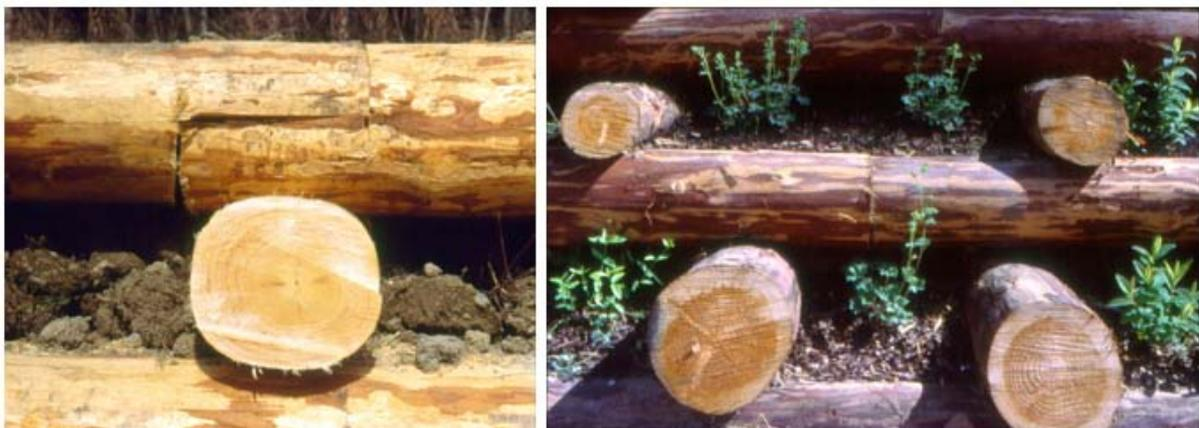
Abb. 180: Holzverbindungen: li. Überblattung am Lärmschutzwall im Irenental/NÖ, April 2004; re. Stoßverbindung an einer Holzkrainerwand im Irenental/NÖ, April 2008
