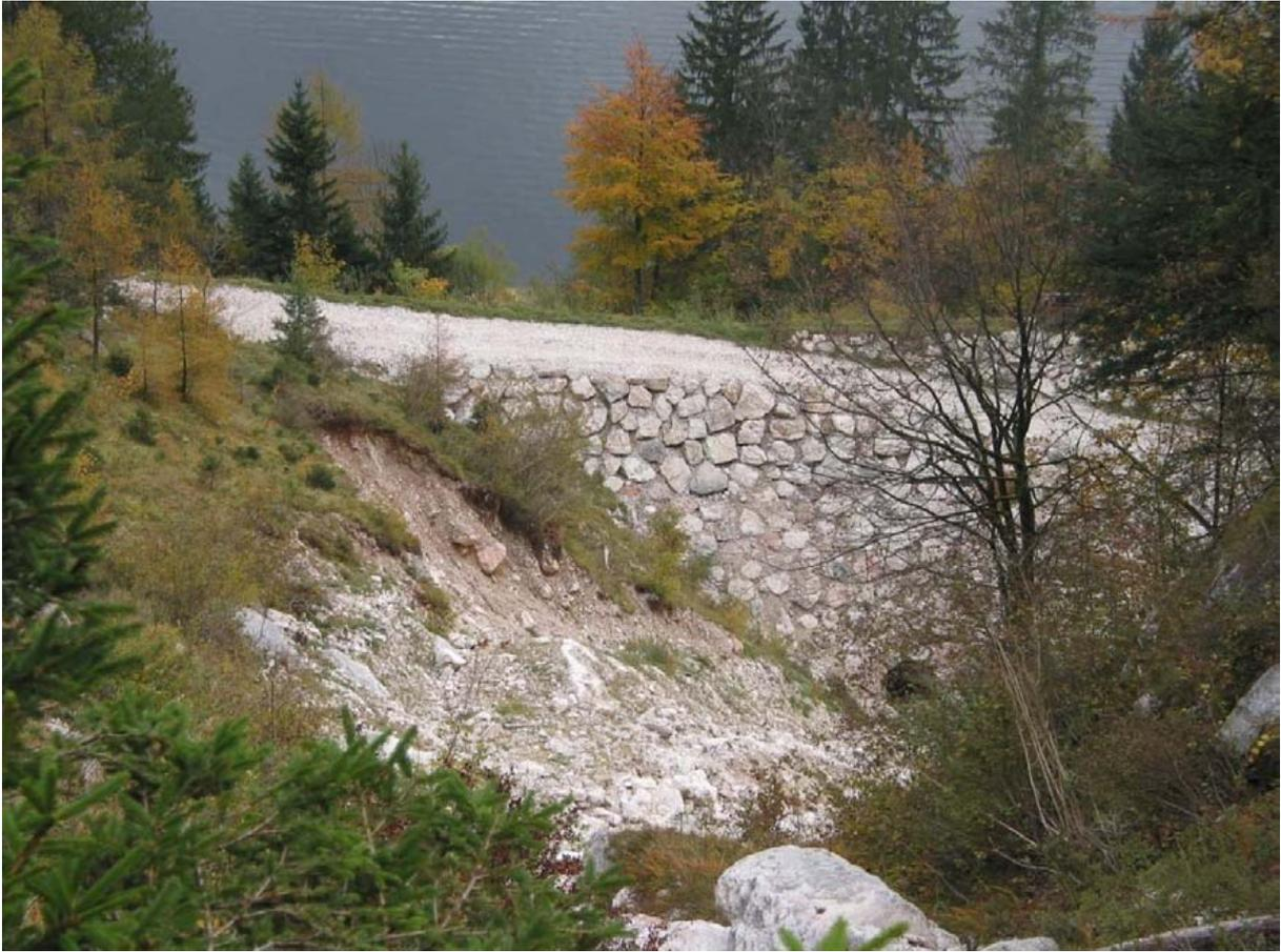
*Abbildung 74: Innenseite des Lawinenauffangdamms der Steingrabenlawine mit Grobsteinschichtung und Erosionsflanke auf der orografisch linken Seite, Bannwald Hallstatt, 10/2009*
