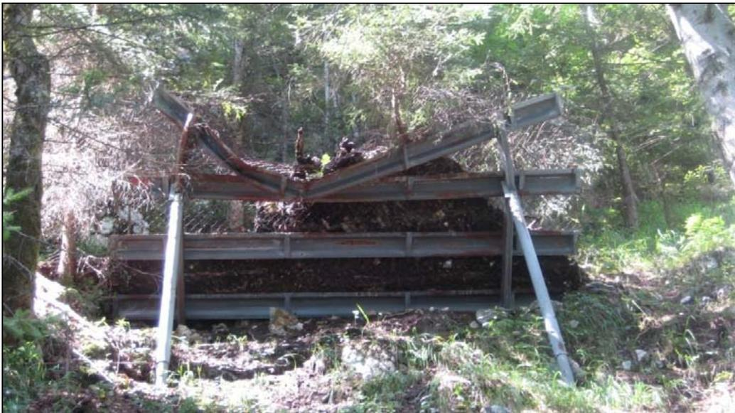
Abbildung 67: technische Werke sind teilweise durch Windwürfe stark beeinträchtigt und mit Material hinterfüllt, Bannwald Hallstatt, 10/2009
