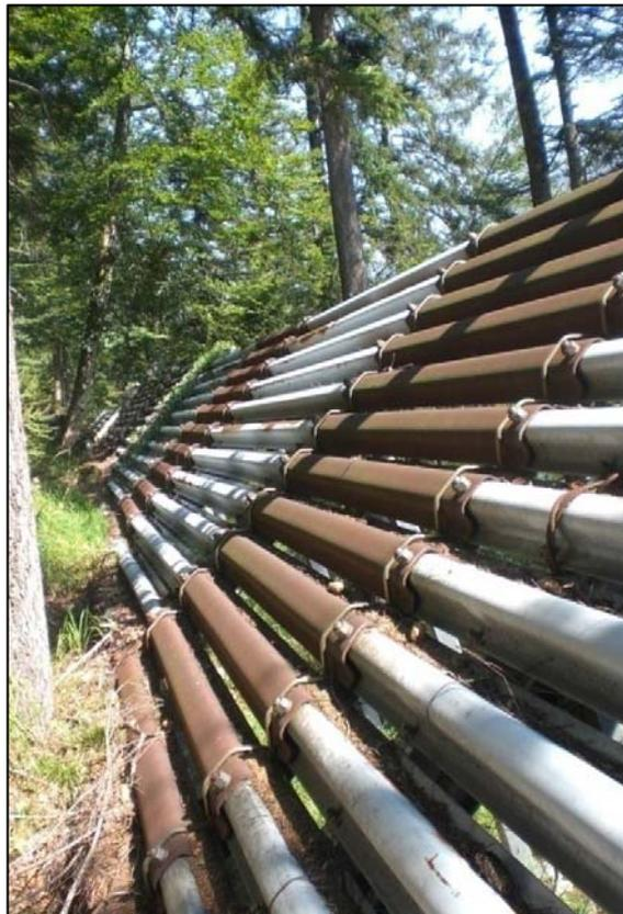
Abbildung 55: Stahlschneebrücken als Steinschlag- und Lawinenschutzmaßnahme. Das linke Bild zeigt ein Bauwerk höheren Alters mit Maschendraht. Rechts ist eine Stahlschneebrücke aus dem Jahr 1987, die trotz einiger korrodierten Balken einen guten Zustand aufweist, abgebildet. Bannwald Hallstatt, 10/2009
