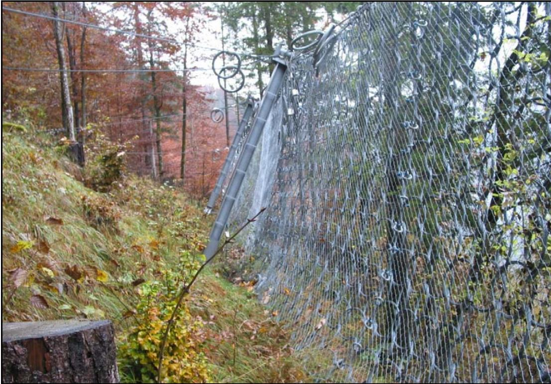
Abbildung 54: Drahtseilnetzwerk als Steinschlagschutz in sehr gutem Zustand, Bannwald Hallstatt, 10/2009
