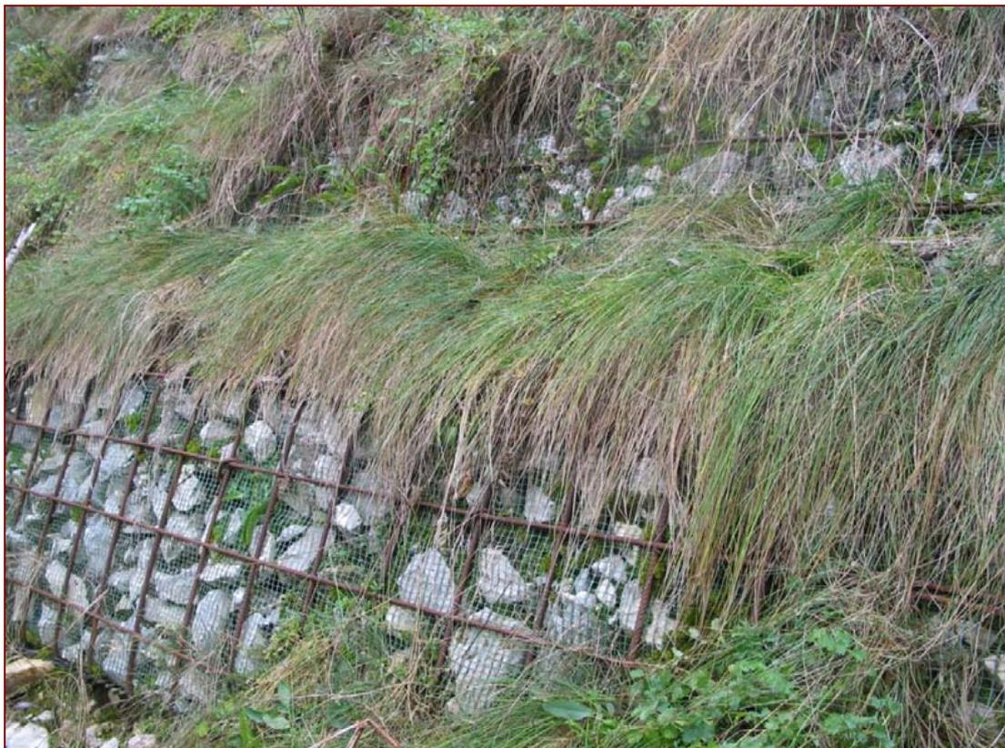
*Abbildung 72: Bermen mit Baustahlgitter und Geogitter.*
