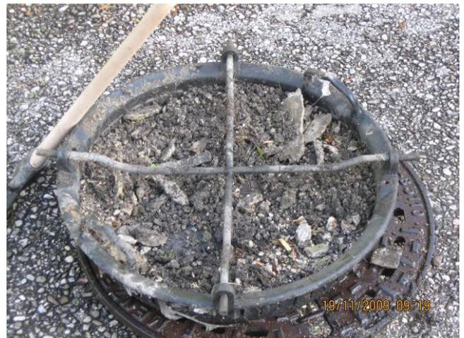
Abbildung 69 Beispiele für Füllungsgrade der Schmutzfangkörbe 5%, 10%, 50%, 100% (von links oben nach rechts unten)
