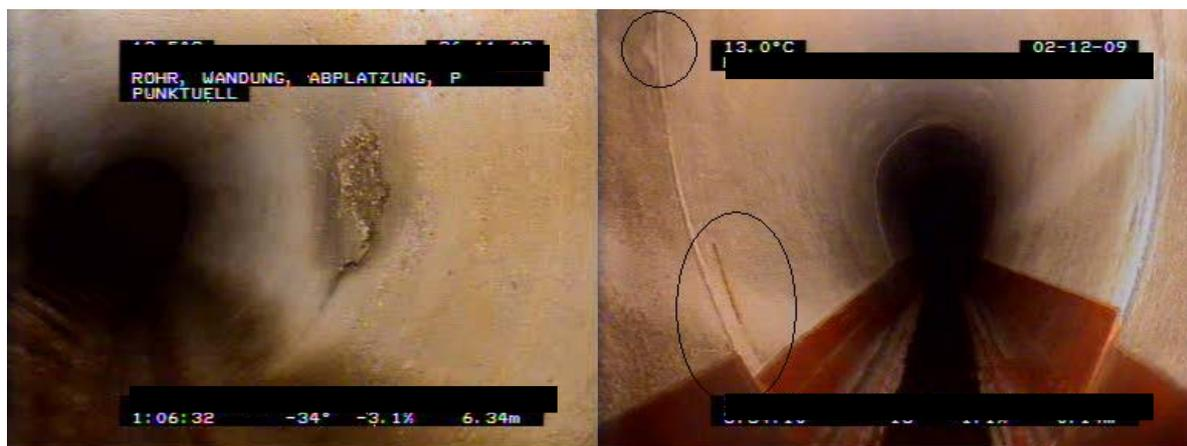
Abbildung 99 Kanal-TV Aufnahmen von Abplatzungen – nicht erkennbar mit der QuickView®-Kamera
