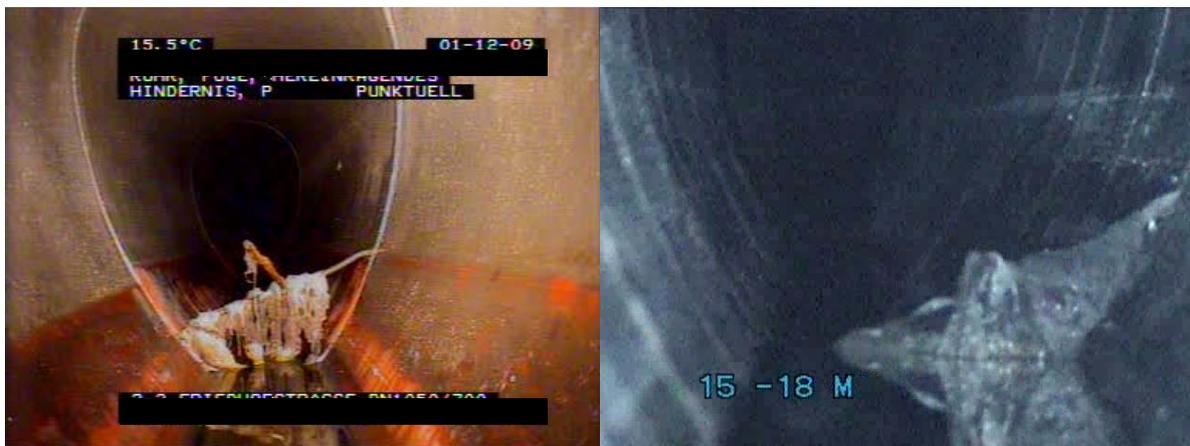
Abbildung 102 Hereinragendes Hindernis, (links Kanal-TV, rechts QuickView®)
