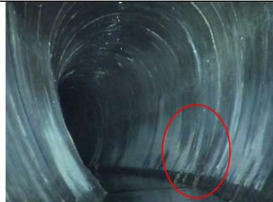
Abbildung 553: Quickview (28-29), Aussinterung
