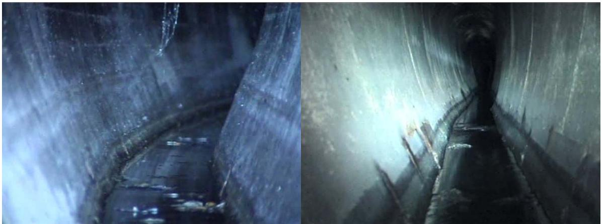
Abbildung 68 Eiprofil Ablagerung 10%
