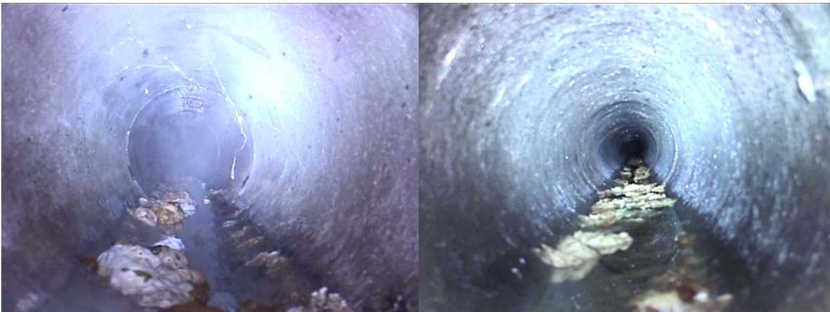
Abbildung 64 Kreisprofil Ablagerung 7,5%
