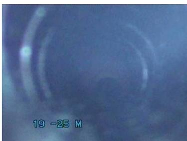
Abbildung 126 Distanzmessung zu Haltungsende, Nebelbildung
