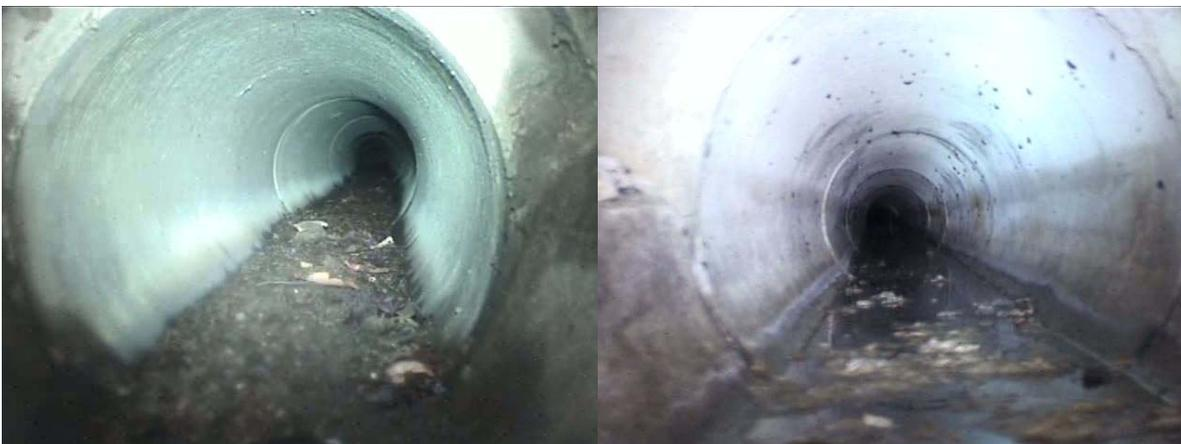
Abbildung 65 Kreisprofil Ablagerung 10% (linkes Bild), 15% (rechtes Bild)
