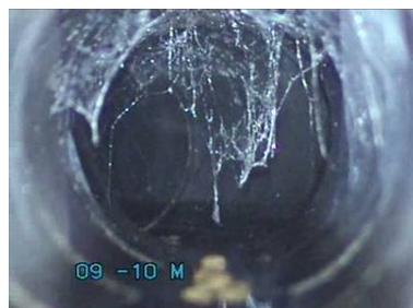
Abbildung 127 Distanzmessung zu Haltungsende, Spinnweben
