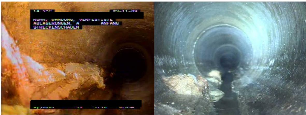
Abbildung 100 Verfestigte Ablagerungen (links Kanal-TV, rechts QuickView®)
