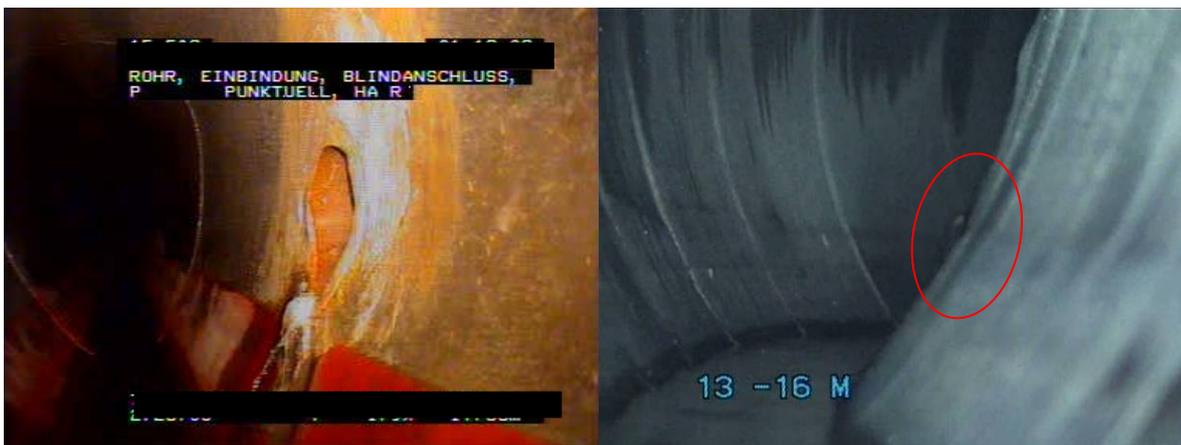
Abbildung 112 Einbindung mit Wassereintritt (links Kanal-TV, rechts QuickView®)
