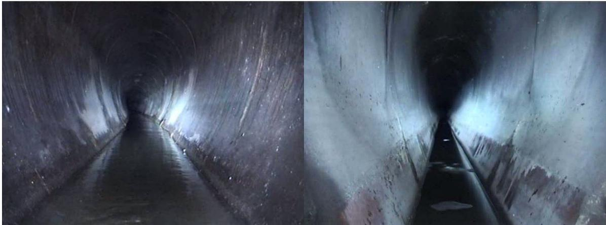
Abbildung 66 Eiprofil Ablagerung 5%
