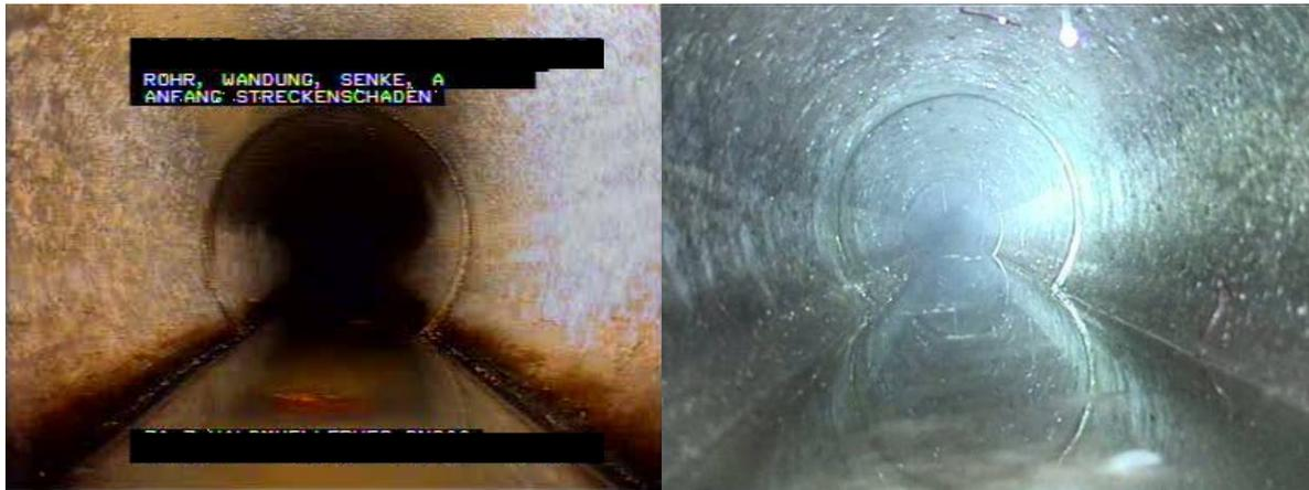
Abbildung 106 Senke (links Kanal-TV, rechts QuickView®)
