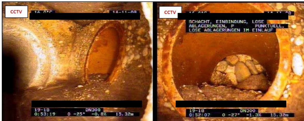
Abbildung 97 Erdreich sichtbar (Hausanschluss in Blindschacht mündend, Kanal-TV) (ERTL et al. 2010)
