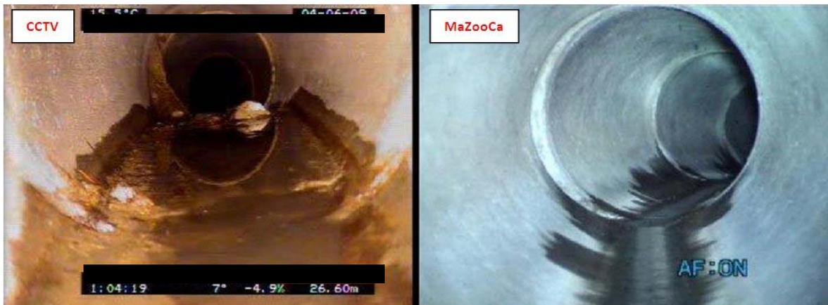
Abbildung 104 Knick (links Kanal-TV, rechts QuickView®) (ERTL et al. 2010)
