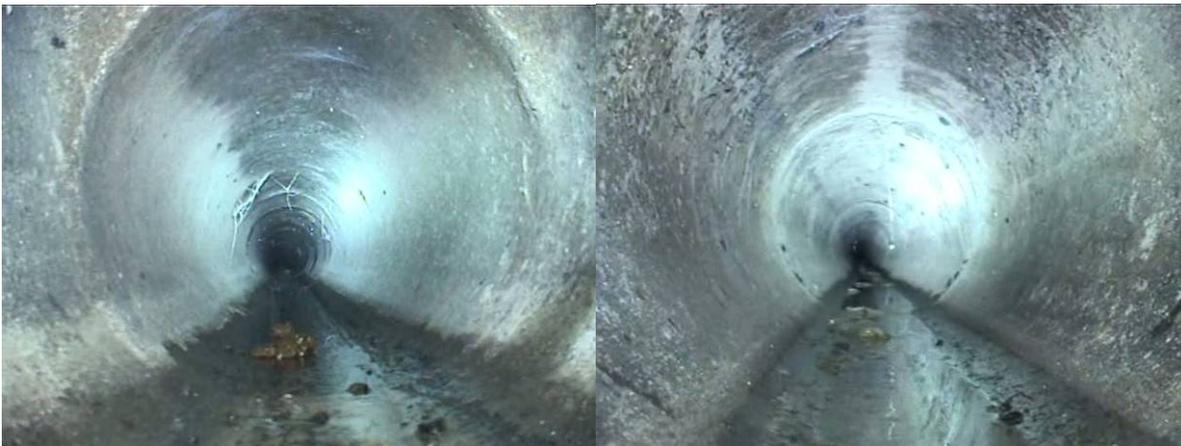
Abbildung 63 Kreisprofil Ablagerung 2,5%
