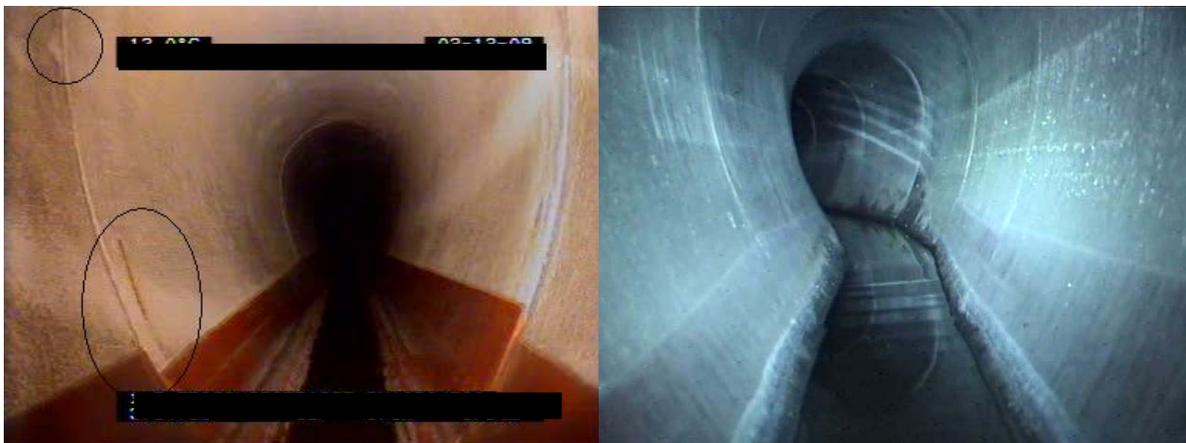
Abbildung 105 Knick (links Kanal-TV, rechts QuickView®)
