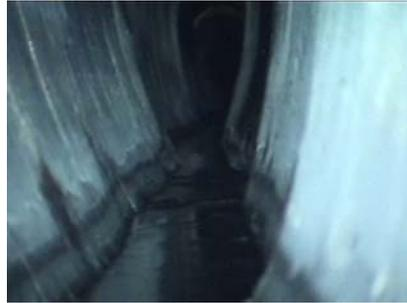
Abbildung 119 ungerader Kanalverlauf
