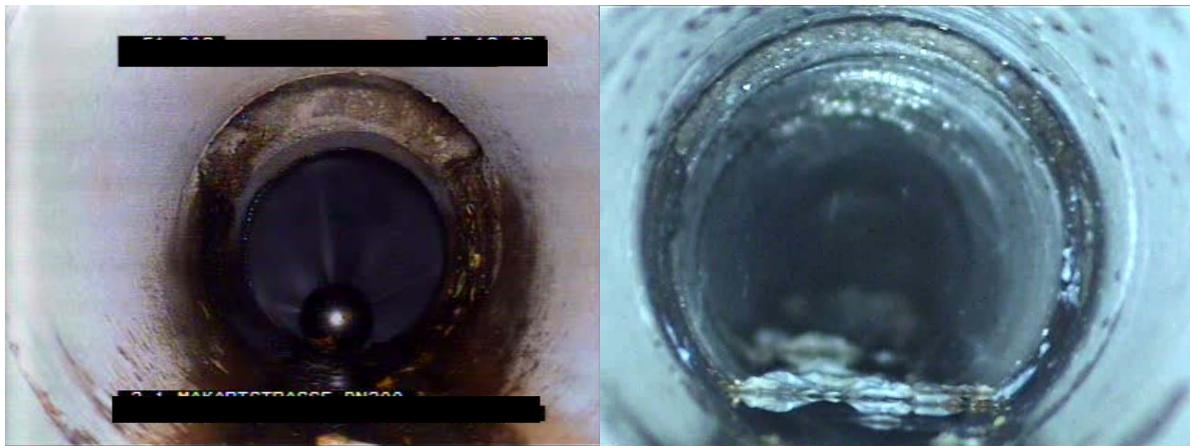
Abbildung 114 Blindschacht, Hochdruckdüse der Kanalreinigung sichtbar
