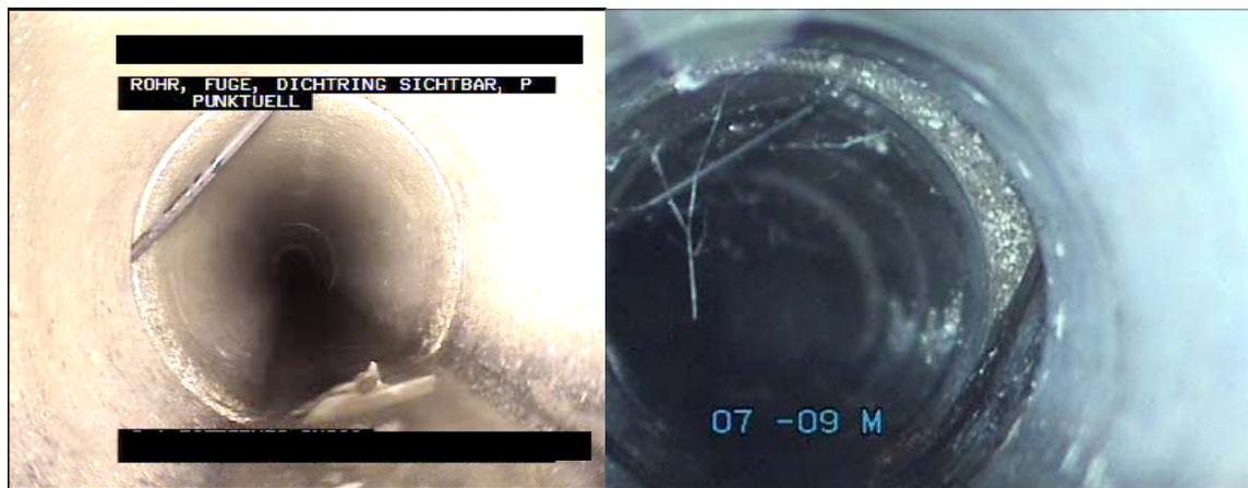
Abbildung 98 Dichtring sichtbar (links Kanal-TV, rechts QuickView®)
