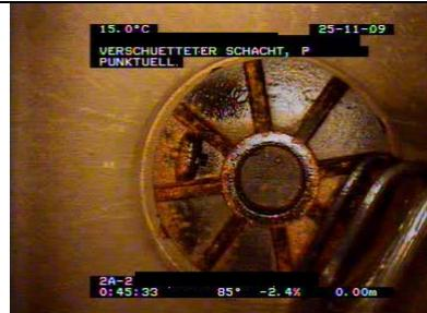
Abbildung 136: TV, Verschütteter Schacht (bei 25m)
