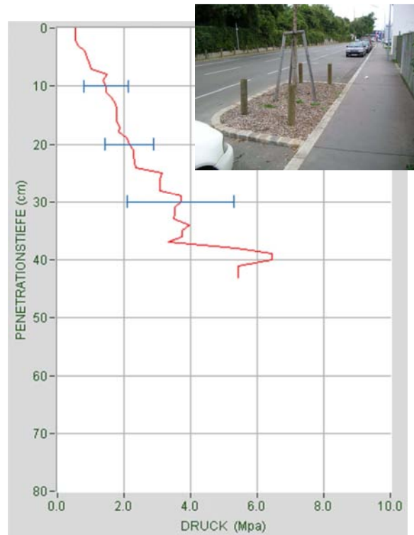
Abb. 160: Mittelwert der Messungen des Eindringwiderstandes in den Boden (Hackinger Straße, Wien, 14. Bezirk, 2009)
