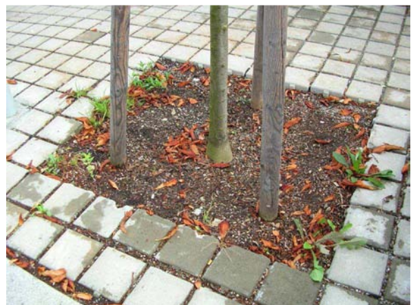
Abb. 136: teilversiegeltes Baumumfeld - diese Alternative zu geschlossenen Asphaltdecken auf Gehsteigen und Parkstreifen sorgt für verbesserte Boden- und Standortbedingungen (Wien, 14. Bezirk, Sept. 2008)
