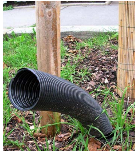
Abb. 107: herausragendes Bewässerungs- und Belüftungsrohr - in diesem Fall ohne Abdeckkappe (Wien, 13. Bezirk, Sept. 2008)
