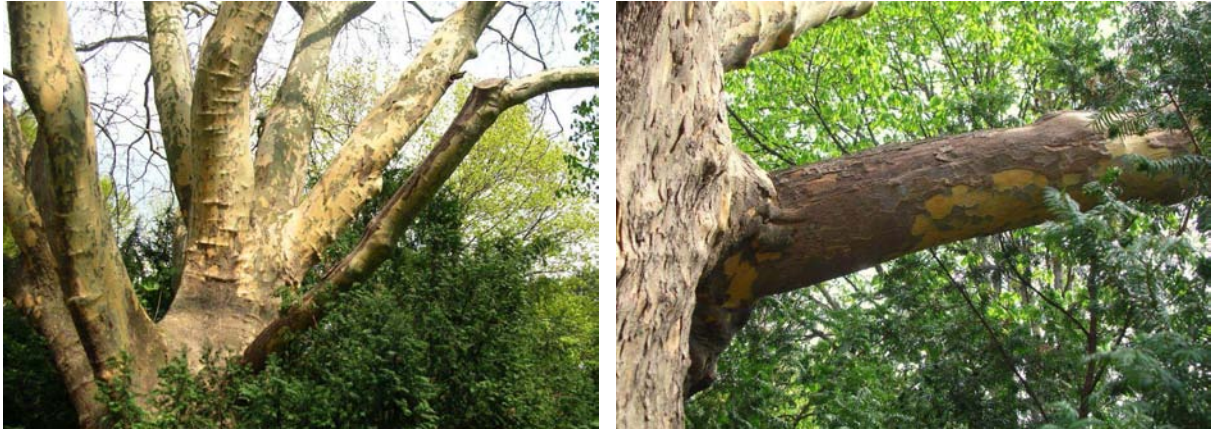
Abb. 217-218: von Massaria befallene Platane im Türkenschanzpark in Wien - die Oberseite eines der untersten Starkäste (im linken Bild rechts) zeigt bereits starke Rindennekrosen, für Passanten geht davon jedoch keine Gefahr aus (Wien, April 2010)
