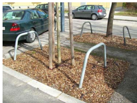
Abb. 97: Baumbügel halten Autos von der Baumscheibe fern (Wien, 13. Bezirk, März 2009)
