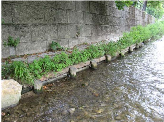
Abb. 91: zeigt einen Rangenverbau am Mödlingbach 2009
