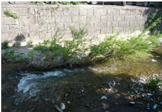
Abb. 70: Bauwerk der Zustandsklasse 1, Mödlingbach, 2009
