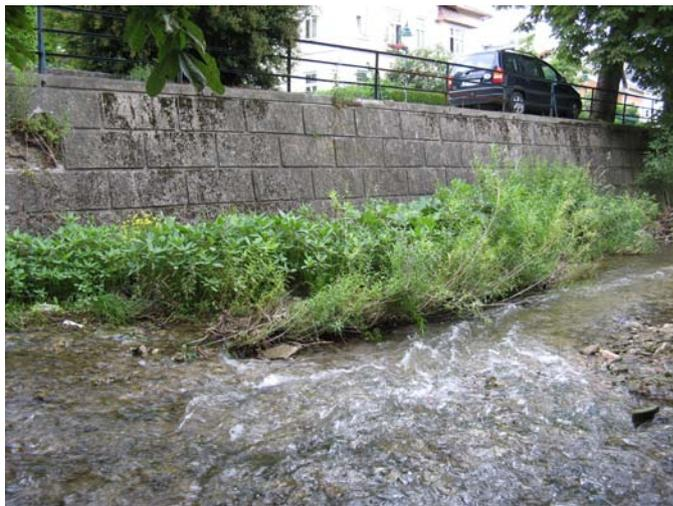
Abb. 90: Erhöhung der Fließgeschwindigkeit durch einen Flechtzaun, Mödlingbach 2009
