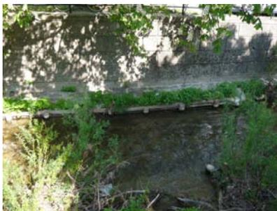
Abb. 74: Wirkungsklasse 1, Rangenverbau – Mödlingbach 2009
