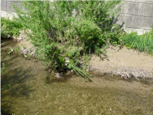
Abb. 55: durch eine Buhne hervorgerufene Ruhigwasserzone, Mödlingbach 2009
