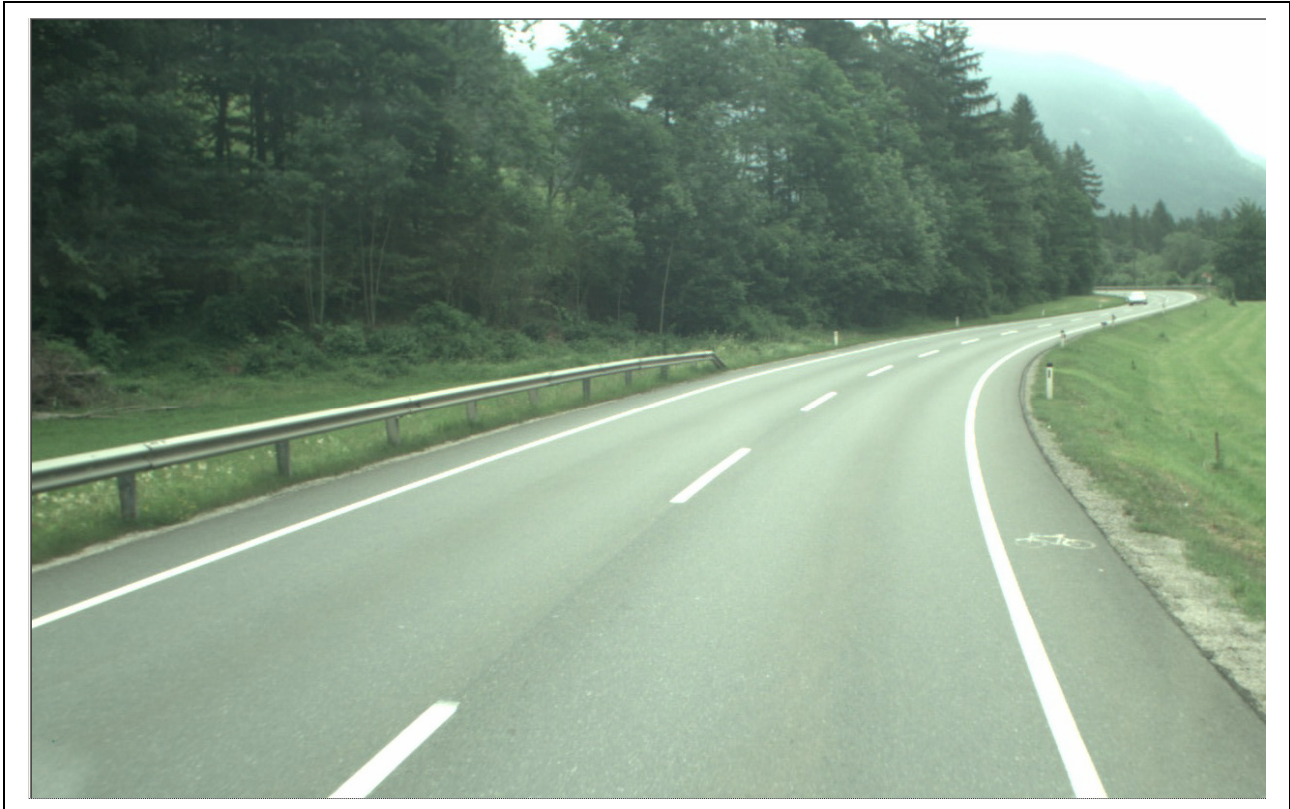
Abbildung 6.5-3: Radfahrstreifen auf der B 162 bei km 5,1; Aufnahme­richtung r +
