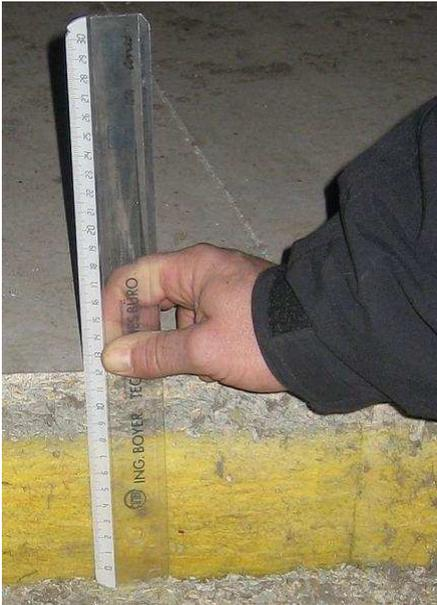
Abbildung 61: oberste Geschößdecke mit Wärmedämmung und Holzwolle-Leichtbauplatten
