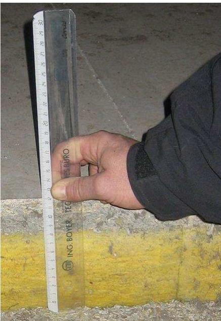
Abbildung 18: oberste Geschoßdecke mit Wärmedämmung und Holzwolle-Leichtbauplatten
