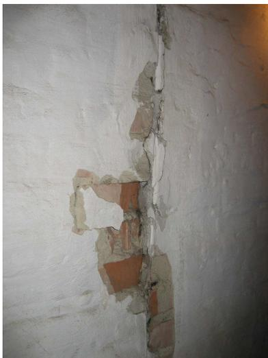
Abbildung 15: Kaminwand aus Vollziegeln, auf der Kellerseite pattschokkiert
