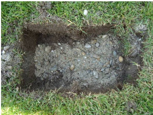
Abb. 62: Unterbau/ Drainage Körnung 0/16, 07/2010
