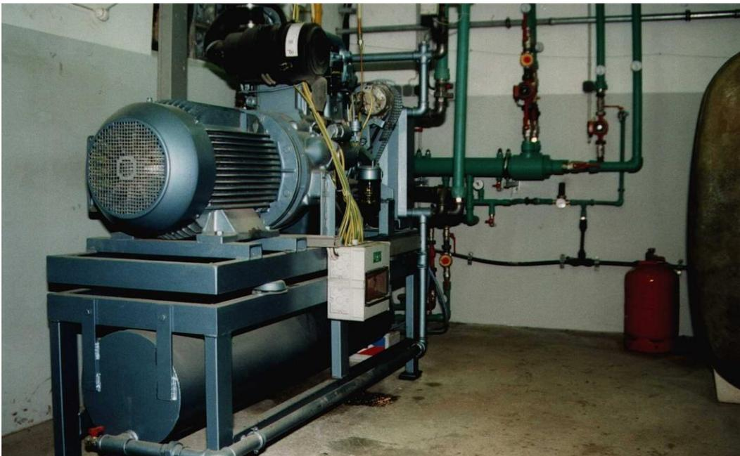
Abbildung 7: Zündstrahl- Blockheizkraftwerk (EGGERSGLÜB und KRASCHINSKI, 2001)
