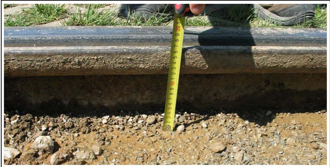
Abbildung 17: Tiefe der Betonwanne des Straßenbahngleiskörpers in der Conrad von Hötzendorfstraße. Die Tiefe ist mit 16 cm begrenzt, woraus sich die Höhe der Vegetationstragschicht ergibt (SCHARF Mai 2009).
