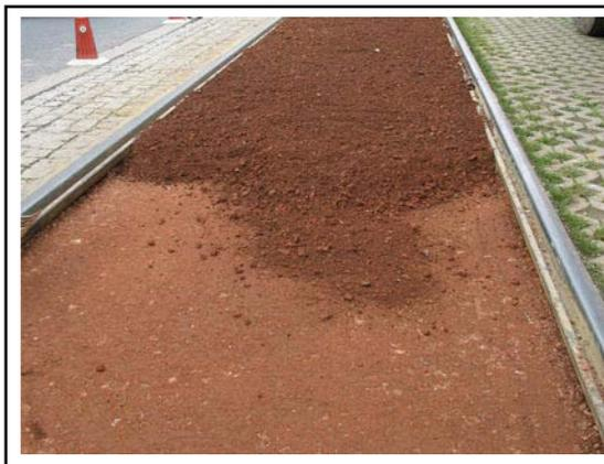
Abbildung 29: Verdichtete untere und unverdichtete obere Vegetationstragschicht. Nach der Verdichtung der unteren Tragschicht wurde die obere aufgebracht und ebenfalls eingeebnet (SCHARF Mai 2009).
