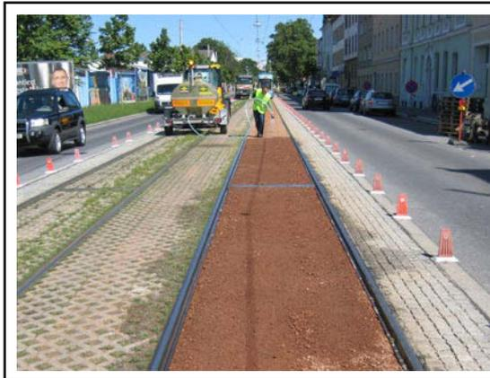
Abbildung 62: Anfeuchten des Substrats. Vor der Ansaat wurde das Substrat benetzt, um das Anhaften des Saatguts zu begünstigen (SCHARF Mai 2009).
