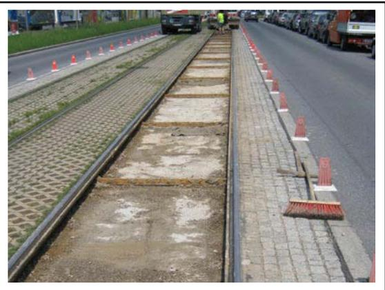
Abbildung 26: Gesäubertem Gleiskörper. Das Unterbaumaterial der Rasengittersteine wurde aus der Betonwanne des Geiskörpers entfernt (SCHARF Mai 2009).
