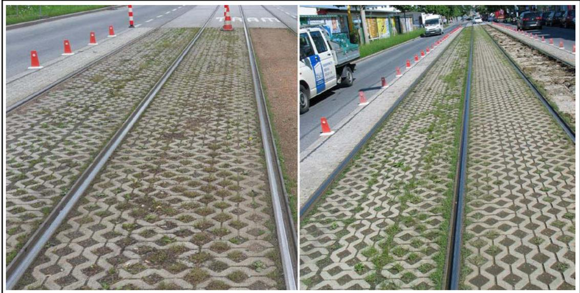
Abbildung 10: Zustand der Gleisbegrünung mit Rasengittersteinen in der Conrad von Hötzendorfstraße im Mai 2010 (links) und im Mai 2009 (rechts). Die Fotos zeigen die lückenhafte Vegetation auf den Rasengittersteinen, die im Zuge des Versuchsprojektes teilweise durch eine Schotterrasenbauweise ersetzt wurde, wie in den jeweils rechten Bildrändern zu sehen ist. Beide Fotos wurden in Richtung Stadtzentrum aufgenommen.
