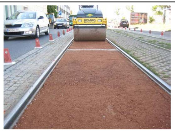
Abbildung 30: Verdichtung der oberen Vegetationstragschicht in der Conrad von Hötzendorfstraße. Die Verdichtung erfolgte mit einer statischen Glattwalze. Die Höhe der oberen Tragschicht entspricht der Schienenoberkante (SCHARF Mai 2009).
