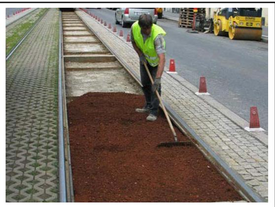
Abbildung 28: Einebnen des Recyclingmaterials. Mittels Rechen wurde das Material gleichmäßig verteilt (SCHARF Mai 2009).
