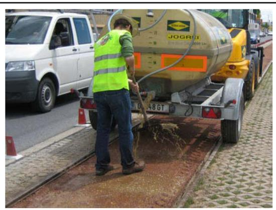
Abbildung 67: Aufbringen des organischen Klebers mittels Schaufel als Prallkörper (SCHARF Mai 2009).
