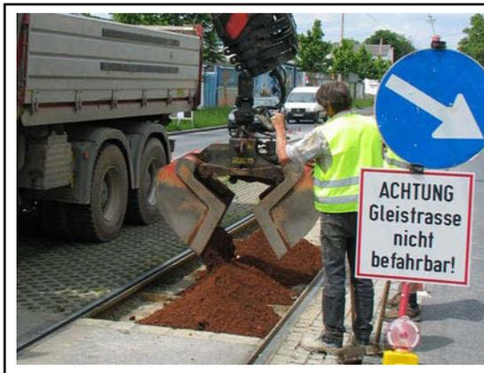
Abbildung 27: Aufbringung des Recyclingmaterials. Das Material wurde vom LKW per Greifer direkt in die Versuchsstrecke eingebracht (SCHARF Mai 2009).
