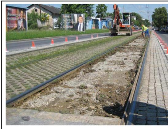
Abbildung 25: Entfernen der Rasengittersteine auf der Versuchsstrecke in der Conrad von Hötzendorfstraße in Graz. Die Rasengittersteine wurden dabei zerstört (SCHARF Mai 2009).
