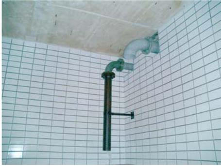
(a) Zulauf zur Wasserkammer
