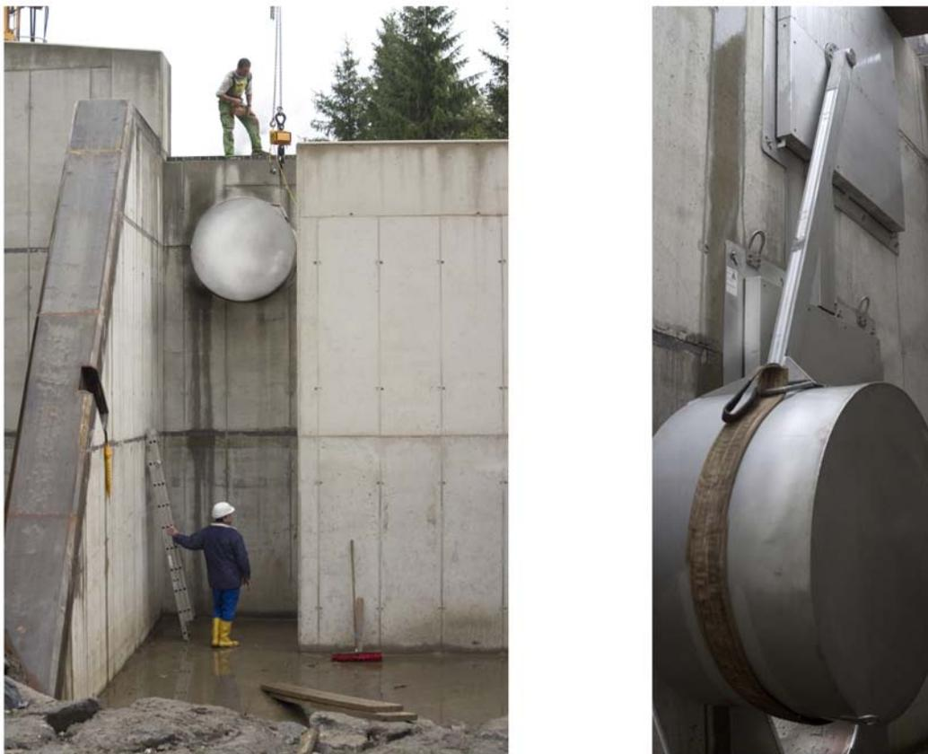
Abbildung 15.2: Ein *HydroSlide VN Abflussregler* bei der Abnahme und im Ruhezustand
