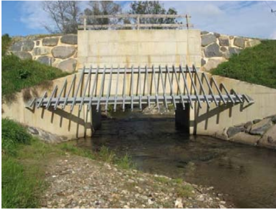
Abbildung 58: Grundablass - Offene Bauweise
