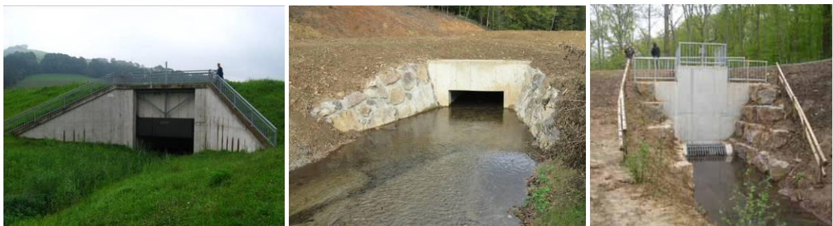
Abbildung 83: links: Betonwände, Mitte: Betongrobsteinschlichtung (Bauzustand) rechts: Steinschlichtung (rechtes Bild: LUBW, 2006)
