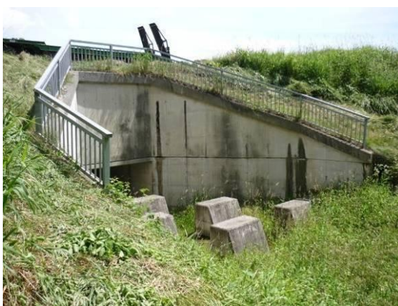
Abbildung 16: links: Tosbecken mit Einbauten (Bremshöcker), rechts: Tosbecken mit Wasserbausteinen gesichert
