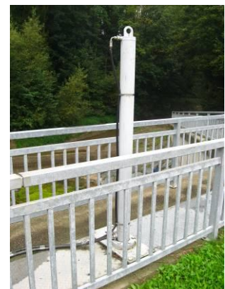
Abbildung 51: links: Verschlammungsgefahr der Drucksonde im Einlaufbauwerk, rechts: hoch angeordnete Huborgane
