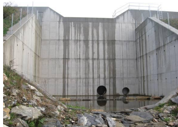
Abbildung 105: Tosbecken von Sperrenbauwerken: mit Endschwelle und NW-Rinne, rechts: mit ständigem Wasser (Wasserpolster für Entlastungssektion)
