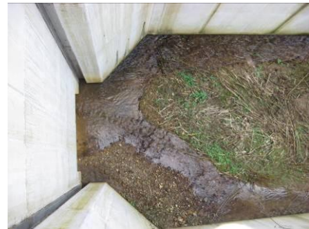
Abbildung 82: links: Trapezeinlauf, rechts: Kombination Rechteck- Trapezeinlauf
