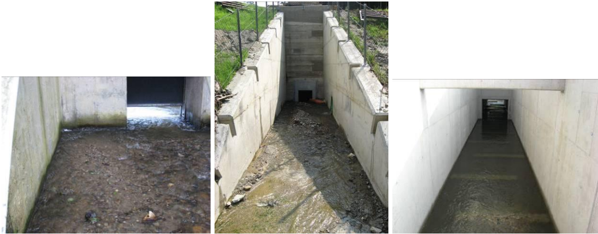
Abbildung 84: links: GSS Sohle mit natürlichem Sohlsubstrat, Mitte: Betonsohle (glatt), rechts: strukturierte Einlaufsohle
