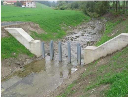
Abbildung 71: Rechen an der Stauwurzel
