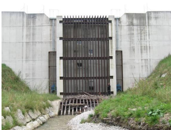
Abbildung 67: links: massiver Stahlrechen (Wildbacheinzugsgebiet), rechts: Einlaufrechen ist nicht erforderlich (Weinbaugebiet)
