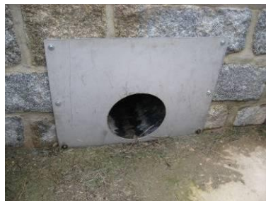
Abbildung 93: Drosselung links: Grundablassquerschnitt (luftseitig), Mitte: Blende (angeschraubt), rechts: Tauchwand
