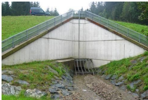
Abbildung 82: links: Trapezeinlauf, rechts: Kombination Rechteck- Trapezeinlauf
