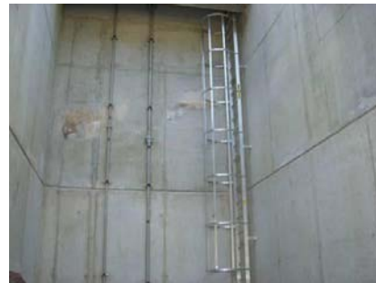
Abbildung 75: links: Stiege für Wartungszwecke, rechts: Einstiegsleiter mit Sicherheitskorb
