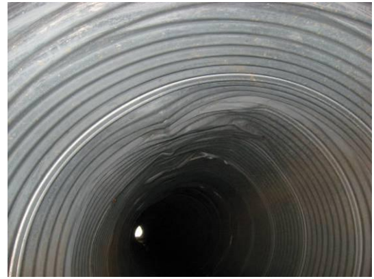
Abbildung 18: links: Rohrverformung im Übergangsbereich Betonwand – Kiesbettung, rechts: beschädigtes Durchlassrohr
