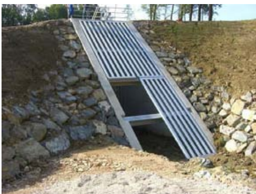
Abbildung 86: links: Einlaufbauwerk mit Schrägrechen in Elementbauweise (ein Rechenelement abgehoben) bis auf Dammhöhe, rechts: kleines Einlaufbauwerk (bis auf Durchlasshöhe)
