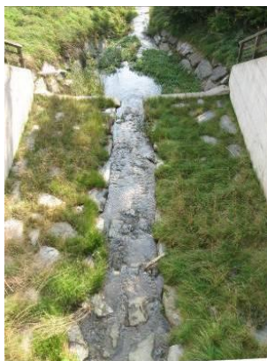
Abbildung 105: Tosbecken von Sperrenbauwerken: mit Endschwelle und NW-Rinne, rechts: mit ständigem Wasser (Wasserpolster für Entlastungssektion)
