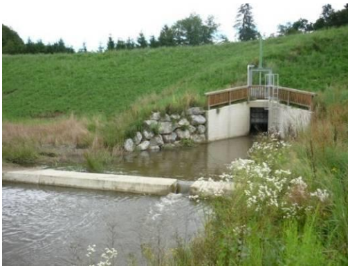
Abbildung 12: Verschlussanordnung luftseitig (Perzplan, 2008)
