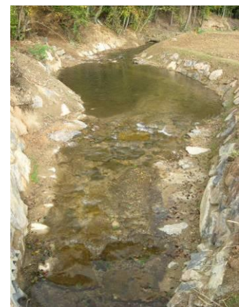
Abbildung 16: links: Tosbecken mit Einbauten (Bremshöcker), rechts: Tosbecken mit Wasserbausteinen gesichert
