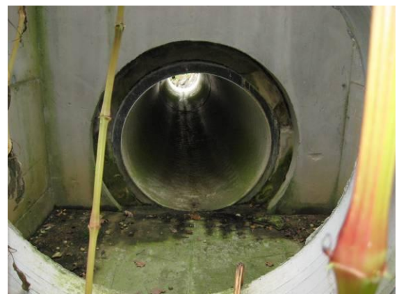
Abbildung 103: links: Stahlspiral-Durchlass, rechts: Kunststoffrohr - Durchlass
