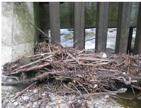
Abbildung 92: links: Rechen bis Sohle, rechts: Rechen reicht nicht bis Sohle
