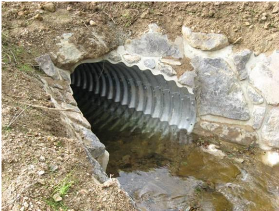
Abbildung 33: Durchlassrohr aus Stahl (links), Kunststoff (rechts)
