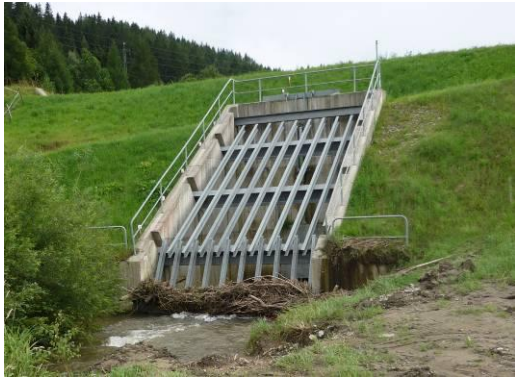
Abbildung 10: wasserseitige Verschlussanordnung
