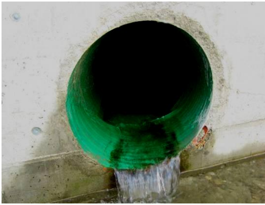
Abbildung 18: links: Rohrverformung im Übergangsbereich Betonwand – Kiesbettung, rechts: beschädigtes Durchlassrohr
