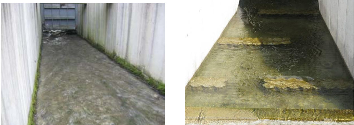
Abbildung 56: links: unstrukturierte Sohle, rechts: strukturierte Sohle mittels Querriegeln, Ökogitter - Baustahlmatte um Ausspülen von Sohlsubstrat zu vermeiden
