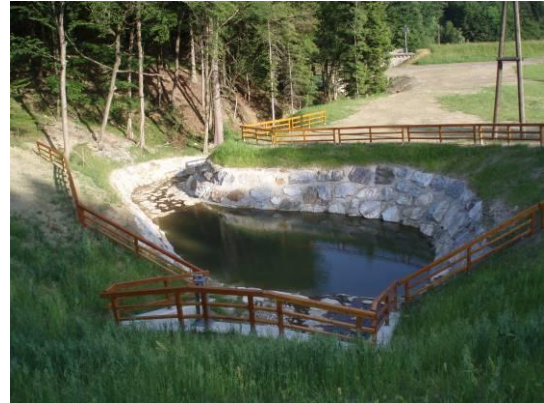
Abbildung 104: links: Bremshöcker, rechts: Tosbecken mit ständigem Wasser
