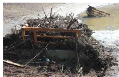
Abbildung 76: links: Geländer in Entfernung zu Rechen, rechts: Verklauter Grundablass nach Hochwasserereignis (Geländer direkt am Einlaufbauwerk)
