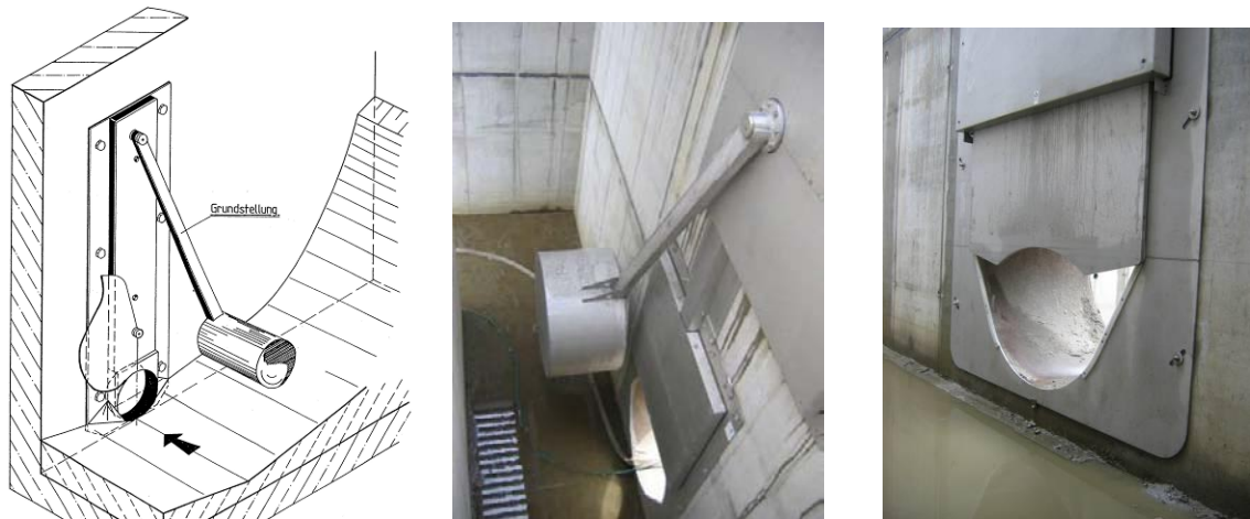
Abbildung 43: Hydroslide-Abflussregler links: Skizze (Fa. Steinhardt, 2008)
