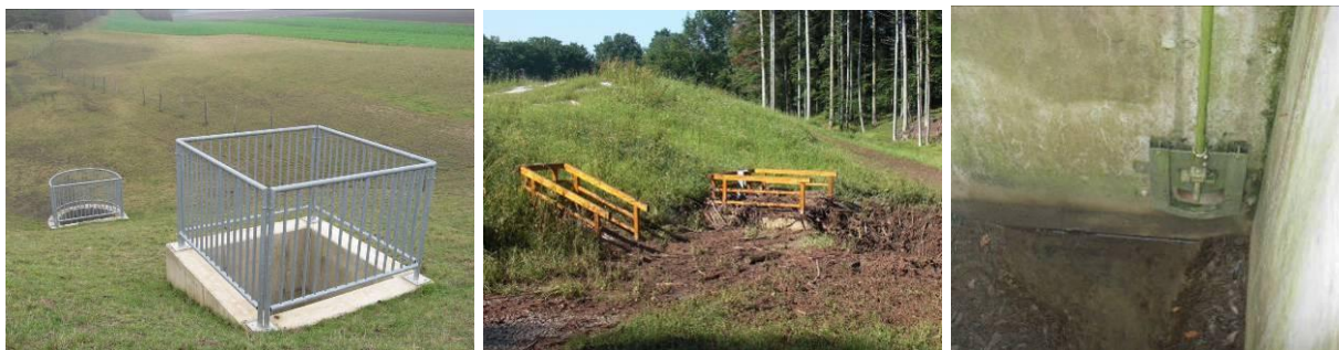
Abbildung 97: Bypass Situierung, links: Höhe Dammkrone (HW-Entlastung), Mitte: Bypass im Schwemmholtz-Akkumulationsbereich des Grundablasses, rechts: innerhalb des Grundablass-einlaufes
