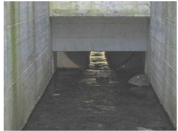
Abbildung 101: links Maulprofil, rechts: Anschluss Einlaufbauwerk-Kreisdurchlass mit Toträumen
