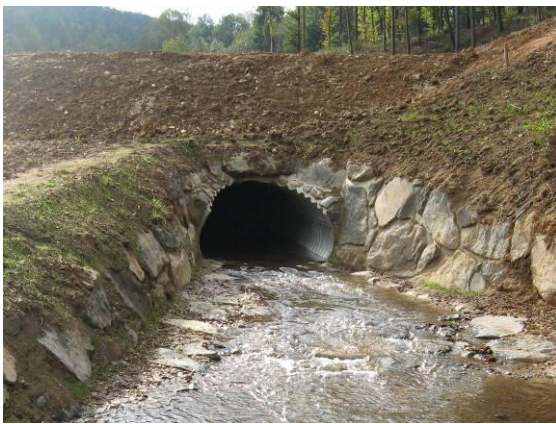
Abbildung 101: links Maulprofil, rechts: Anschluss Einlaufbauwerk-Kreisdurchlass mit Toträumen
