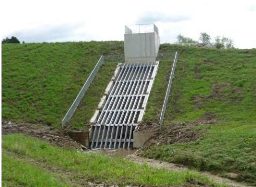
Abbildung 11: mittige Verschlussanordnung (mit Bedienungsschacht)
