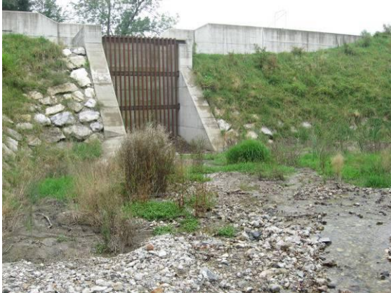
Abbildung 63: links: Anlandungen im Einlaufbereich durch fehlendes Gerinneprofil (Aufweitung), rechts: Gerinneprofilvorgabe durch Grobsteinschlichtung
