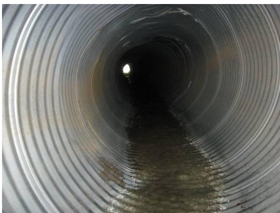
Abbildung 103: links: Stahlspiral-Durchlass, rechts: Kunststoffrohr - Durchlass
