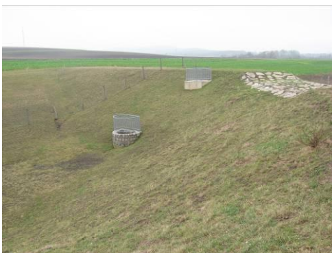
Abbildung 85: Absetzbecken – Einlaufbauwerk auf erhöhtem Niveau
