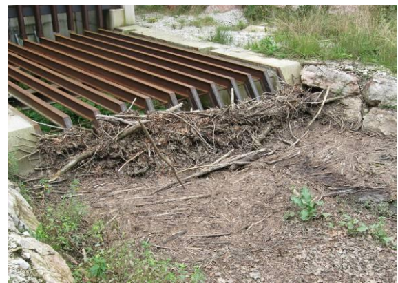
Abbildung 88: links: gebrochener Rechen auf I-Trägern(Holz schwimmt auf), rechts: 1. Rechenabschnitt zu steil (kein Aufschwimmen des Wildholzes)
