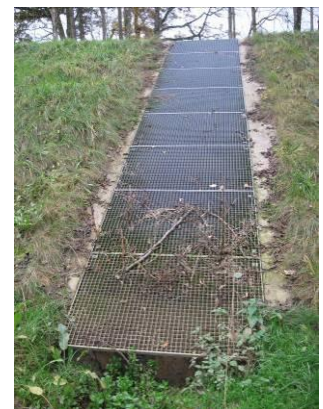
Abbildung 89: links: Gebrochener Rechen auf Verbundträger, Mitte: Rechenkorb, rechts: Schrägrechen aus Gitterrostelementen (kein Geländer nötig)
