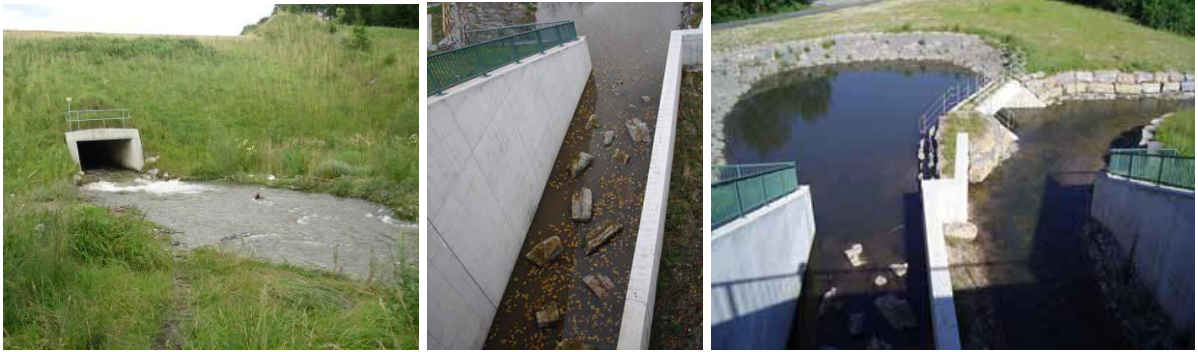
Abbildung 106: links: ökologisch verträgliches Tosbecken ohne ständigem Wasser, Mitte: Störsteine zur Energieumwandlung im Betriebsauslass, rechts: Tosbecken des Betriebsauslasses, Ökogerinne ohne Tosbecken (mittleres und rechtes Bild LUBW, 2006)
