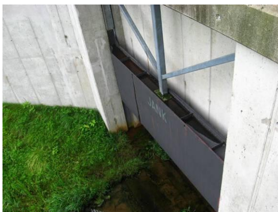
Abbildung 50: Verschlusstyp - Schütz
