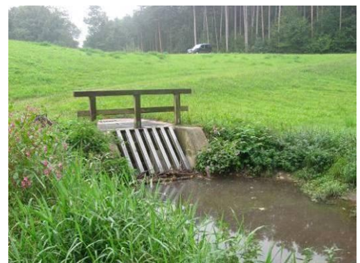
Abbildung 86: links: Einlaufbauwerk mit Schrägrechen in Elementbauweise (ein Rechenelement abgehoben) bis auf Dammhöhe, rechts: kleines Einlaufbauwerk (bis auf Durchlasshöhe)
