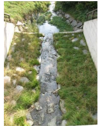
Abbildung 64: links: Ablagerungen in Toträumen neben Durchlassöffnung, rechts Niederwasserrinne
