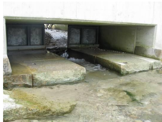
Abbildung 102: links: alternierende Rasengittersteine mit „Ökogitter“(Baustahlmatte) im Bauzustand, rechts: Granitplatten in Beton
