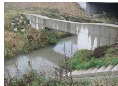
Abbildung 93: Drosselung links: Grundablassquerschnitt (luftseitig), Mitte: Blende (angeschraubt), rechts: Tauchwand
