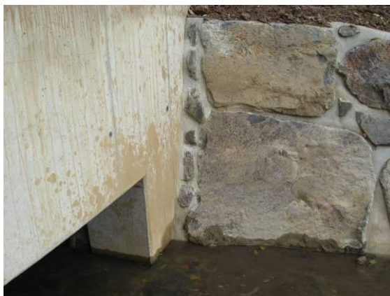
Abbildung 34: links: Einlaufbereich mit GSS in Beton, rechts HW-Entlastung mit GSS in Beton gesichert (Auslaufseite)
