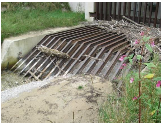
Abbildung 65: links: Sedimentation aufgrund Rechenführung bis Gewässersohle, rechts: keine Anlandung - Rechen nicht bis zur Sohle geführt
