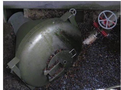
Abbildung 47: links: Modellversuch Schwingklappe unter Einfluss von Geschiebetrieb (Bernhart et. al., 2009), rechts: Wirbeldrossel mit einer Einlauföffnung
