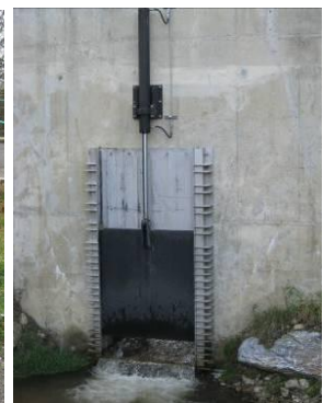
Abbildung 37: links: Drosselblende, mitte: Dammbalken, rechts: Schütz
