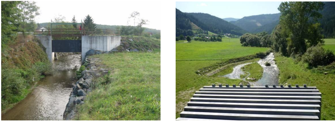
Abbildung 62: links: Absperrbauwerk mit Streichwehr eines HRB im Nebenschluss um natürlichen Geschiebetrieb aufrecht zu erhalten, rechts: Ausschotterungsbecken vor Grundablass
