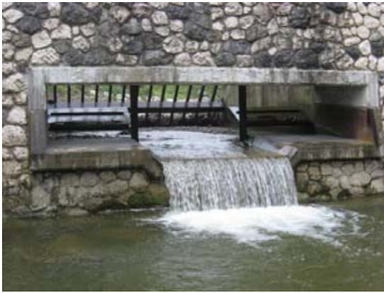
Abbildung 57: Unterbindung der Längsdurchgängigkeit durch Sohlstufen
