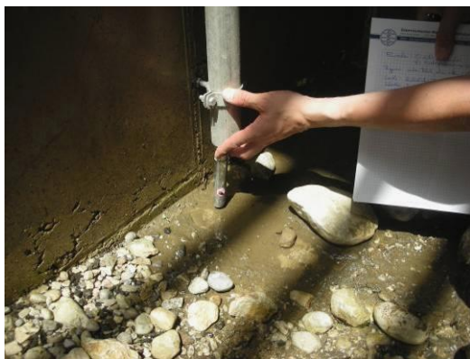
Abbildung 51: links: Verschlammungsgefahr der Drucksonde im Einlaufbauwerk, rechts: hoch angeordnete Huborgane
