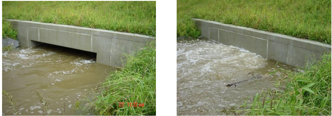
Abbildung 25: Auslaufseite, Übergang von Freispiegelabfluss (links) zu Druckabfluss (rechts) durch Öffnen des Schützes bei HW-Ereignis (Ktn. Landesregierung, Uabt. Klagenfurt)
