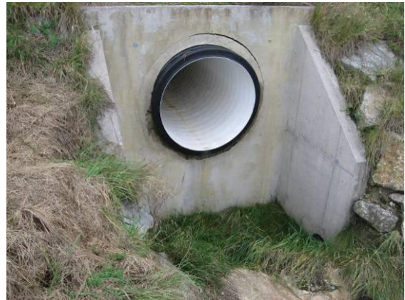
Abbildung 33: Durchlassrohr aus Stahl (links), Kunststoff (rechts)
