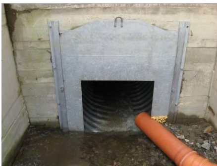
Abbildung 94: Verschlusstyp: links: Drosselblende (ziehbar), Mitte: Dammbalken, rechts: Gleitschütz manuell verstellbar
