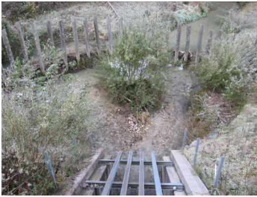
Abbildung 72: vorgelagerter Pfahlrechen
