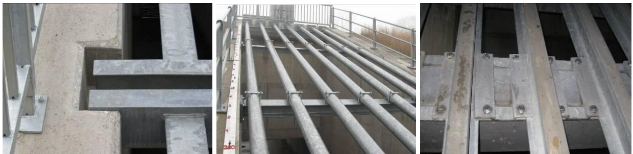
Abbildung 91: links: eingehängtes Rechenelement, Mitte verschraubt, rechts geklemmte Rechenstäbe
