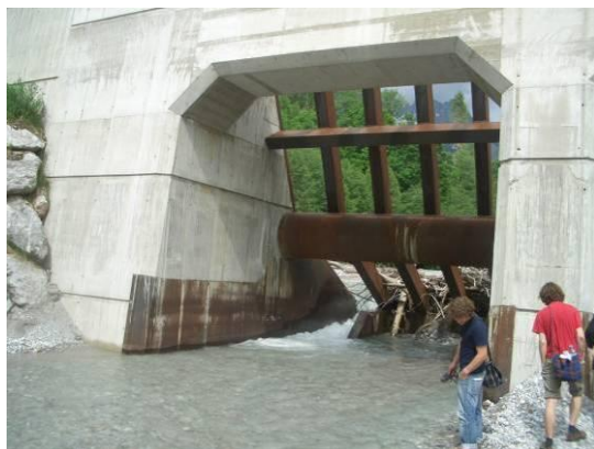
Abbildung 89: links: Gebrochener Rechen auf Verbundträger, Mitte: Rechenkorb, rechts: Schrägrechen aus Gitterrostelementen (kein Geländer nötig)
