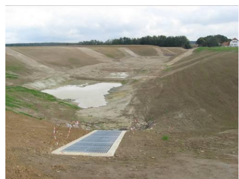
Abbildung 85: Absetzbecken – Einlaufbauwerk auf erhöhtem Niveau
