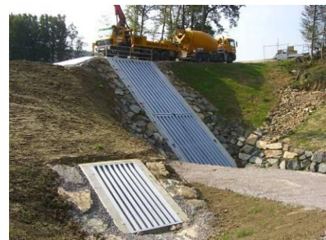
Abbildung 98: links: luftseitig regelbarer, getrennt angeordneter Bypass, rechts: in verklauungssicherer Distanz angebrachter Bypass
