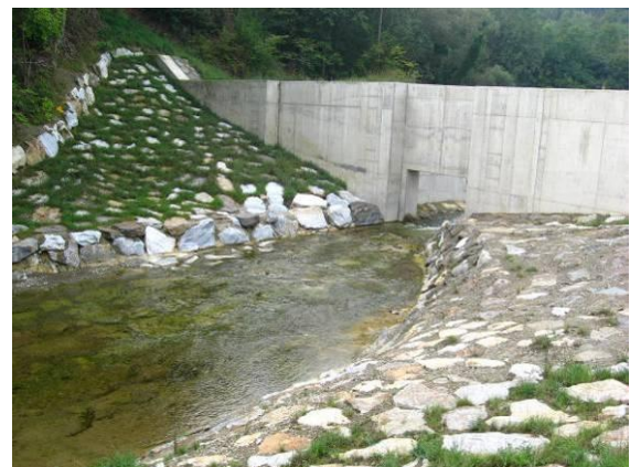
Abbildung 34: links: Einlaufbereich mit GSS in Beton, rechts HW-Entlastung mit GSS in Beton gesichert (Auslaufseite)
