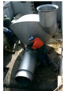
Abbildung 48: links: zwei Einlauföffnungen für, rechts: Wirbeldrossel (OÖ Landesregierung, Gewässerbezirk Braunau)
