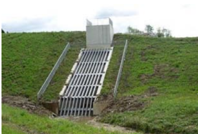
Abbildung 76: links: Geländer in Entfernung zu Rechen, rechts: Verklauter Grundablass nach Hochwasserereignis (Geländer direkt am Einlaufbauwerk)
