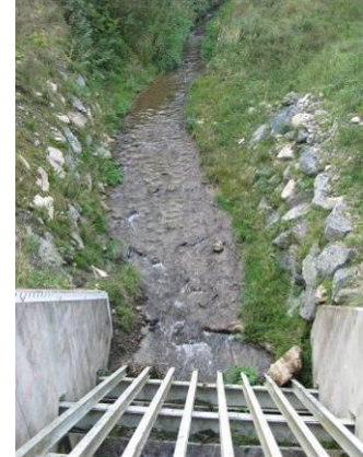
Abbildung 63: links: Anlandungen im Einlaufbereich durch fehlendes Gerinneprofil (Aufweitung), rechts: Gerinneprofilvorgabe durch Grobsteinschlichtung
