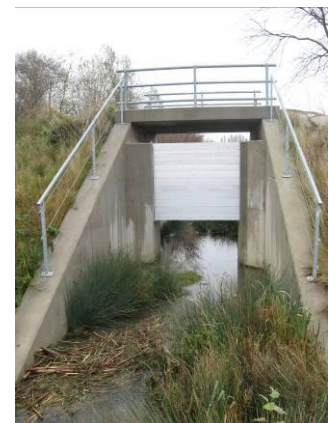
Abbildung 55: Grundablass als gut belichtetes Brückenbauwerk
