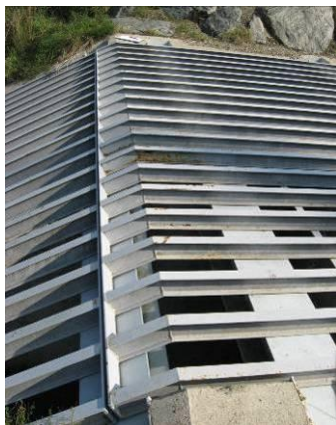
Abbildung 90: links: Rechendetail (gebrochener Rechen in Elementbauweise), Mitte: abhebbare Rechenteile, rechts: entfernbare Rechenelement für Räumzwecke mittels Kleinbagger
