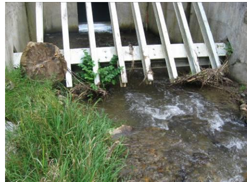
Abbildung 92: links: Rechen bis Sohle, rechts: Rechen reicht nicht bis Sohle
