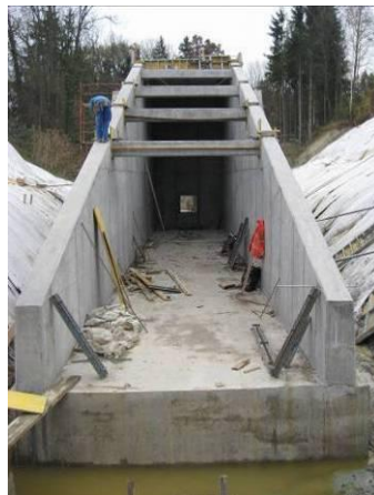
Abbildung 19: Fundament Grundablassbauwerk
