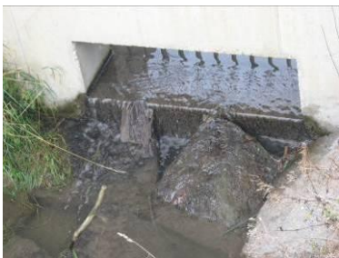
Abbildung 93: Drosselung links: Grundablassquerschnitt (luftseitig), Mitte: Blende (angeschraubt), rechts: Tauchwand
