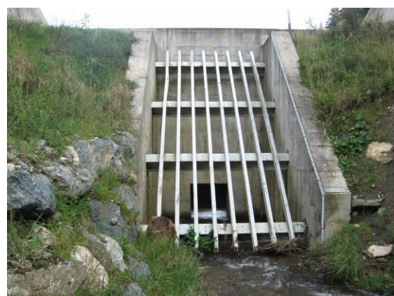
Abbildung 65: links: Sedimentation aufgrund Rechenführung bis Gewässersohle, rechts: keine Anlandung - Rechen nicht bis zur Sohle geführt
