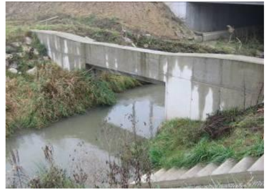
Abbildung 36: links: Grundablassquerschnitt, rechts: Tauchwand
