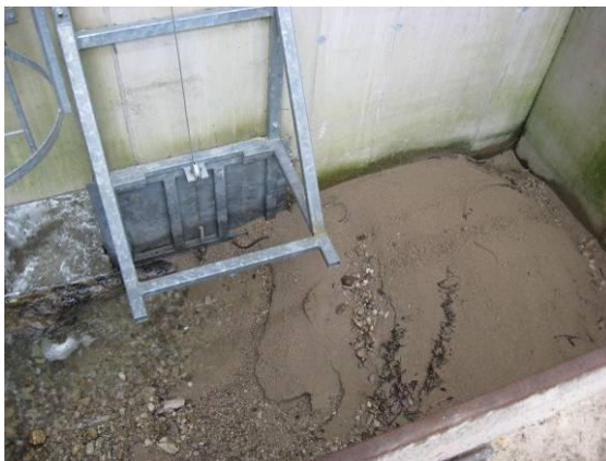
Abbildung 64: links: Ablagerungen in Toträumen neben Durchlassöffnung, rechts Niederwasserrinne
