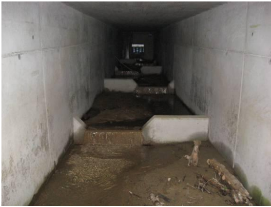
Abbildung 100: links Rechteckprofil mit strukturierter Sohle, rechts: Kreisprofil unstrukturiert
