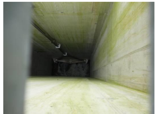
Abbildung 11: mittige Verschlussanordnung (mit Bedienungsschacht)
