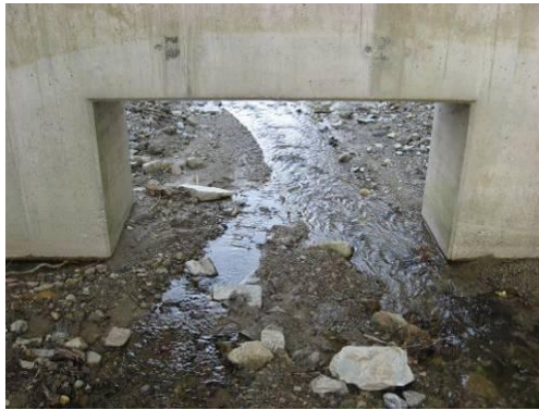
Abbildung 36: links: Grundablassquerschnitt, rechts: Tauchwand
