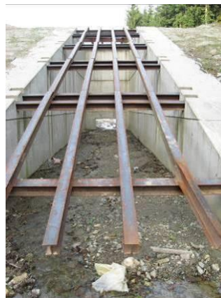
Abbildung 90: links: Rechendetail (gebrochener Rechen in Elementbauweise), Mitte: abhebbare Rechenteile, rechts: entfernbare Rechenelement für Räumzwecke mittels Kleinbagger
