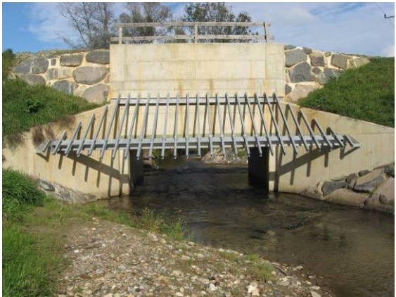
Abbildung 22: Grundablässe bei Trockenbecken
