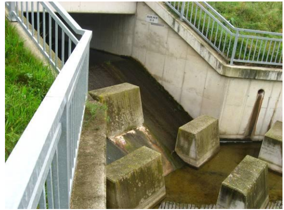
Abbildung 57: Unterbindung der Längsdurchgängigkeit durch Sohlstufen
