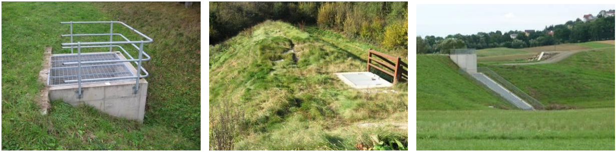
Abbildung 96: links: Kombinationsbauwerk, Mitte: HW-Entlastung über Grundablass situiert (Geländer im Überströmbereich), rechts: HW-Entlastung neben Grundablass situiert
