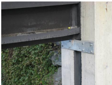
Abbildung 8: links: Abstandshalter, rechts: gedrosselter Querschnitt mittels Stahlblende
