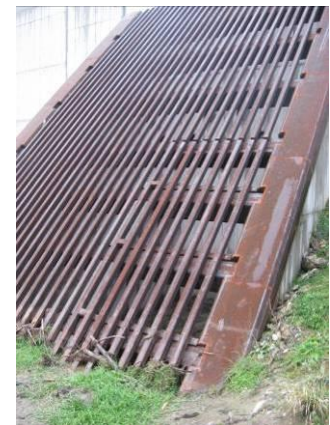
Abbildung 90: links: Rechendetail (gebrochener Rechen in Elementbauweise), Mitte: abhebbare Rechenteile, rechts: entfernbare Rechenelement für Räumzwecke mittels Kleinbagger
