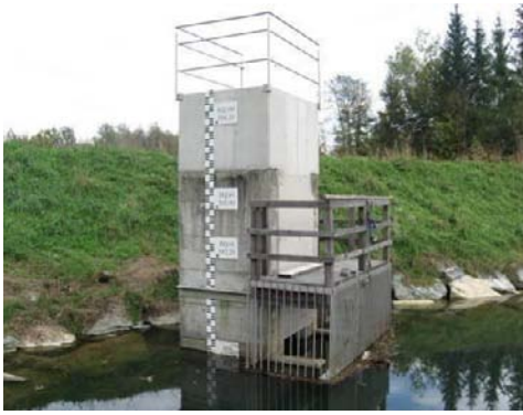
Abbildung 81: links: Mönch, rechts: Rechteckeinlaufbauwerk
