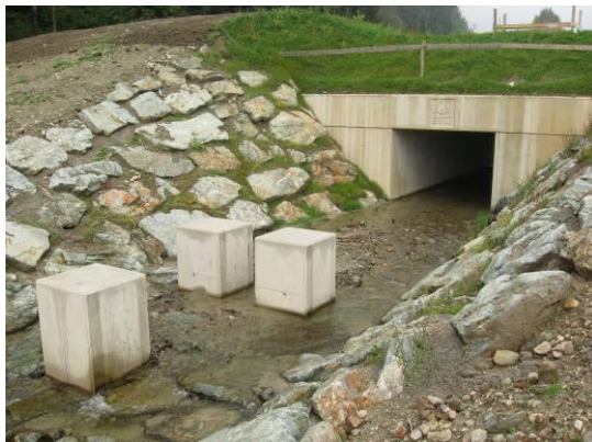
Abbildung 104: links: Bremshöcker, rechts: Tosbecken mit ständigem Wasser
