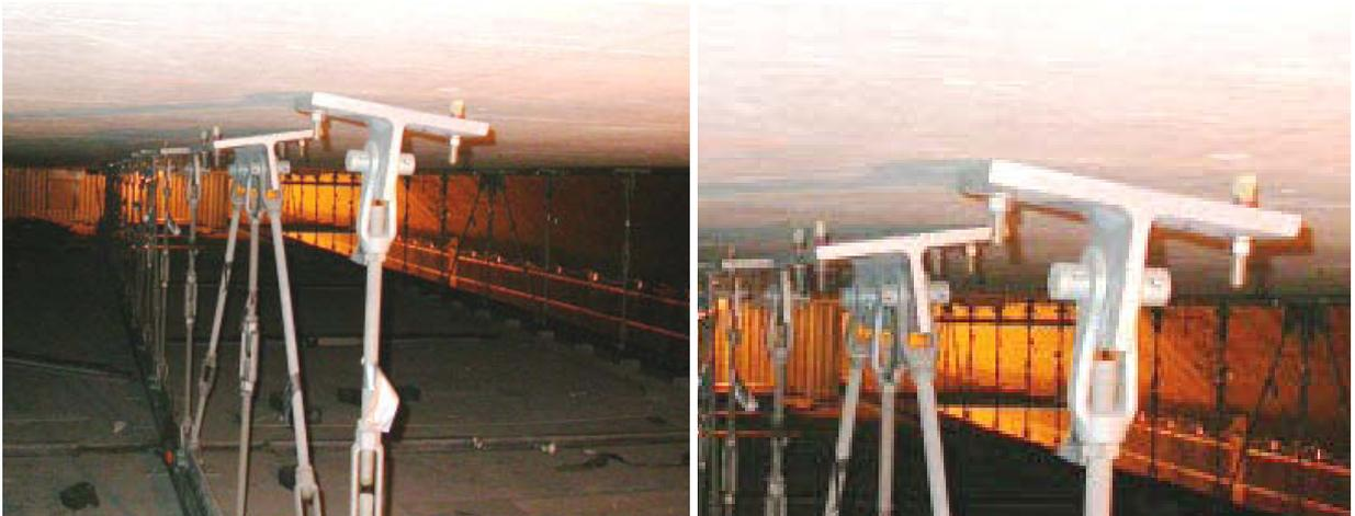
Abbildung 2: Langzeitverformung der Deckenbefestigung, (National Transportation Safety Board [18])
