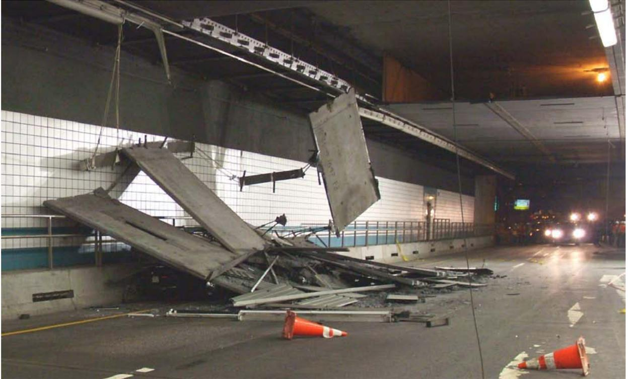
Abbildung 1: Herabgestürzte Deckenelemente, (National Transportation Safety Board [18])
