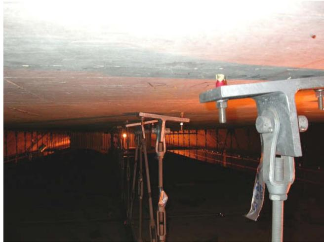
Abbildung 17: Versagen der Aufhängung im Boston Tunnel, (National Transportation Safety Board [18])
