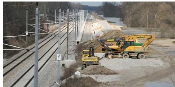
Abbildung 2: Schutz der Infrastruktur mit Hilfe von Dämmen
