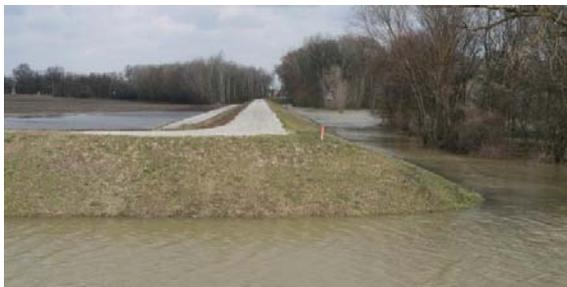
Abbildung 1: Beispiel eines Hochwasserschutzdammes zur Zeit eines Hochwassers
