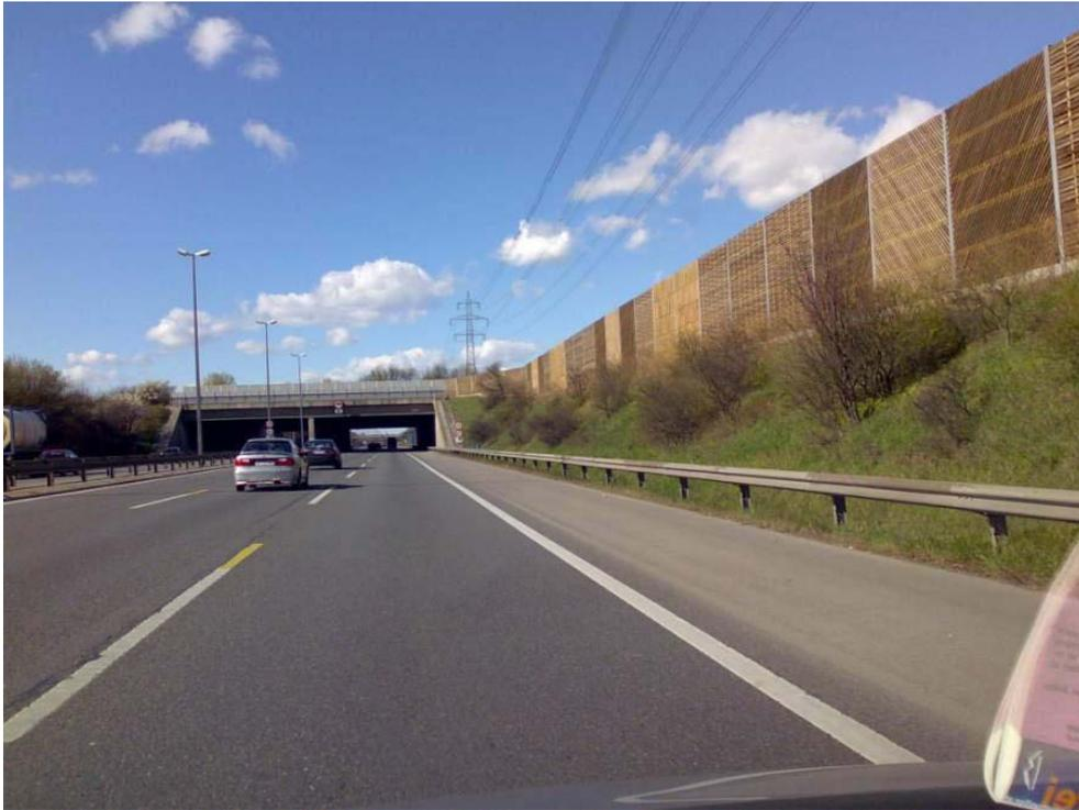
**Abbildung 2: Erdwall mit aufgesetzter Lärmschutzwand bei Langenzersdorf**
