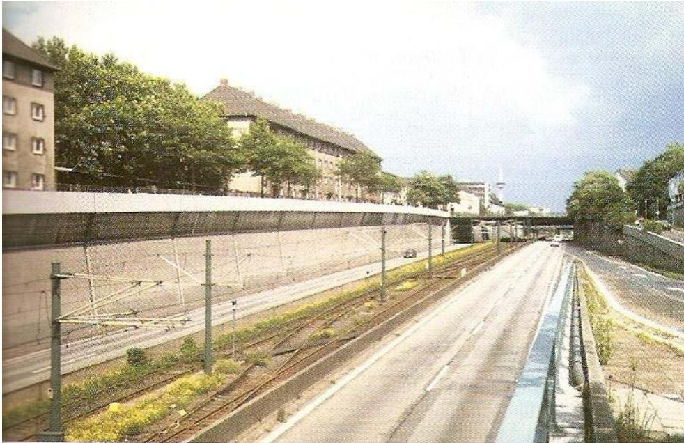
**Abbildung 6: Beispiel für einen Lärmschutztrog**
