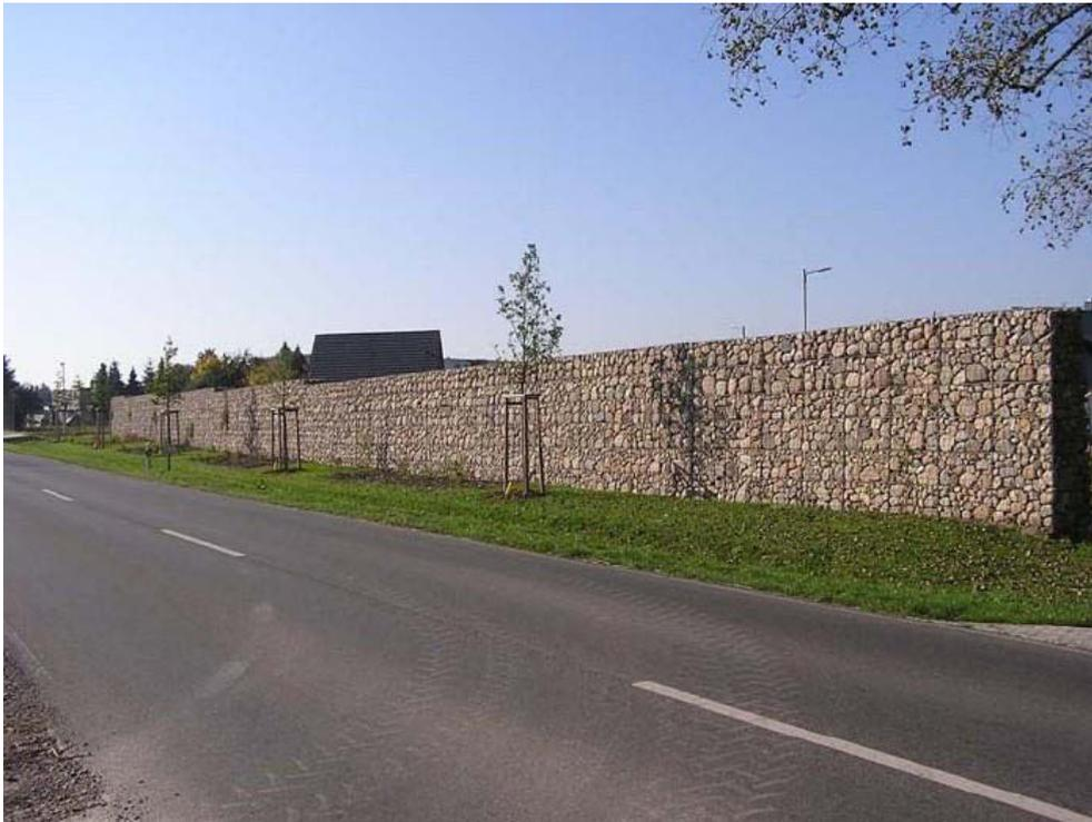
**Abbildung 17: Lärmschutz mittels Drahtsteinkörben**
