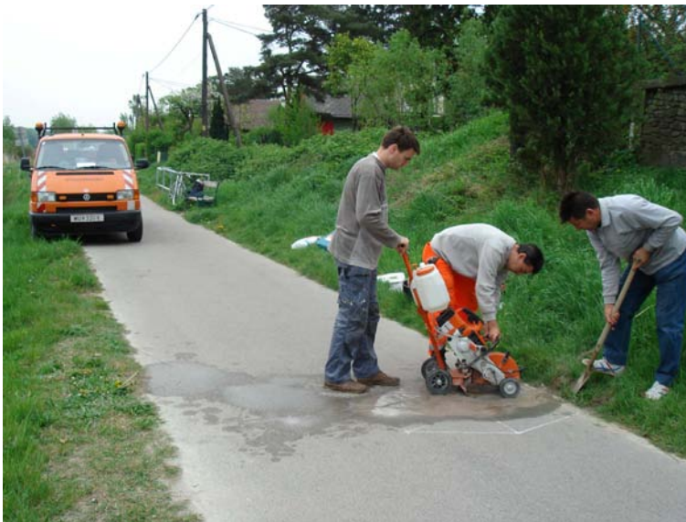
Abbildung 1.7: Schneiden der Fugen mittels Trennschleifer
