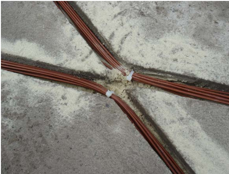
Abbildung 1.9: Großaufnahme der Induktionsdrähte, jeweils acht Schlingen pro Schleife
