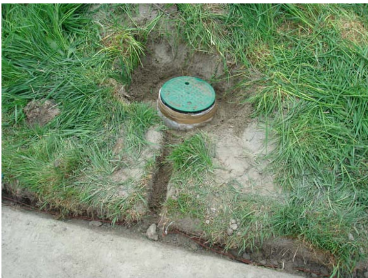
Abbildung 1.11: Kunststoffschacht und Zuleitung der Drähte
