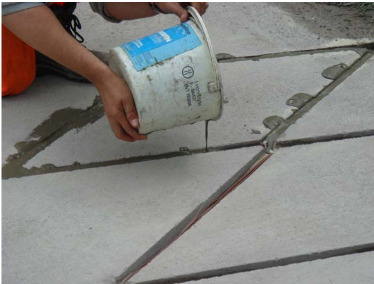
Abbildung 1.10: Verfüllung der Fugen mit Blitzzement
