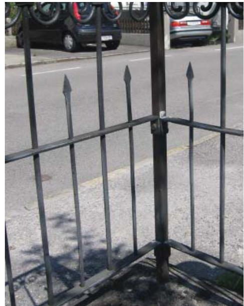
Abb. 63: Die Verbindung der Leisten an den Stehern erfolgt mittels Schrauben.
