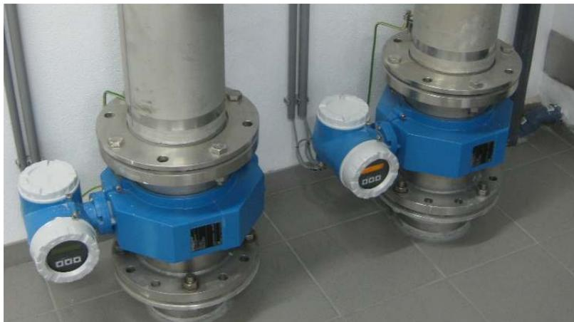
Abbildung 4-33: Magnetisch-Induktive Durchflussmessung (Schitter)
