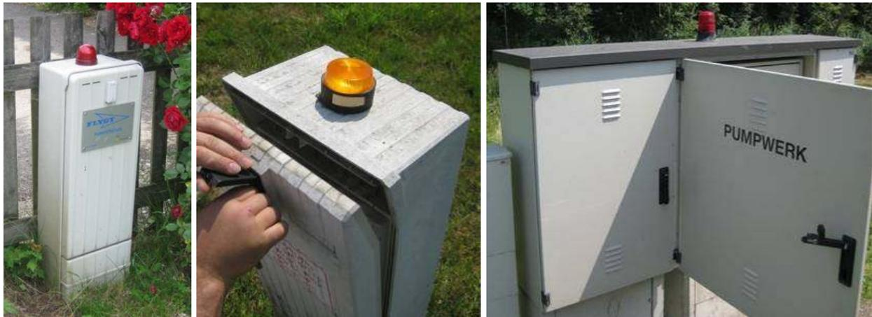
Abbildung 4-36: Drehleuchte zur Signalisierung von Störungen an Schaltkasten angebracht (Schitter)
