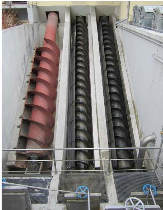
Abbildung 3-19: Schneckenpumpe (Photo: Schitter)
