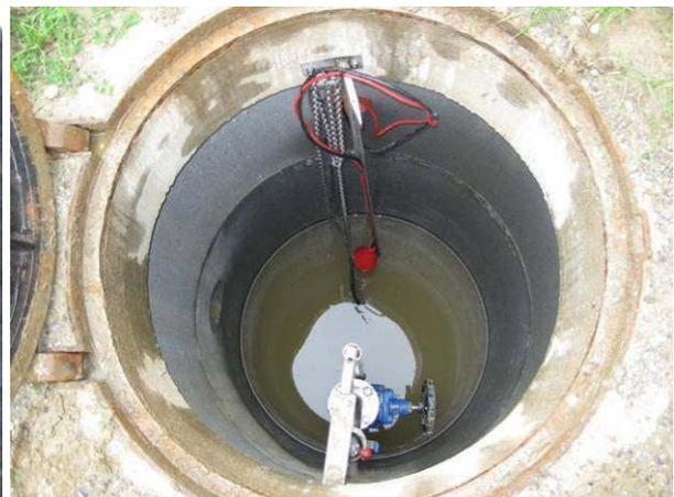
Abbildung 8-4: Pumpstation für Einzelobjekte
