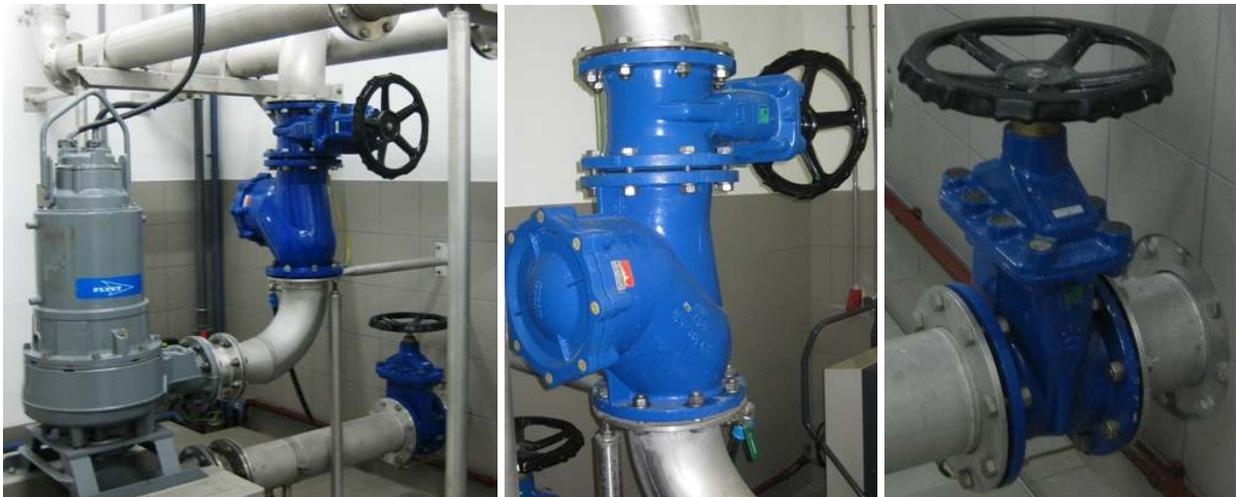
Abbildung 4-32: Armaturen in einer Pumpstation (Schitter)
