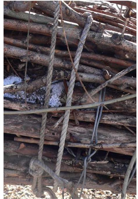
Abbildung 35: Die Holzoberfläche weist bereits nach 5 Jahren im Gebrauch deutliche Gefahrenpunkte auf. Morsche Holzteile und lose (nicht fachgerechte nachträgliche) Verbindungen setzen die Benutzbarkeit stark herab.
