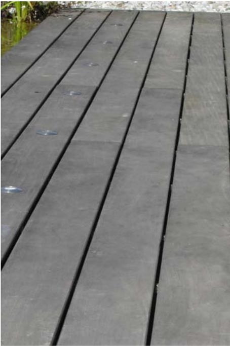
Abbildung 134: Durch die Anwendung eines Clipsystems sind keinerlei Verschraubungen an der Oberseite des Holzdecks sichtbar.
