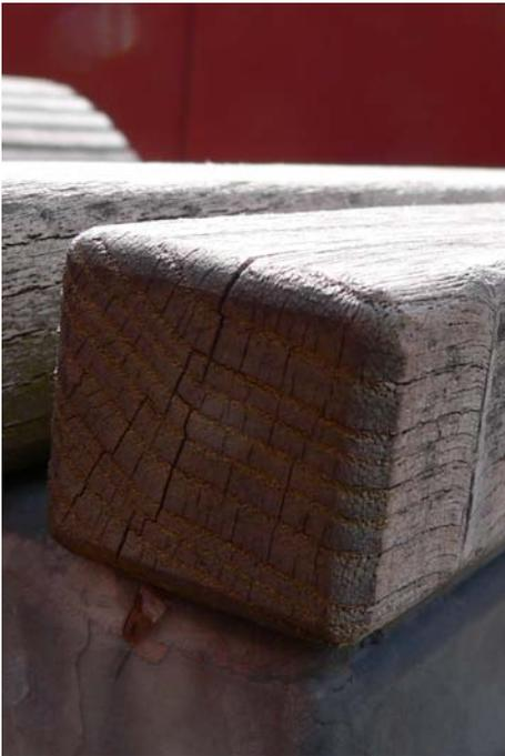
Abbildung 68: Der perfekte konstruktive Holzschutz führt dazu, dass keinerlei Schäden der fünf Jahre alten Objekte festzustellen sind.
