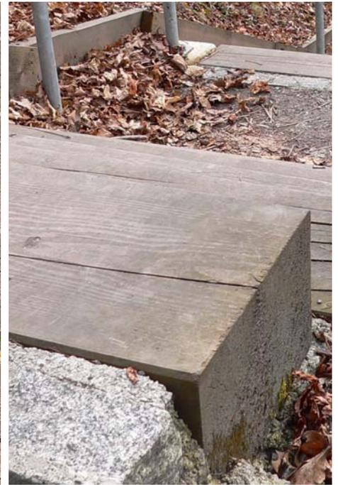
Abbildung 89: + Die auf Fundamenten gebetteten Blockstufen sitzen fest am Beton und geben sicheren Halt.
