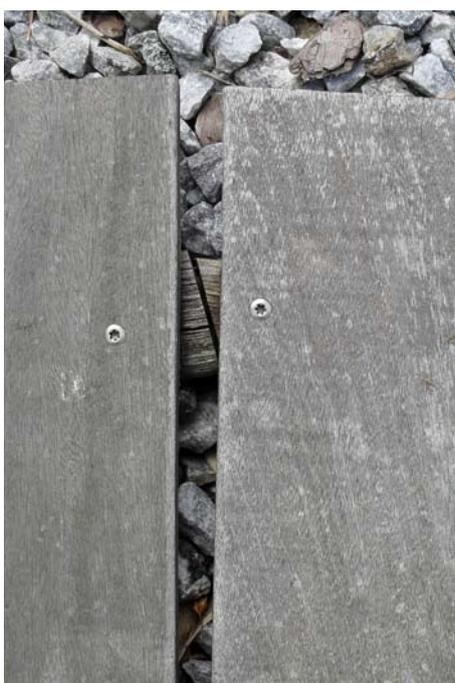
Abbildung 139: -Einige Verschraubungen mussten aus unbekanntem Grund von oben durchgeführt werden, dies vermindert die Ästhetik der Anlage etwas.
