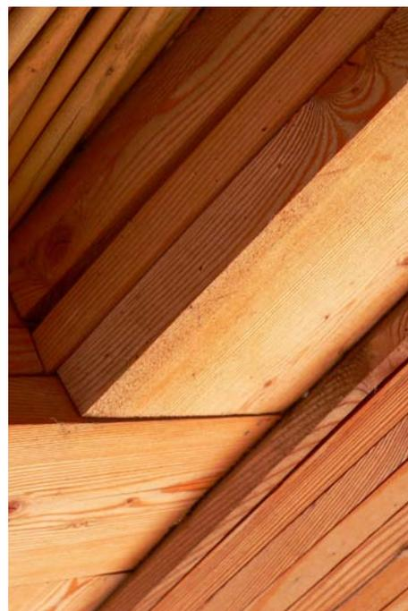
Abbildung 100: Die Holzlatten sind größtenteils nur sporadisch miteinander verschraubt und nur stellenweise verleimt. Dadurch ist nahezu jede Formgebung bei gleichzeitig hoher Belastung möglich.
