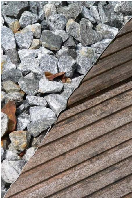
Abbildung 104: Ein großes Holzdeck mit Kiesbeeten charakterisiert den Innenhof. Als Schutz für das Holz wurden Edelstahlleisten zwischen den beiden Materialien eingebracht.
