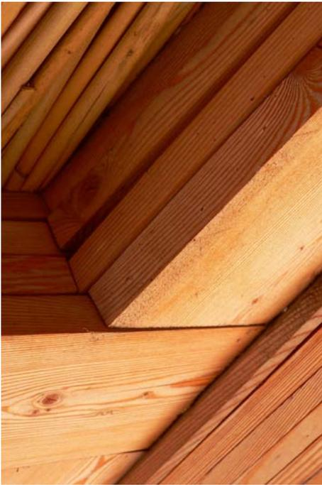
Abbildung 95: Das Konzept der Holzgitterschale besteht größtenteils aus zusammengeschaubten und vor Ort gebogenen Brettern.
