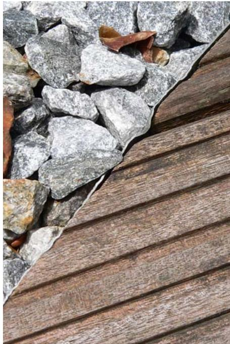
Abbildung 109: + Die Stahlkante zwischen Holzdeck und Edelbruch schützt die empfindlichen Holzkanten.
