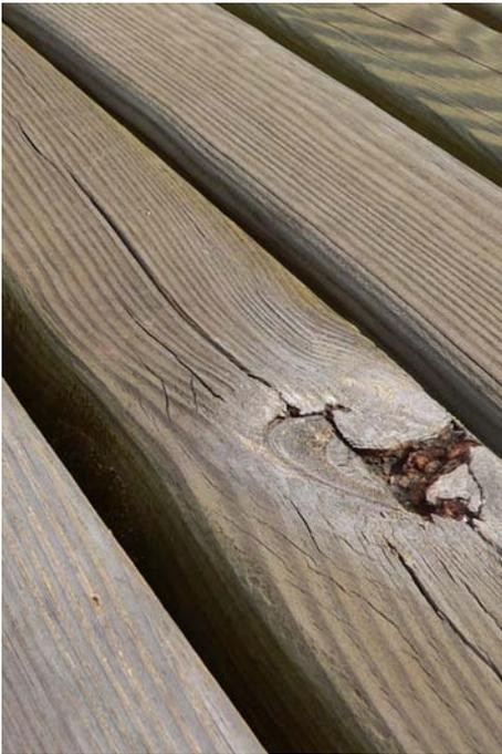
Abbildung 57: Die Holzoberfläche ist prinzipiell in einem sehr gutem Zustand, leider wurden bei der Aussortierung der Holzteile einige wenige offensichtliche Schwachstellen übersehen.
