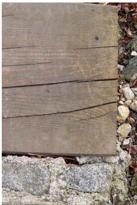
Abbildung 91: - Die Treppen wurden etwas zu seicht ins Gelände gebaut, dadurch kann anfallendes Laub und Erdmaterial zu starken Verunreinigungen und evtl. erhöhter Rutschigkeit führen.
