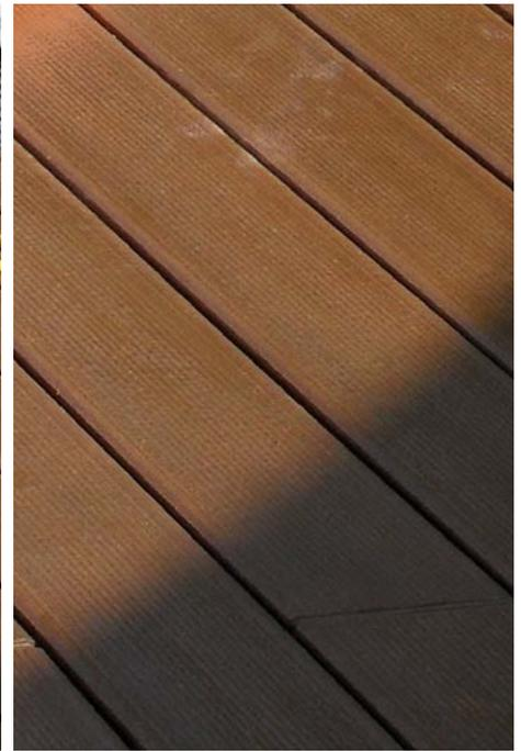
Abbildung 146: Die Form- und Farbbeständigkeit der WPC-Elemente lässt sich nach zwei Jahren im Außeneinsatz als äußerst gut bewerten.
