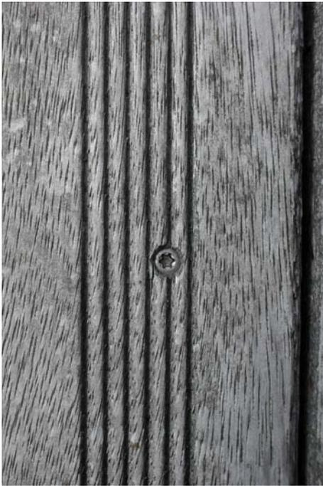
Abbildung 124: Die Verschraubungen an der Oberseite dienen als Speicher anfallenden Wassers und Schmutzes.
