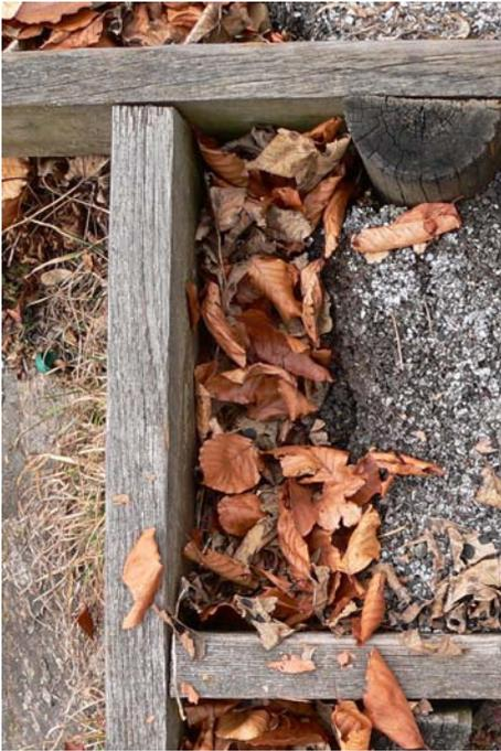
Abbildung 77: Durch ausgeschwemmten Splitt entstehen stellenweise einige Zentimeter tiefe Löcher, in denen sich Wasser und eingeschwemmtes Material sammeln. Hier werden die Holzteile stark in Mitleidenschaft gezogen.
