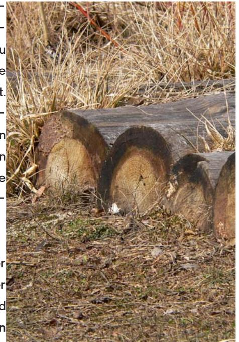
Abbildung 26: Die stark verpilzten Holzstämmen verfügen aufgrund der guten Dimensionierung noch immer über ausreichend Stabilität.
