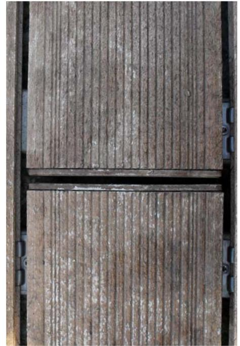
Abbildung 143: Die Enden der Dielen wurden mit speziellen Kunststoffabdeckungen bestückt.
