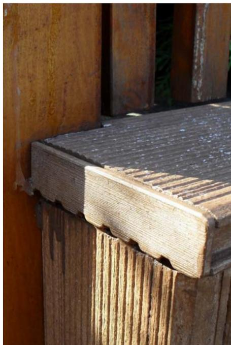
Abbildung 148: - Die abgekratzte Oberfläche vermindert die Optik des Decks an den behandelten Stellen drastisch.
