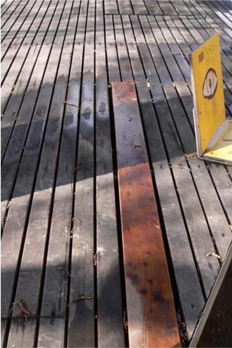
Abbildung 46: Trotz des prinzipiell guten Zustandes des Decks mussten einzelne Bretter bereits ausgetauscht werden. Leider wurde nicht auf einen adäquaten Ersatz geachtet.
