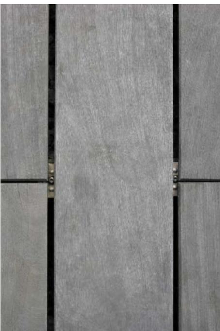
Das ausreichende Gefälle und der gut gewählte Abstand der Holzteile zueinander erfüllen den Zweck des konstruktiven Holzschutzes völlig ausreichend, dadurch wurde dieser unauffällig aber wirkungsvoll in das Bauwerk eingebracht.
