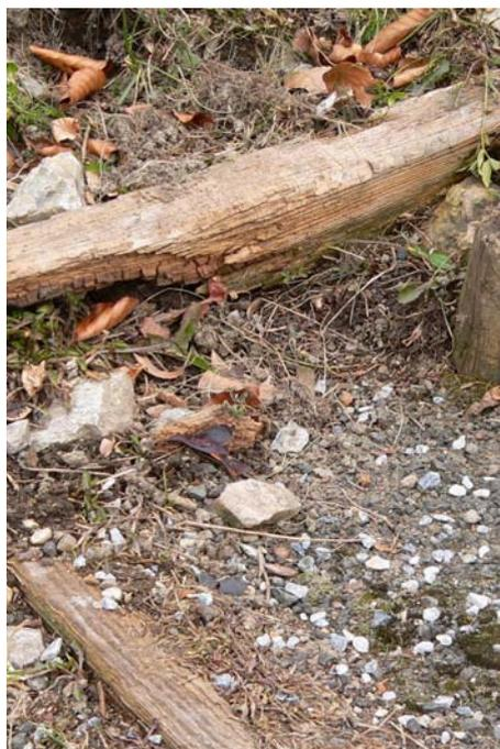
Abbildung 82: - Die mangelnde Pflege, wie etwa das unterlassene Auffüllen der Trittplächen mit Kies, setzt die Haltbarkeit der Treppe zusätzlich herab.
