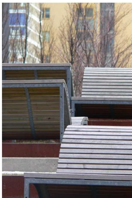
Abbildung 73: - Zwischen Holz- und Metallteilen wurde auf einen Kunststoffabstandshalter vergessen, dadurch hätte sich die Haltbarkeit zusätzlich erhöht.
