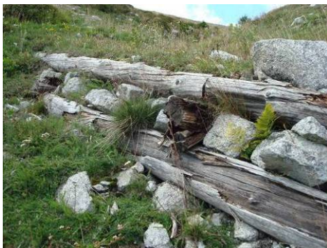
Abbildung 7474: Splintholz der Rundhölzer zum größten Teil zersetzt, Äußerer Kuhleitengraben, 08/2010
