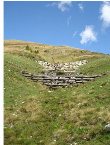
Abbildung 6565: Ansicht des Inneren Kuhleitengrabens unterhalb des oberen Weges, 14 Jahre nach der Sanierung, 08/2010
