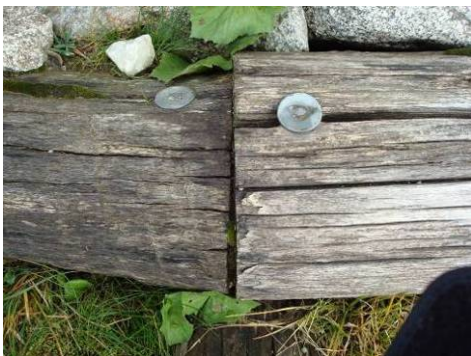
Abbildung 6767: Vernagelung der auf Stoß verlegten Längshölzer, Innerer Kuhleitengraben, 08/2010
