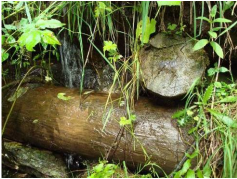
Abbildung 3434: Hinterspülung Sperre 3, Murtal Ulten, 08/2010
