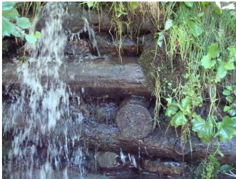
Abbildung 8888: Abflusssektion mit weggespültem oberstem Rundholz, Seitengraben Pitzbach Rojen, 09/2010
