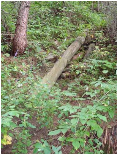
Abbildung 3535: linke Schulter teilweise übermurt und generell in schlechtem Zustand, Murtal Ulten, 08/2010
