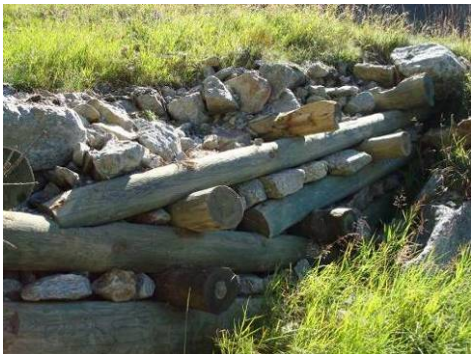
Abbildung 5252: Durch Steinschlag beschädigt linke Schulter der Sperre 4, Kompatschgraben Plawenn, 08/2010
