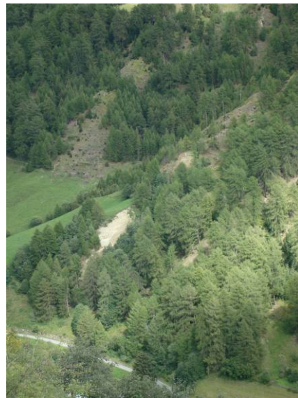
Abbildung 5757: Gesamtansicht von Standort 4, Wötzelgraben Matsch, 23 Jahre nach der Sanierung, 08/2010
