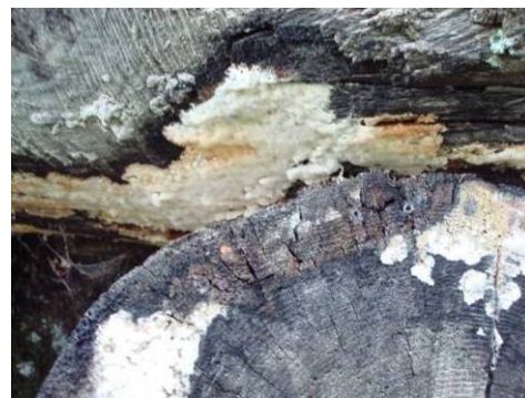
Abbildung 6161: Sperrenkörper Nr. 8 am rechten Rand in einem besseren Zustand, jedoch starker Pilzbefall, Wötzelgraben Matsch, 08/2010
