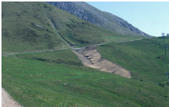
Abbildung 6464: Ansicht von Standort 5 Innerer Kuhleitengraben, kurz nach der Sanierung 1996
