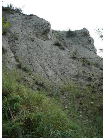
Abbildung 8080: Abbruchkante an der linken Grabenflanke, Schlossgraben Matsch, 08/2010
