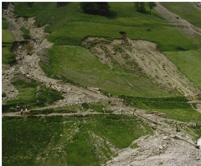
Abbildung 3838: Gesamtansicht Standort 2 Pradamuns Planeil, vor der Sanierung, nach einem Unwetter im Mai
