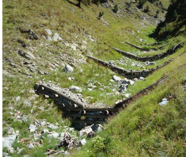
Abbildung 4949: Holzsperrren aus imprägnierter Kiefer im bearbeiteten nördlichen Kompatschgraben, Kompatschgraben Plawenn, 08/2010
