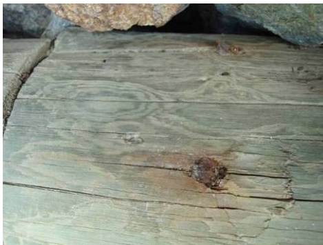
Abbildung 5050: Detail Vernagelung überblatteter Rundhölzer aus imprägnierter Kiefer, Kompatschgraben Plawenn, 08/2010
