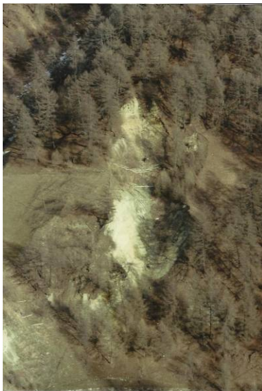
Abbildung 5656: Gesamtansicht von Standort 4, Wötzelgraben Matsch, kurz nach der Sanierung, 1987
