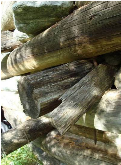
Abbildung 4040: dezentral vernageltes Querholz, Pradamuns Planeil, 08/2010
