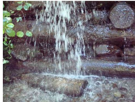
Abbildung 8888: Abflusssektion mit weggespültem oberstem Rundholz, Seitengraben Pitzbach Rojen, 09/2010
