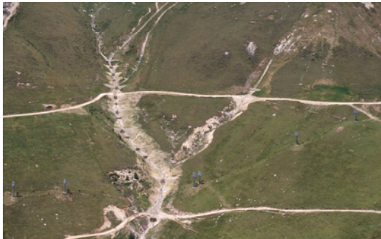
Abbildung 7171: Gesamtansicht von Standort 6 Äußerer Kuhleitengraben, nach der Sanierung des äußeren Grabens 1990
