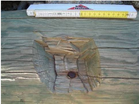
Abbildung 5151: Detail Vernagelung der Längshölzer mit den Rundhölzern, Kompatschgraben Plawenn, 08/2010
