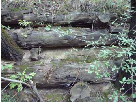
Abbildung 8282: Sperre mit Erdmaterial verfüllt, Schlossgraben Matsch, 08/2010
