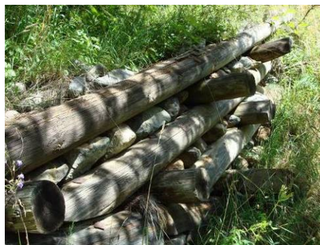
Abbildung 4242: Risse an Rundholz 1 der linken Schulter, Pradamuns Planeil, 08/2010
