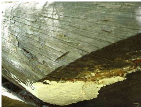
Abbildung 4343: Pilzbefall an Rundholz 1 der rechten Schulter, Pradamuns Planeil, 08/2010
