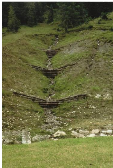
Abbildung 8585: Gesamtansicht Standort 8, Seitengraben Pitzbach Rojen, kurz nach der Sanierung, 1984
