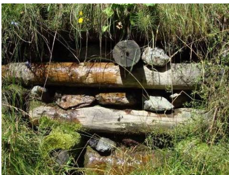
Abbildung 4141: Sperrenkörper in optisch sehr gutem Zustand, Pradamuns Planeil, 08/2010
