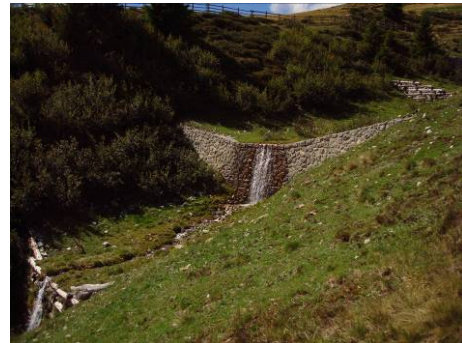
Abbildung 7272: Ansicht des äußeren Kuhleitengrabens unterhalb des oberen Weges, 10 Jahre nach der Sanierung, 08/2010
