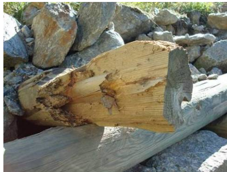
Abbildung 5252: Durch Steinschlag beschädigt linke Schulter der Sperre 4, Kompatschgraben Plawenn, 08/2010
