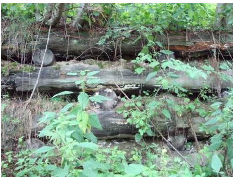
Abbildung 6161: Sperrenkörper Nr. 8 am rechten Rand in einem besseren Zustand, jedoch starker Pilzbefall, Wötzelgraben Matsch, 08/2010
