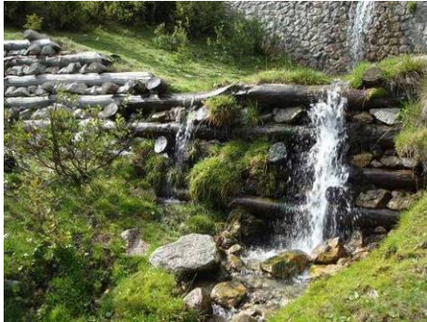
Abbildung 7373: Parallel verlaufende aufgesetzte Schultern mit abgestuften Rundhölzern, Äußerer Kuhleitengraben, 08/2010
