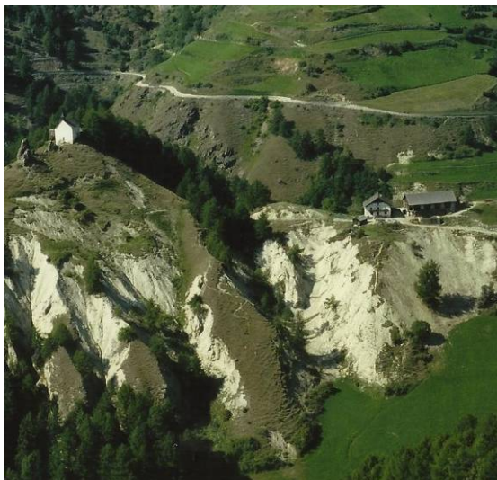
Abbildung 7777: Gesamtansicht von Standort 7, Schlossgraben Matsch, kurz nach der Sanierung, 1986
