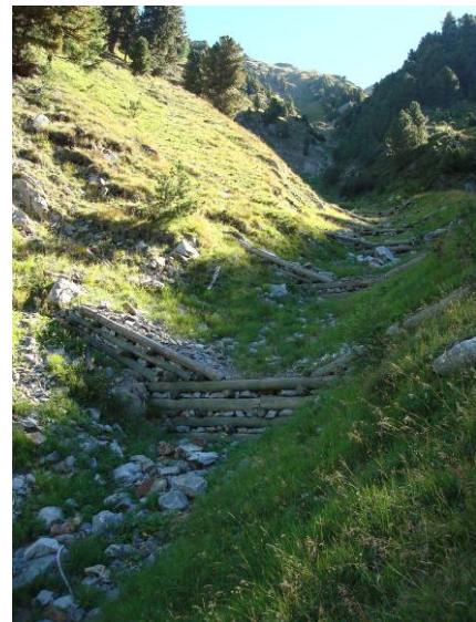
Abbildung 4747: Ansicht von Standort 3 Kompatschgraben Plawenn, 26 Jahre nach der Sanierung, 08/2010
