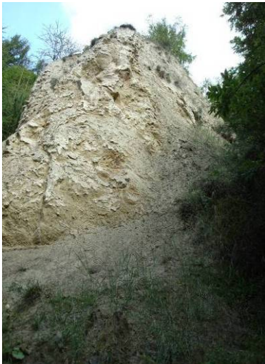
Abbildung 7979: Laufend erodierende Abbruchkante an der rechten Grabenflanke, Schlossgraben Matsch, 08/2010
