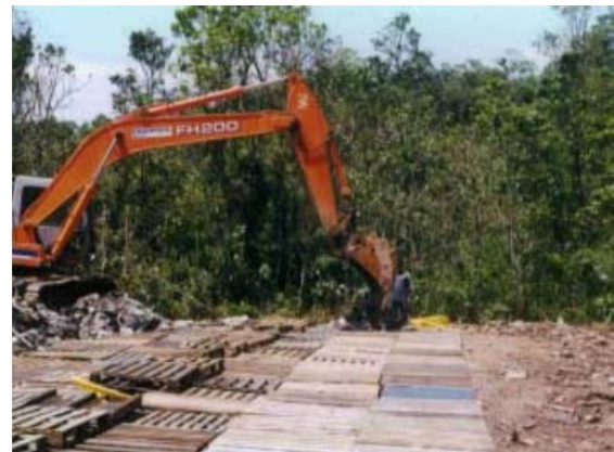
Abb. 31: Aufsetzen der Mieten auf Paletten mit einem Hydraulikbagger mit Tieflöffel (nach SCHENK, 2002)
