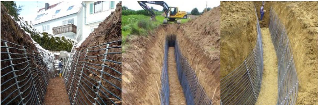
**Abbildung 64:** Darstellung von Grabenkollektoren. Quelle: <http://www.elektroheinle.com/referenz.html> (links), <http://www.nick-leonberg.de/grabenkollektor.htm> (in der Mitte) und <http://www.elektrotechnik-held.de/erdkollekt.htm> (23.01.2012) (rechts)
