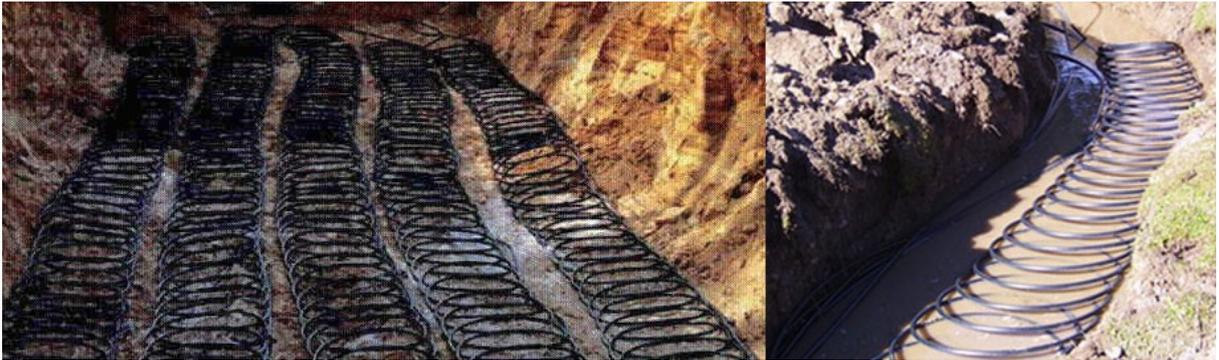
**Abbildung 65:** Darstellung von Spiralkollektoren. Quelle: <http://www.haustechnikdialog.de/SHKwissen/1194/Spiralkollektor> (links) und <http://www.supergruen.at/Produktkatalog/Erdwaerme-Geothermie/SG-Spiralkollektor/>(23.01.2012) (rechts)
