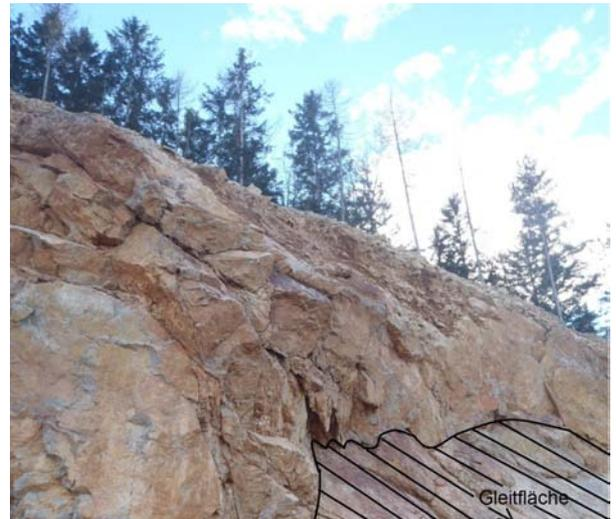
Abb. 10: Felsböschung mit Gleitfläche (photogr. RABL-HOFBAUER, E., 27-11-2011)
