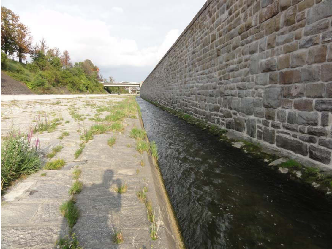
Abbildung 42: Aufnahme­fläche 4.1 am Wienfluss auf Höhe der U-Bahn-Station Ober Sankt Veit (flussabwärts): Der Fluss verläuft entlang einer zirka sechs Meter hohen Mauer. Wien/Penzing, 4.8.2011
