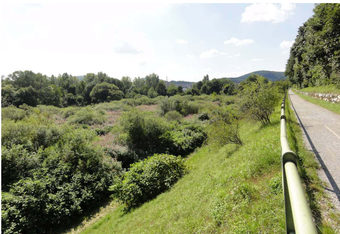
Abbildung 7: Retentionsbecken bei Wien/Hadersdorf, Perspektive flussaufwärts, 2. 8. 2011
